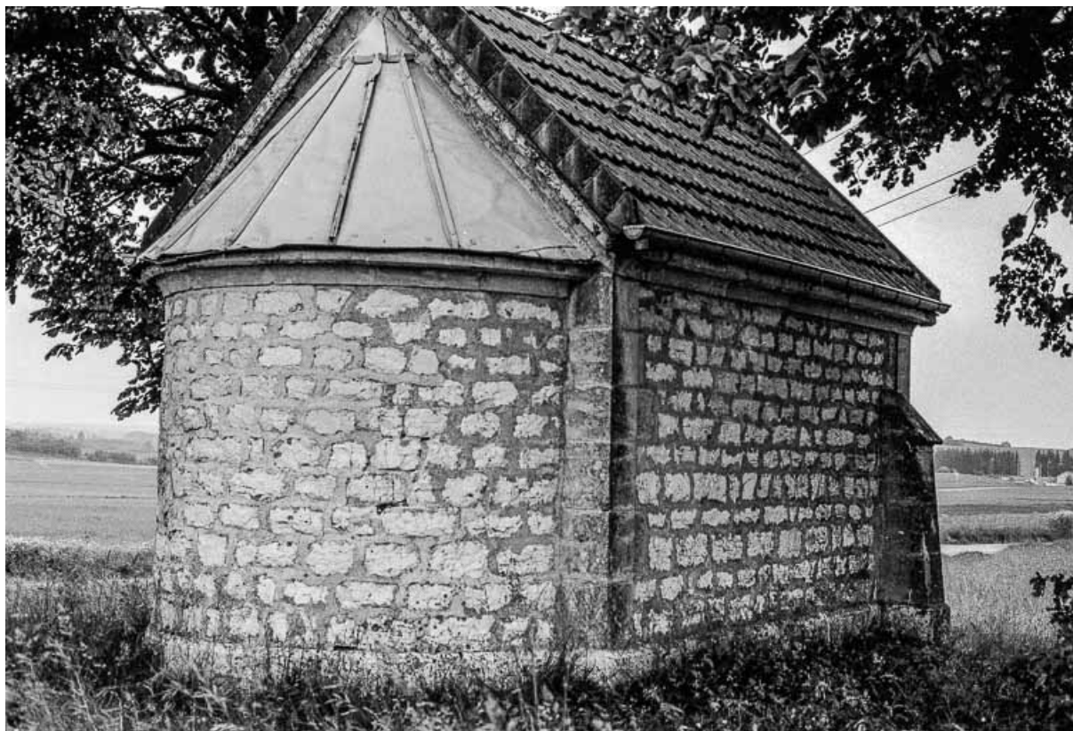
Chevet et façade latérale gauche.
