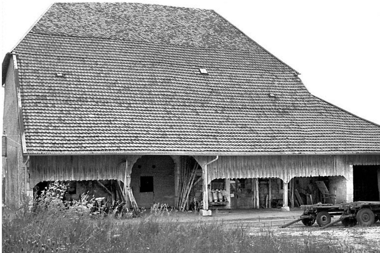
Vue du mur long-pan sur rue.
