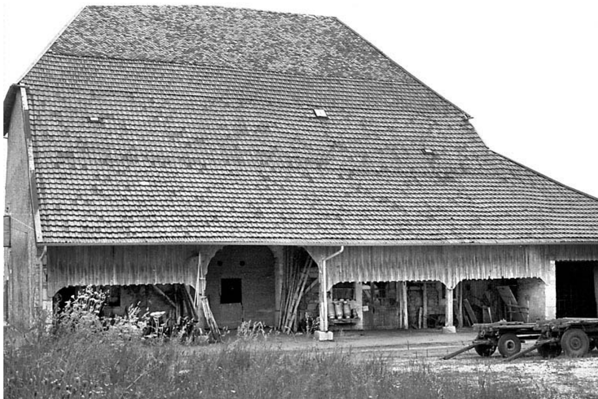
Vue du mur long-pan sur rue.
