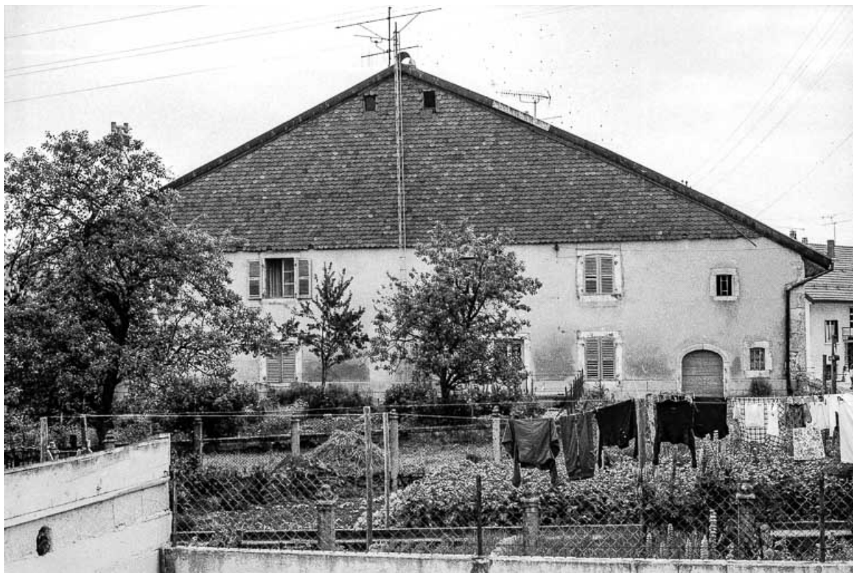
Ferme située 1 rue des Contours, datée des 18e et 19e siècles : façade antérieure. 25, Frasne
