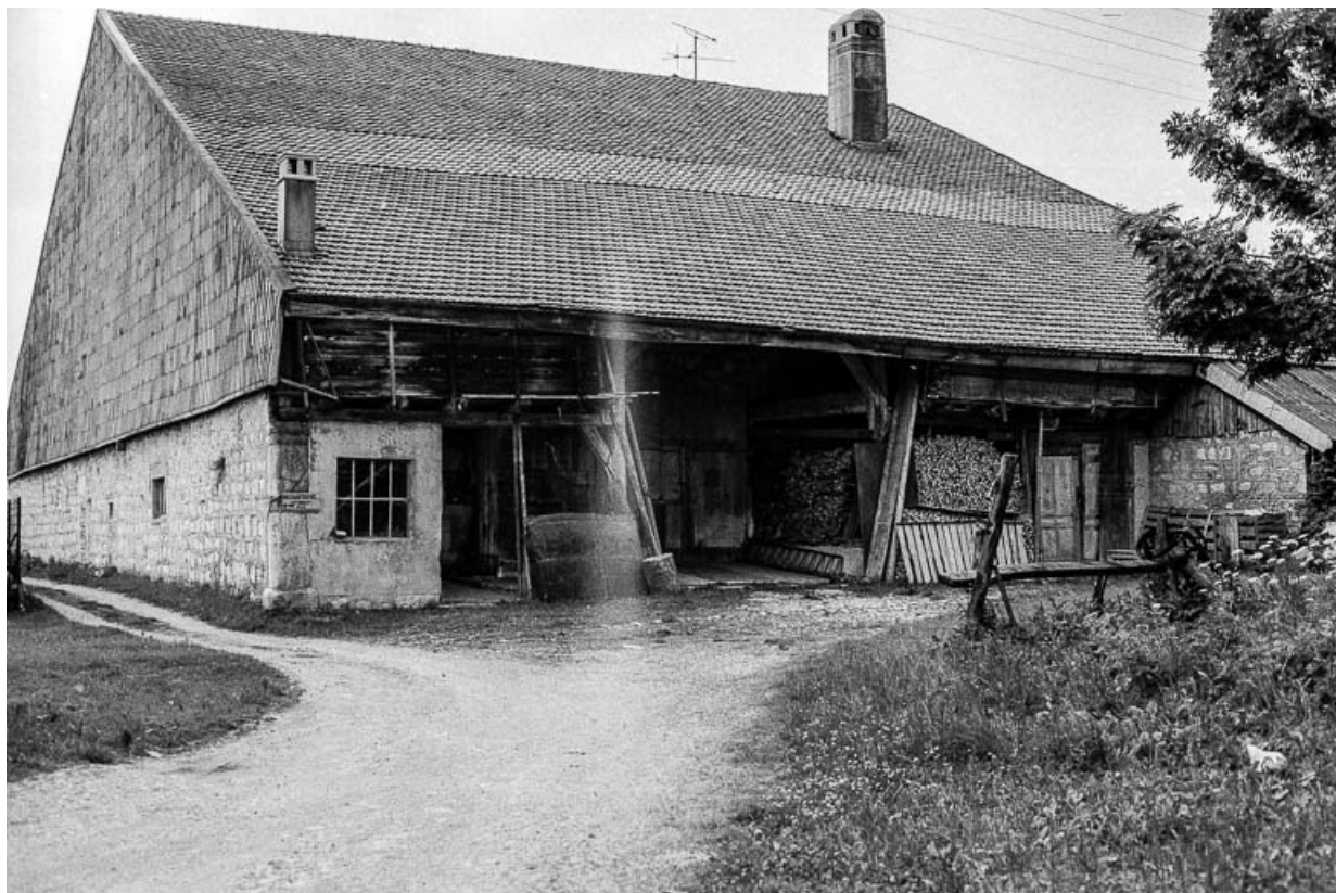
Ferme cadastrée 1975 F1 84-86, datée des 18e et 19e siècles : façade latérale gauche. 25, Frasne
