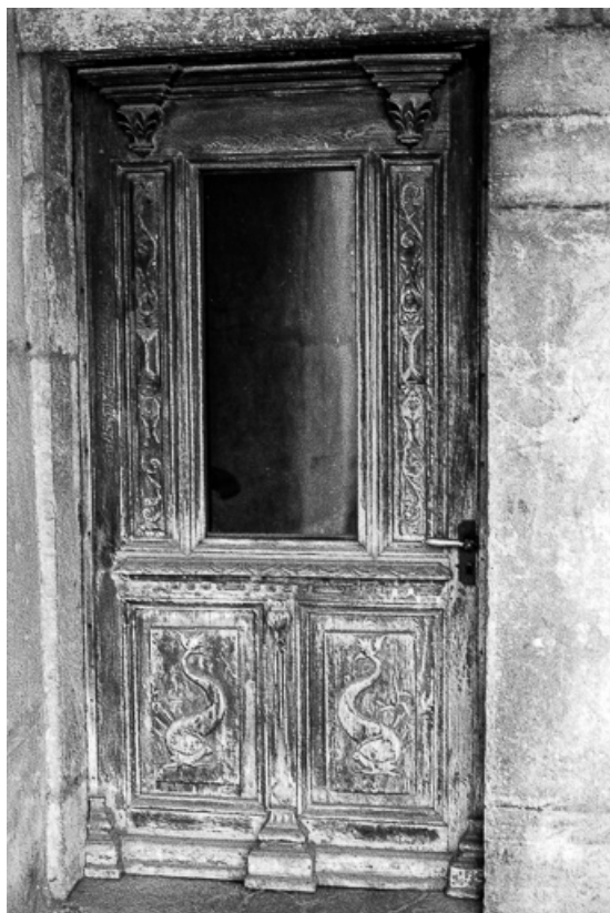
Ferme située 1 rue des Contours, datée des 18e et 19e siècles : une porte. 25, Frasne
