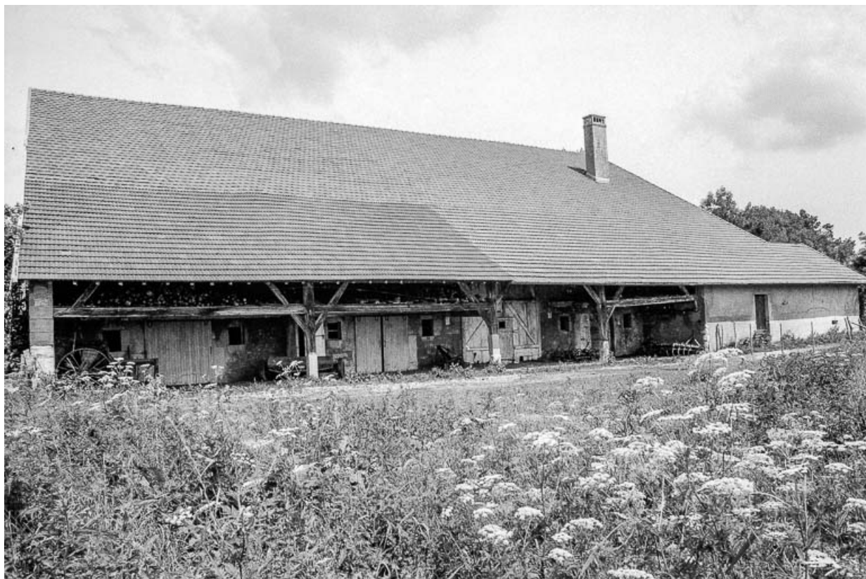
Ferme cadastrée 1937 A 51, datée de 1868 : façade latérale droite. 25, Frasne
