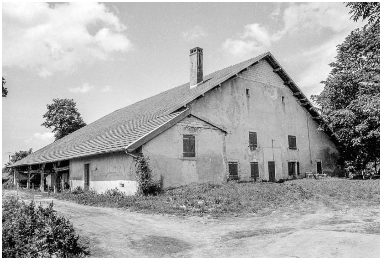
Ferme cadastrée 1937 A 51, datée de 1868 : façades antérieure et latérale droite. 25, Frasne
