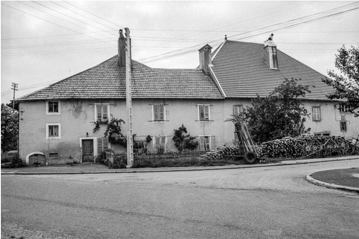
Ferme datée de 1797 : vue d'ensemble. 25, Frasne
