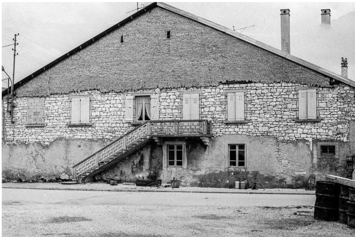
Ferme située 1 rue des Contours, datée des 18e et 19e siècles : façade postérieure. 25, Frasne
