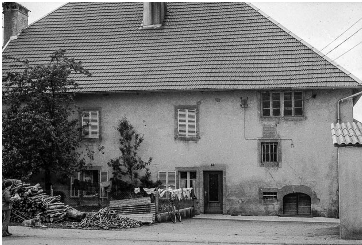
Ferme datée de 1797 : façade antérieure. 25, Frasne
