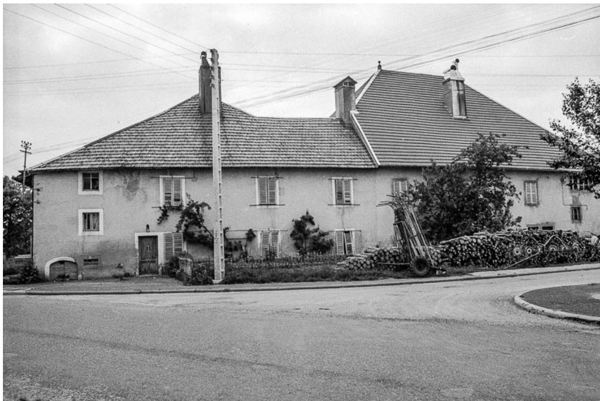
Ferme datée de 1797 : vue d'ensemble. 25, Frasne
