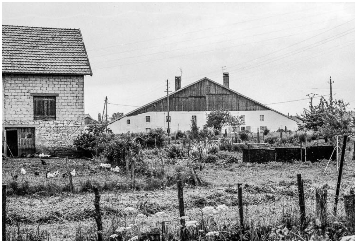
Ferme cadastrée 1975 F1 84-86, datée des 18e et 19e siècles : façade antérieure. 25, Frasne
