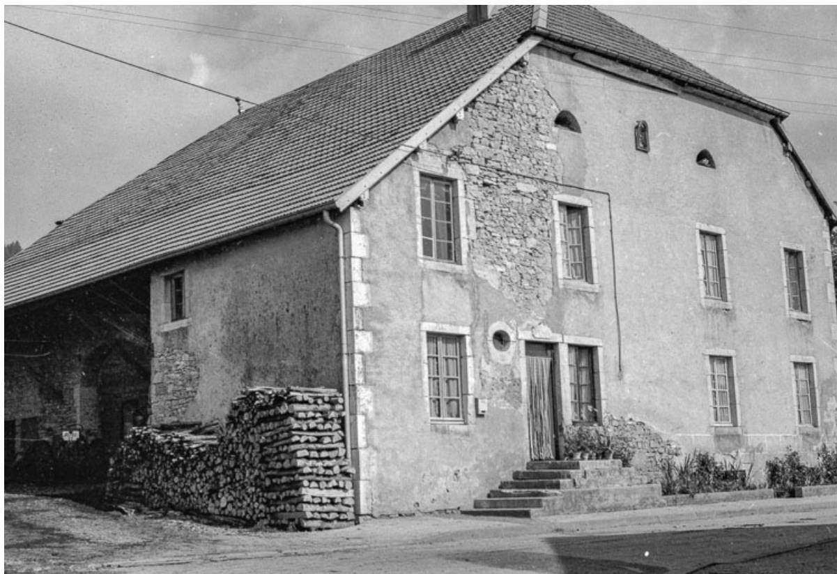
Façades antérieure et latérale gauche. 25, Évillers rue du Bois du Désert
