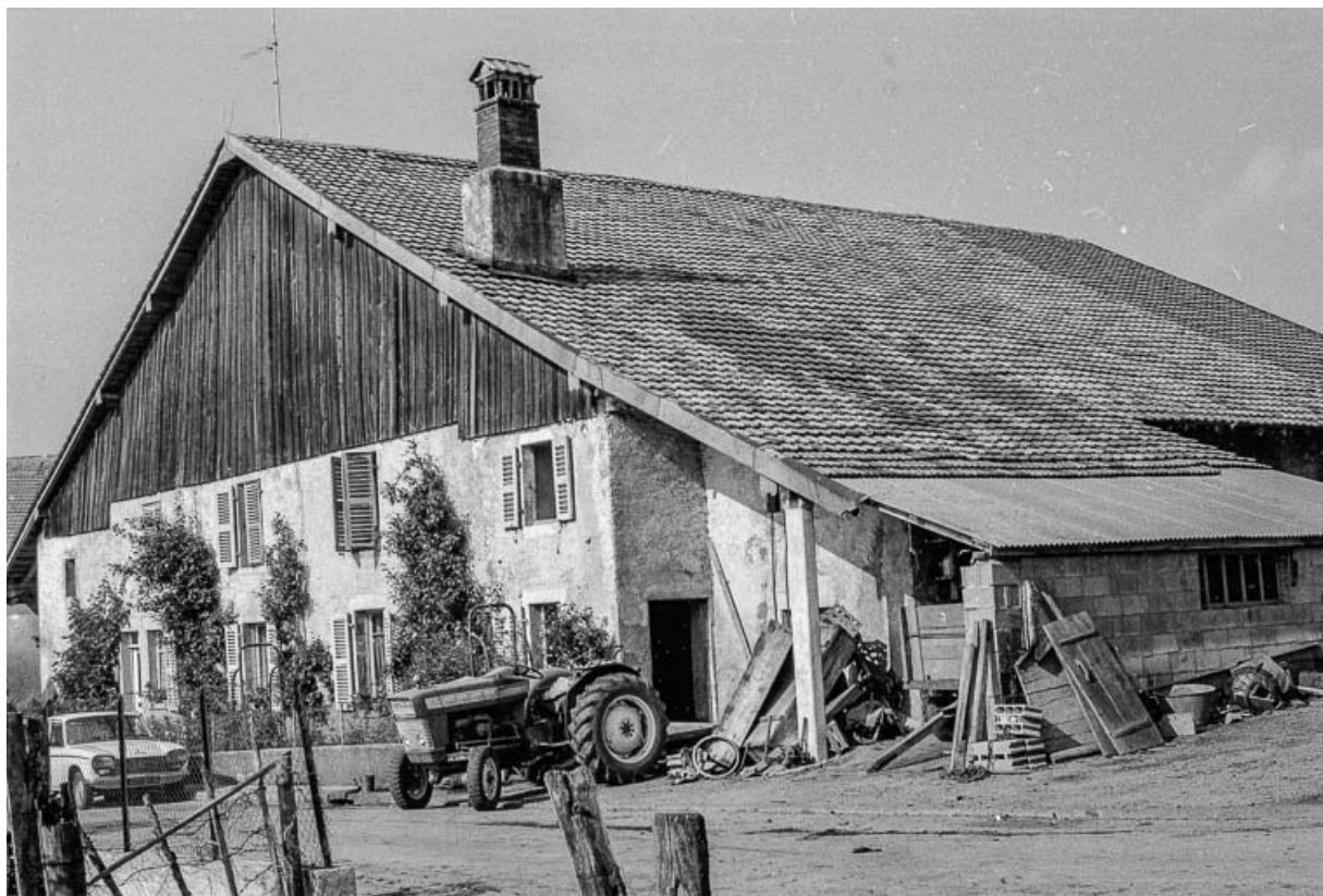
Pignon d'habitation et gouttereau postérieur. 25, Évillers rue du Mont
