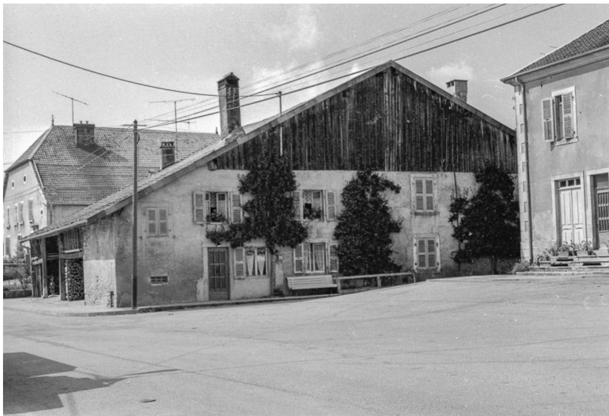
Façades antérieure et latérale droite.
