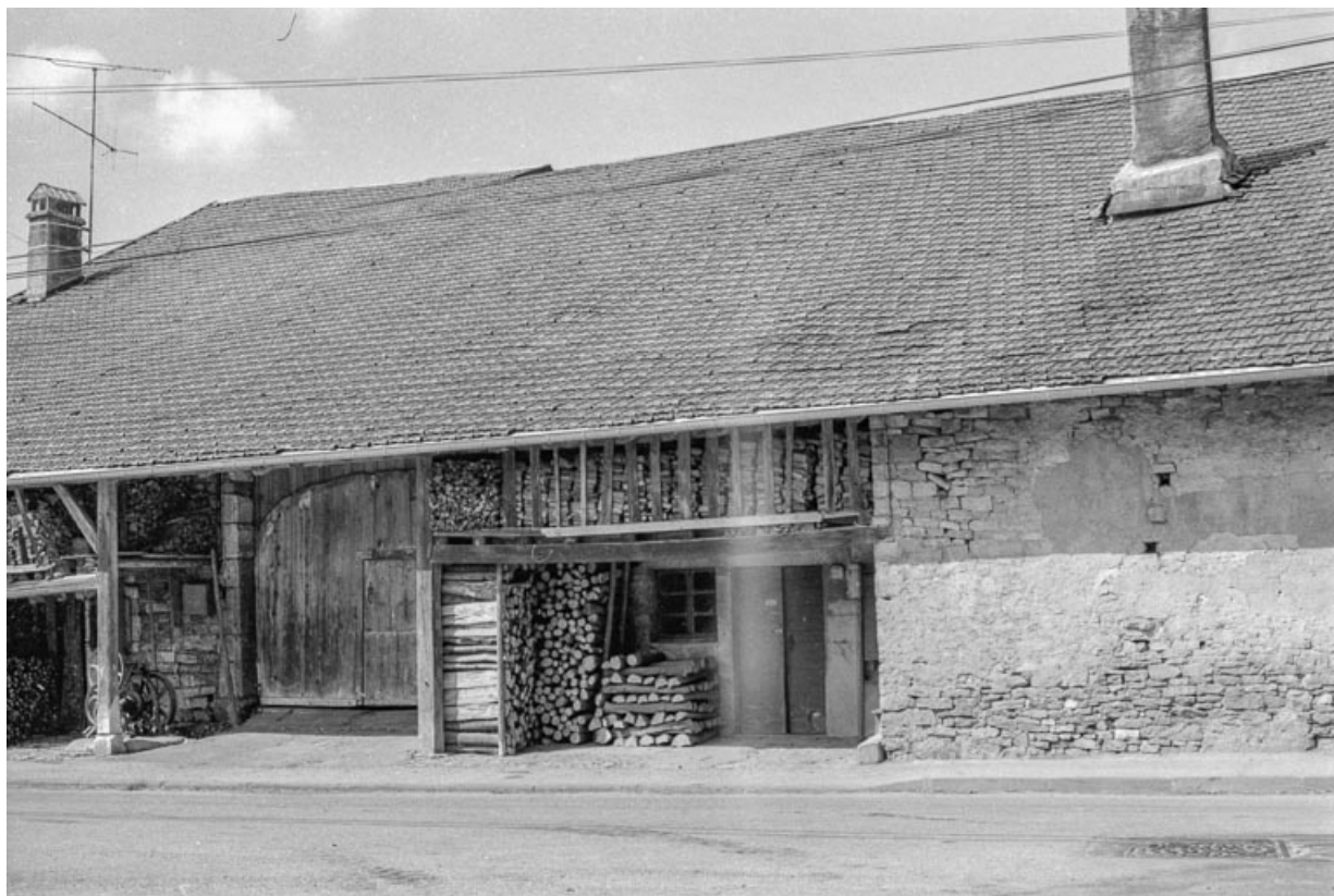
Détail de la façade sur rue.
