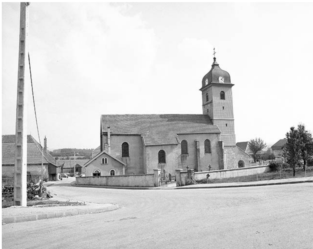
Extérieur : face latérale nord.
