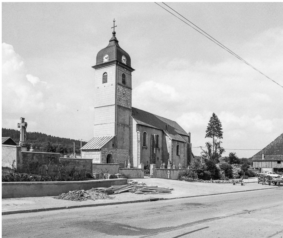
Extérieur : faces sud et ouest.
