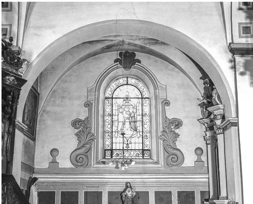
Baie de la chapelle nord. 25, Évillers rue de l'Église
