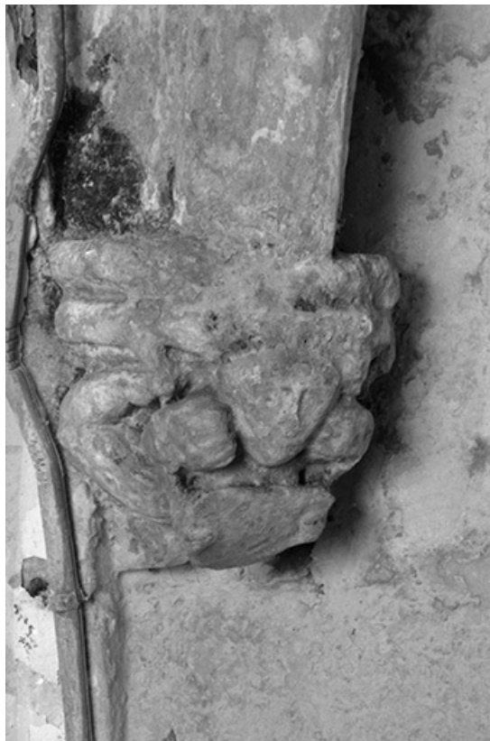
Culot du rez-de-chaussée de la tour-clocher.
