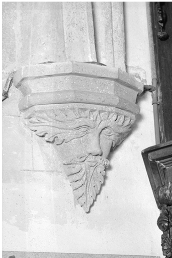
Culot. 1ère travée du chœur. Mur nord. 25, Dompierre-les-Tilleuls Grande Rue
