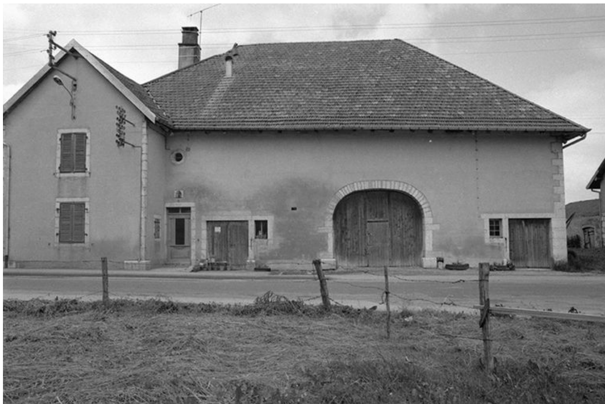
Ferme située 13 Grande Rue, datée de 1857 : façade antérieure. 25, Dompierre-les-Tilleuls
