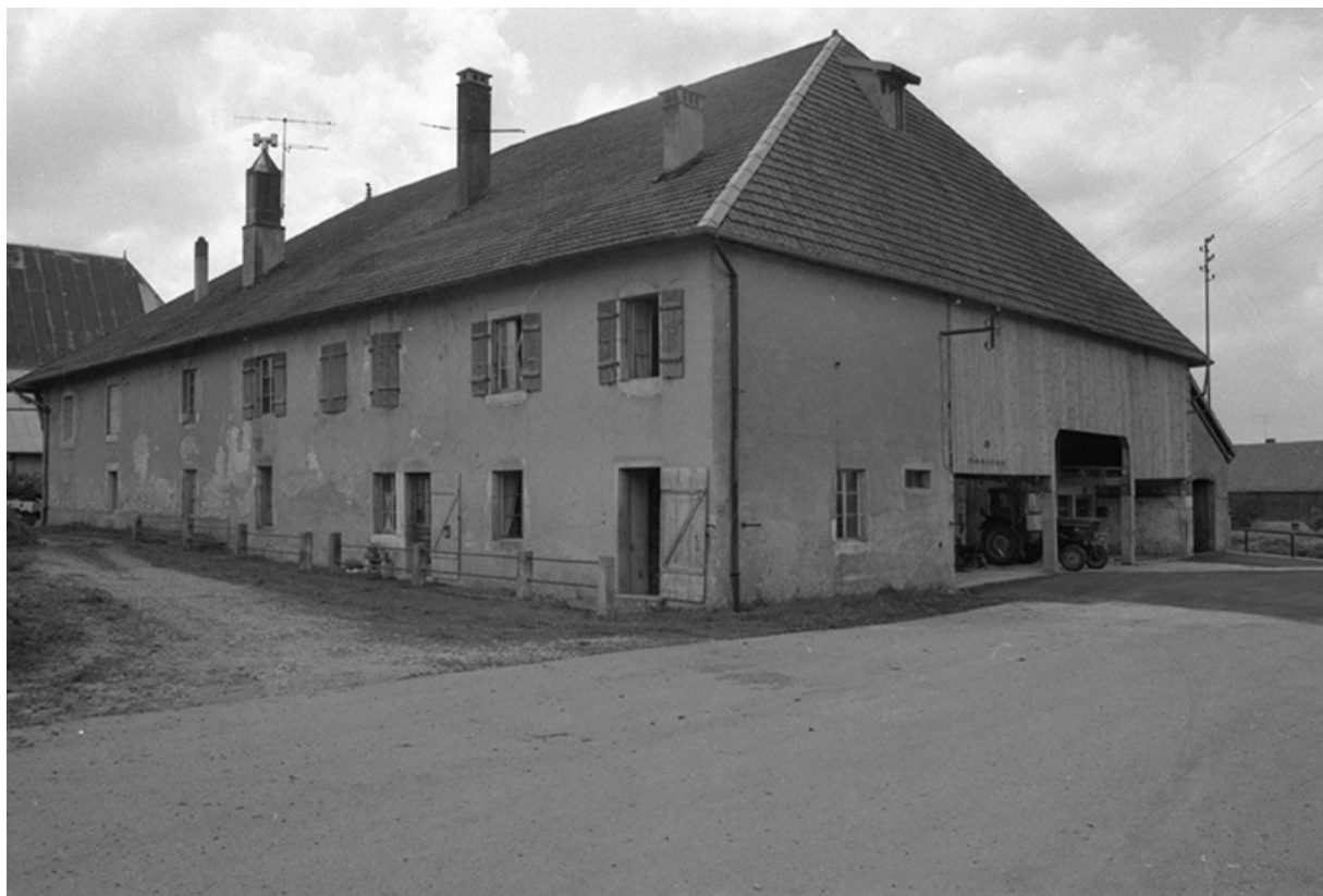
Ferme cadastrée 1934 C 126-127, située rue de la Chapelle, datée de 1748 : vue de trois quarts droit. 25, Dompierre-les-Tilleuls
