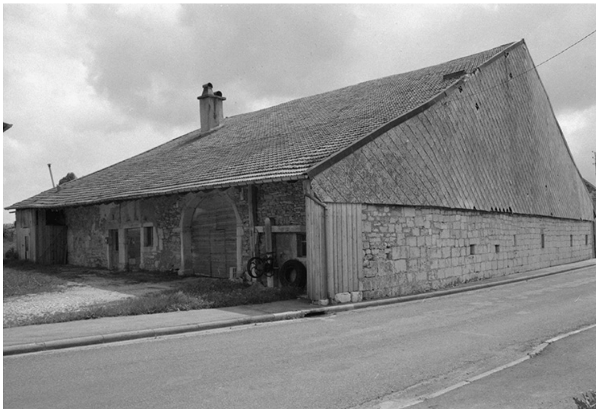
Ferme cadastrée 1934 C 106-107, datée de 1768 : façade latérale droite sur rue. 25, Dompierre-les-Tilleuls
