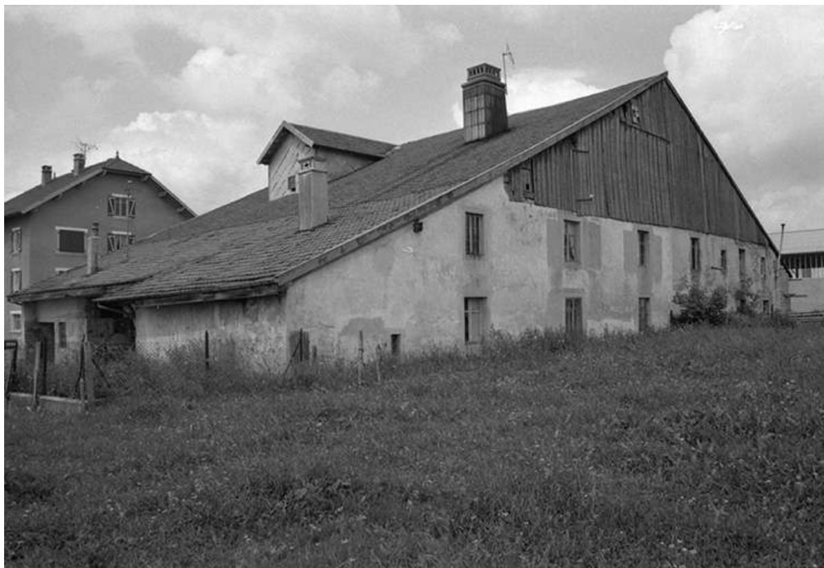
Ferme cadastrée 1934 C 106-107, datée de 1768 : façade latérale gauche. 25, Dompierre-les-Tilleuls
