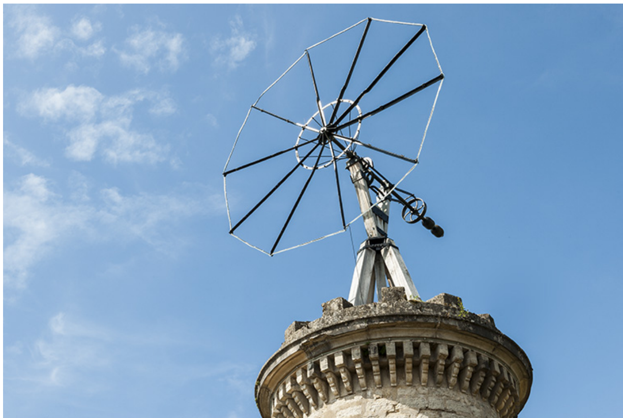
Structure supérieure : roue motrice ou hélice éolienne.
