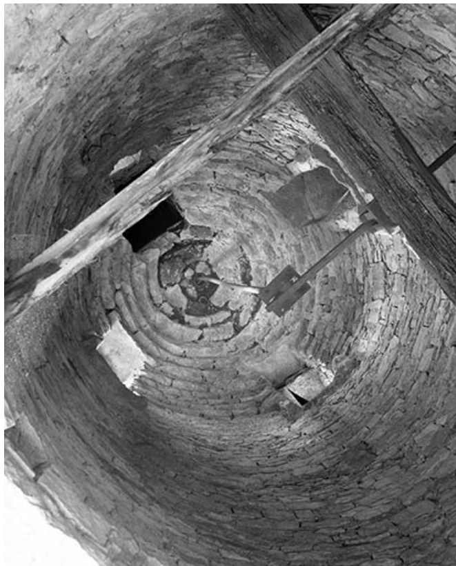
Intérieur de la tour : coupole et arbre. 25, Courvières rue de Cuvier
