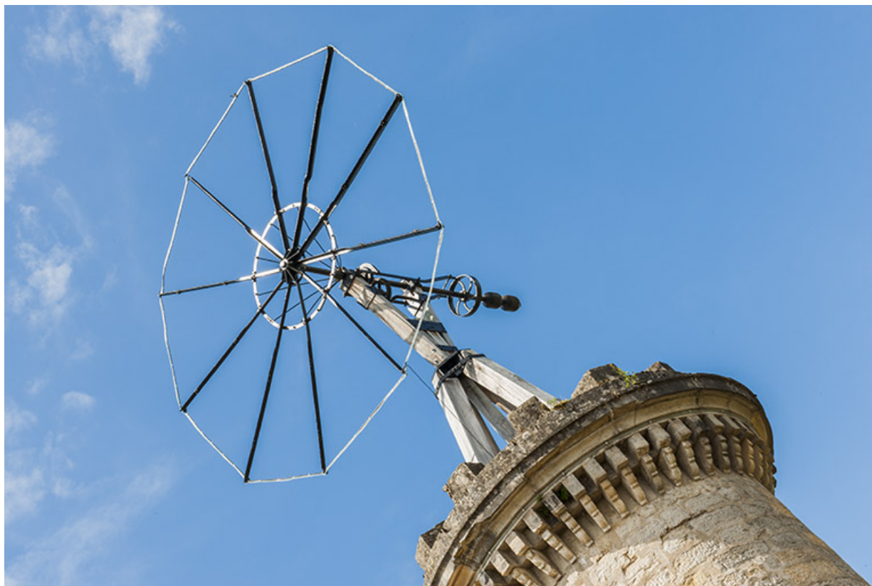
Structure supérieure : roue motrice ou hélice éolienne.
