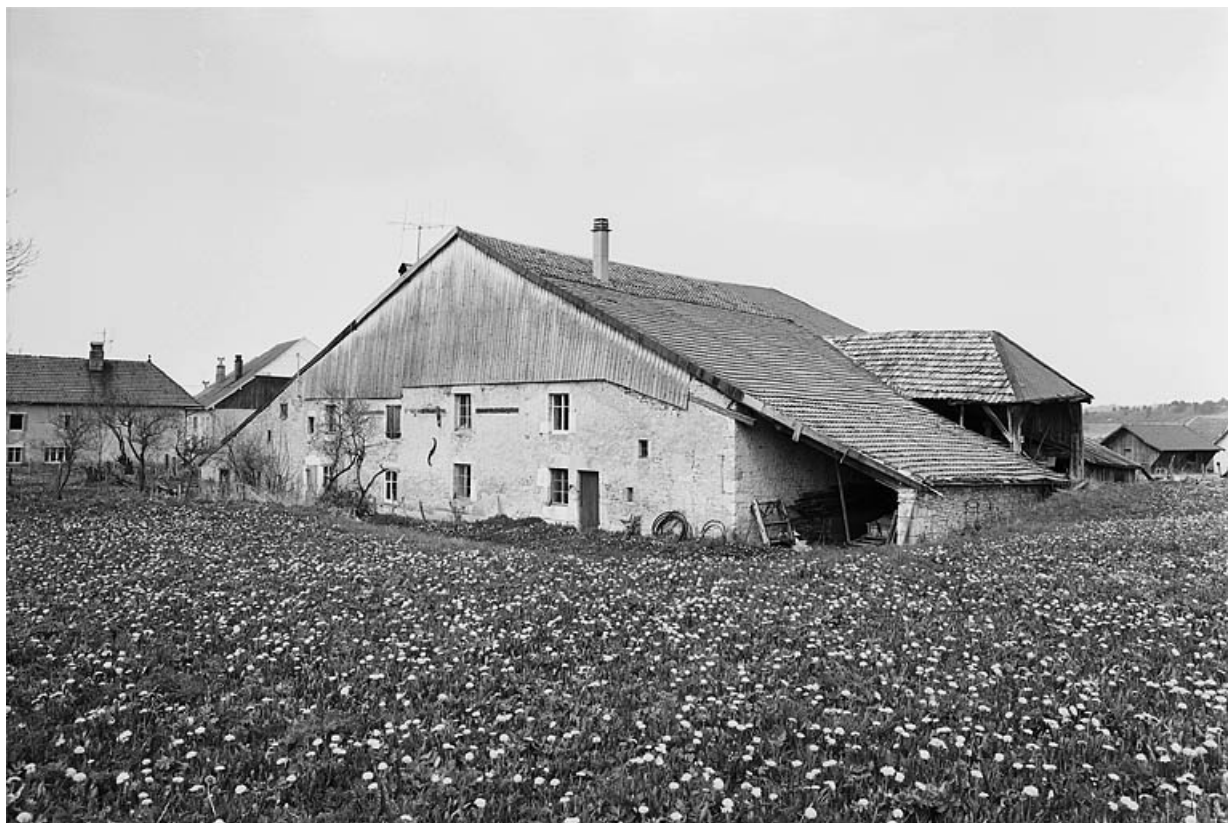
Extérieur : pignon de l'habitation et goutterot postérieur.
