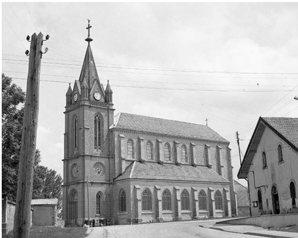
Tour-clocher et façade latérale sud. 25, Courvières, lieudit : route de Salins
