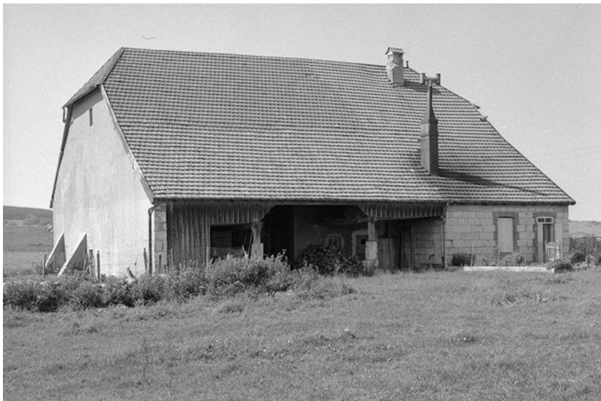
Ferme située rue de Cuvier, cadastrée 1975 ZE 2a, datée du 19e siècle : façade antérieure et latérale gauche. 25, Courvières
