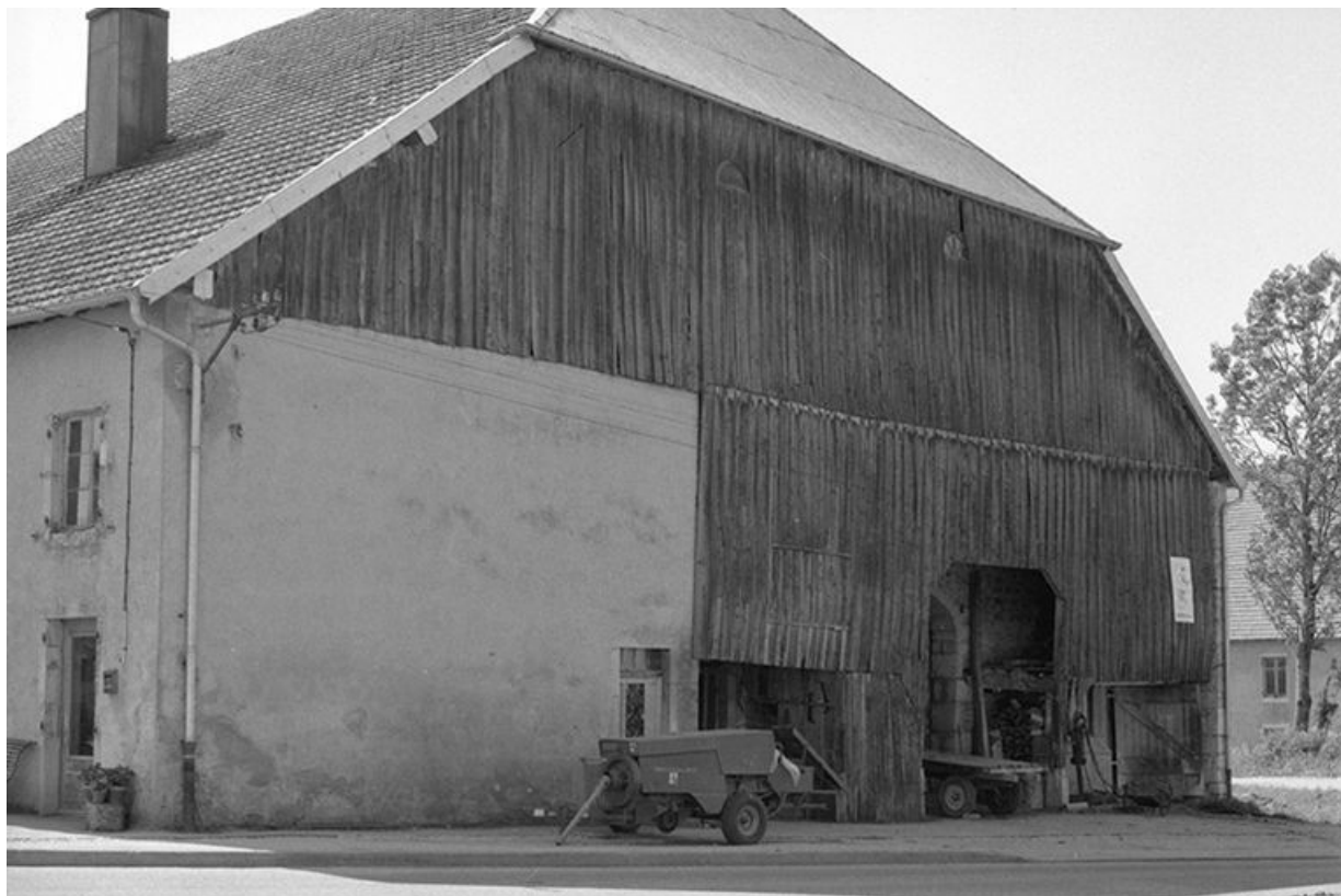
Ferme située route de Salins, cadastrée 1975 ZE 16, datée de 1870 : façade latérale droite sur rue. 25, Courvières
