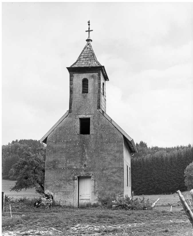
Vue extérieure : façade antérieure.
