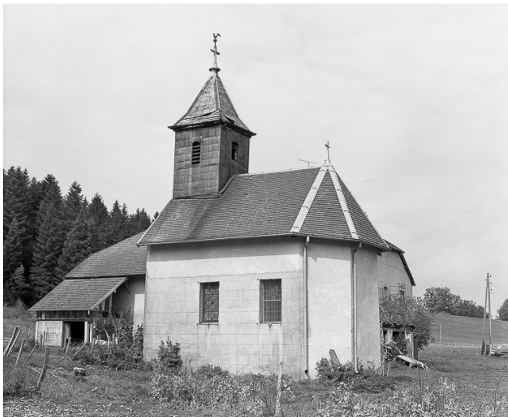
Vue extérieure : abside et face latérale droite.
