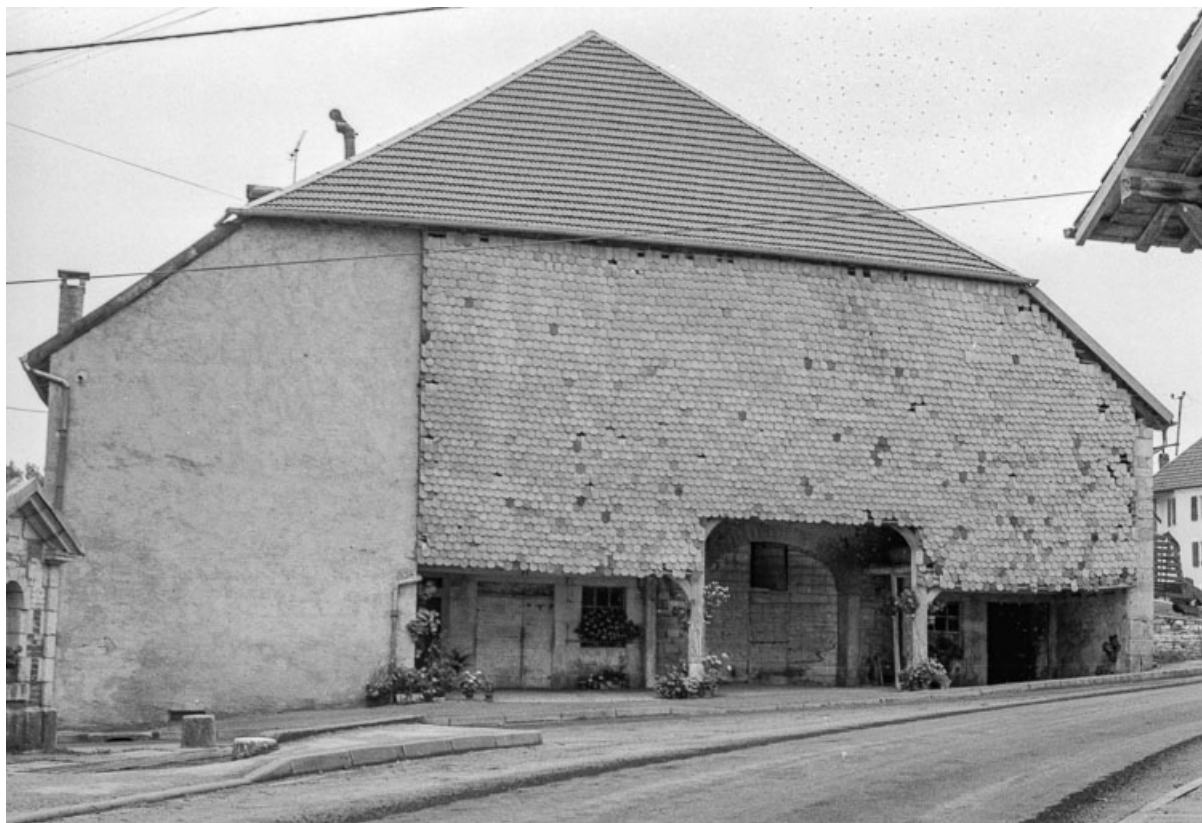
Façade latérale droite sur rue.
