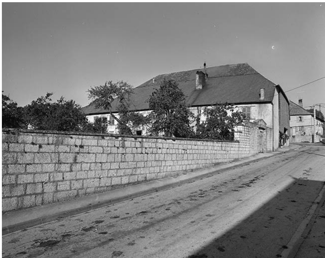
Façade antérieure et mur d'enclos.
