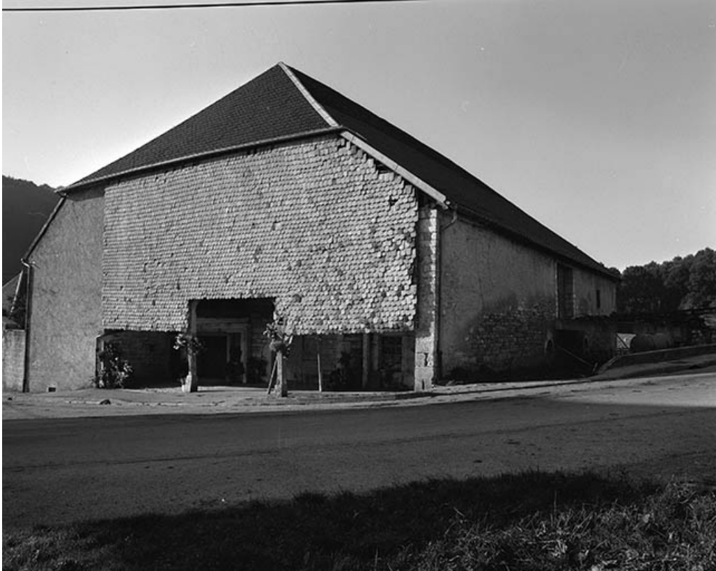
Façade latérale droite sur rue.
