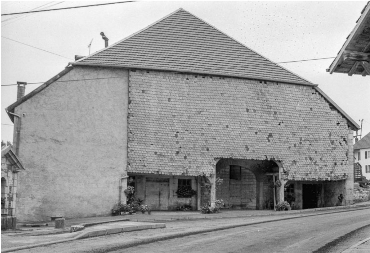
Façade latérale droite sur rue.
