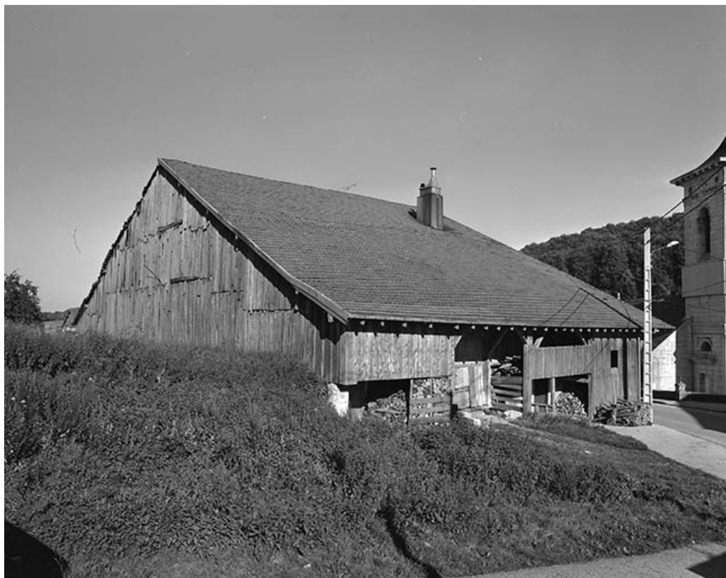
Façades postérieure et latérale gauche.
