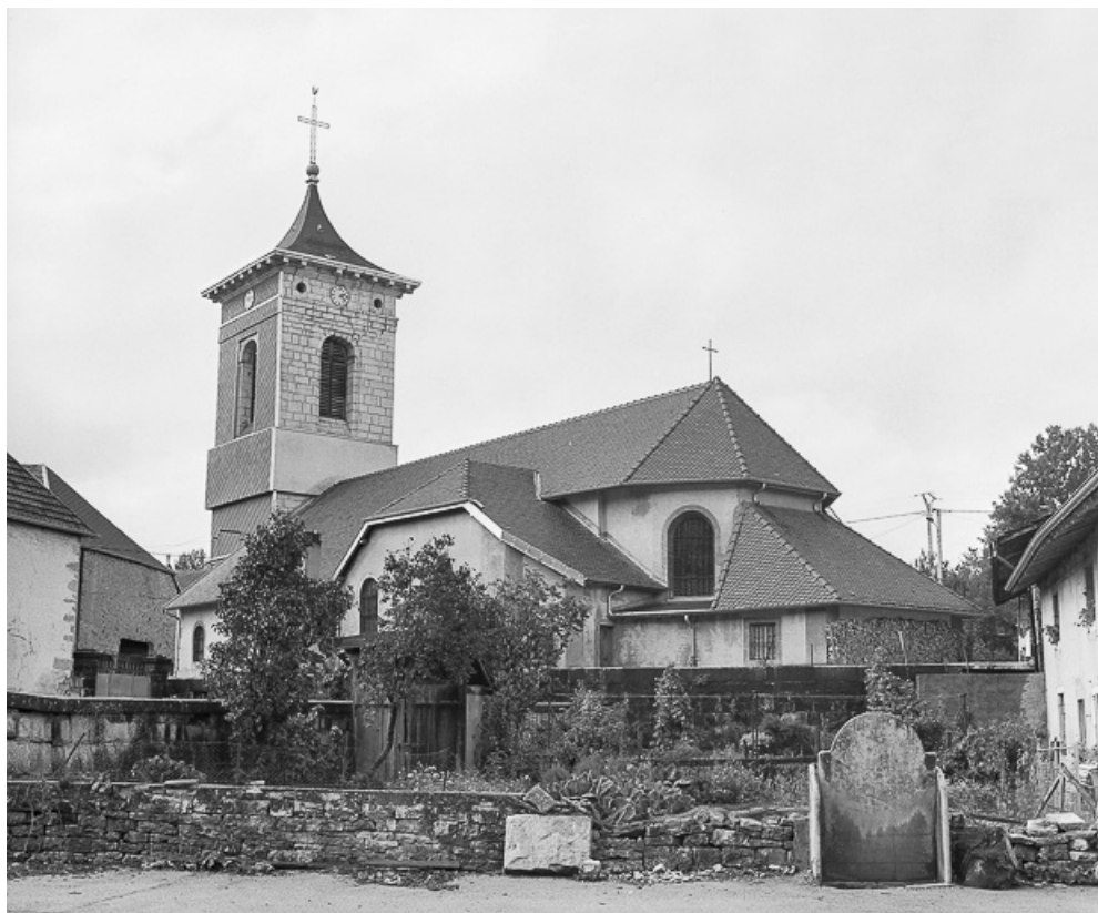
Extérieur : face latérale sud.
