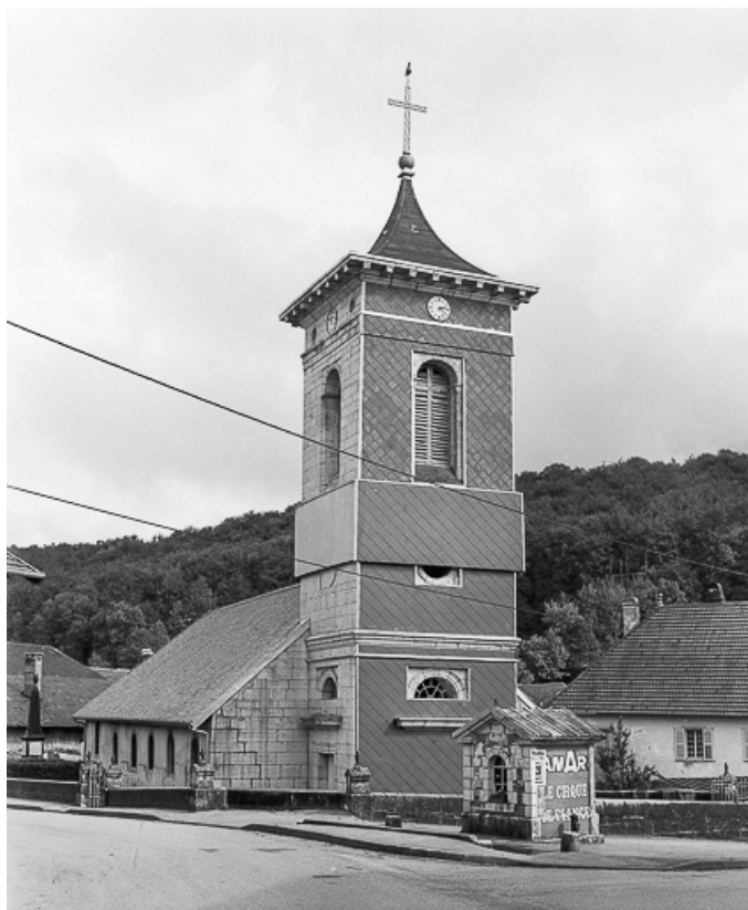
Extérieur : façade antérieure.
