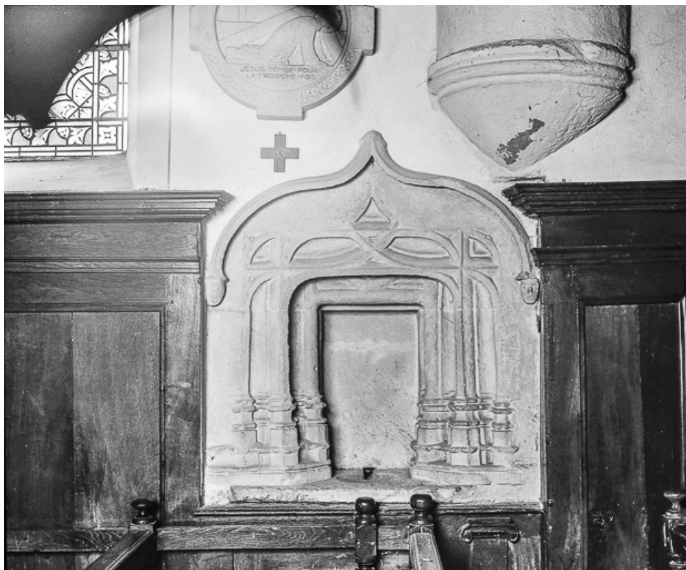
Intérieur : niche du collatéral sud. 25, Chapelle-d'Huin Grande Rue
