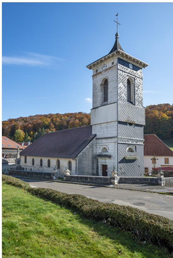
Façade latérale gauche en 2021.
