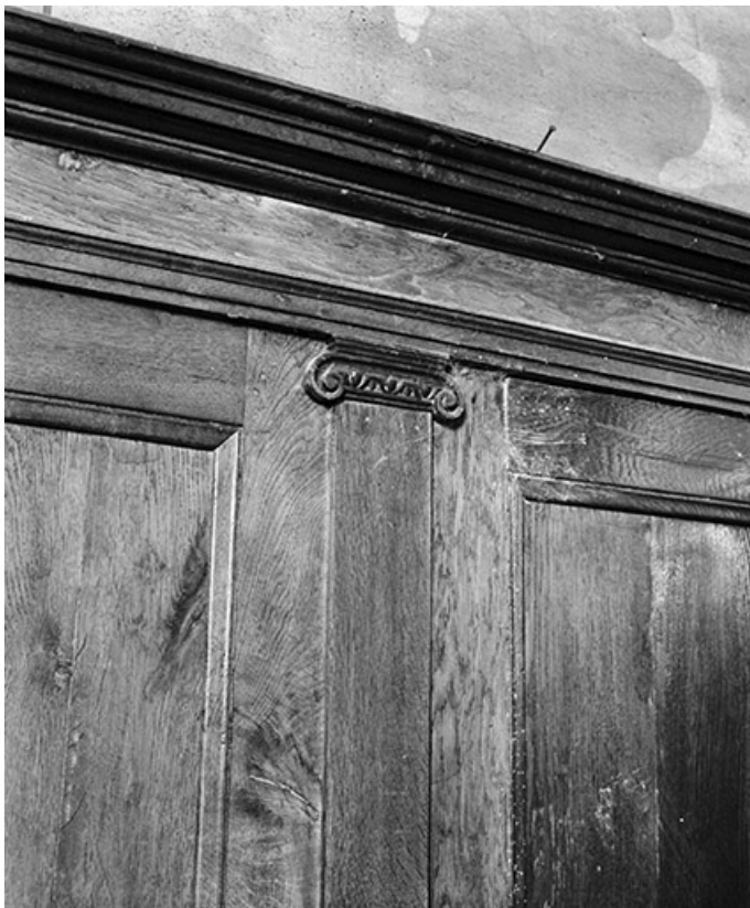
Boiseries du choeur : détail chapiteau et corniche (partie centrale). 25, Chapelle-d'Huin Grande Rue
