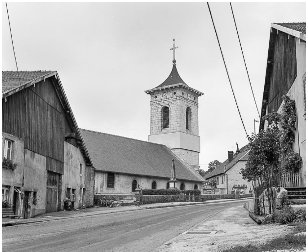
Extérieur : face latérale nord.
