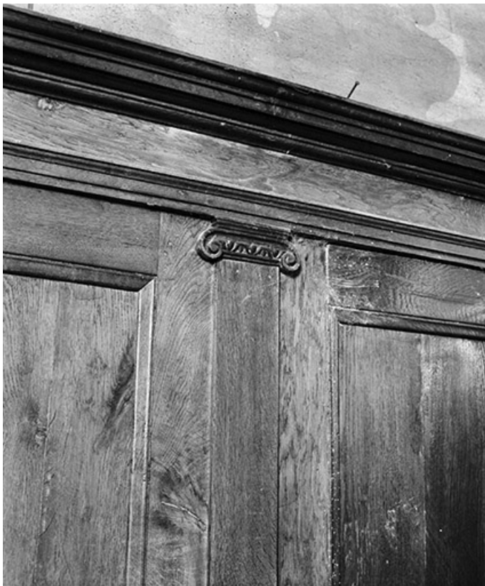
Boiseries du chœur : détail chapiteau et corniche (partie centrale). 25, Chapelle-d'Huin Grande Rue
