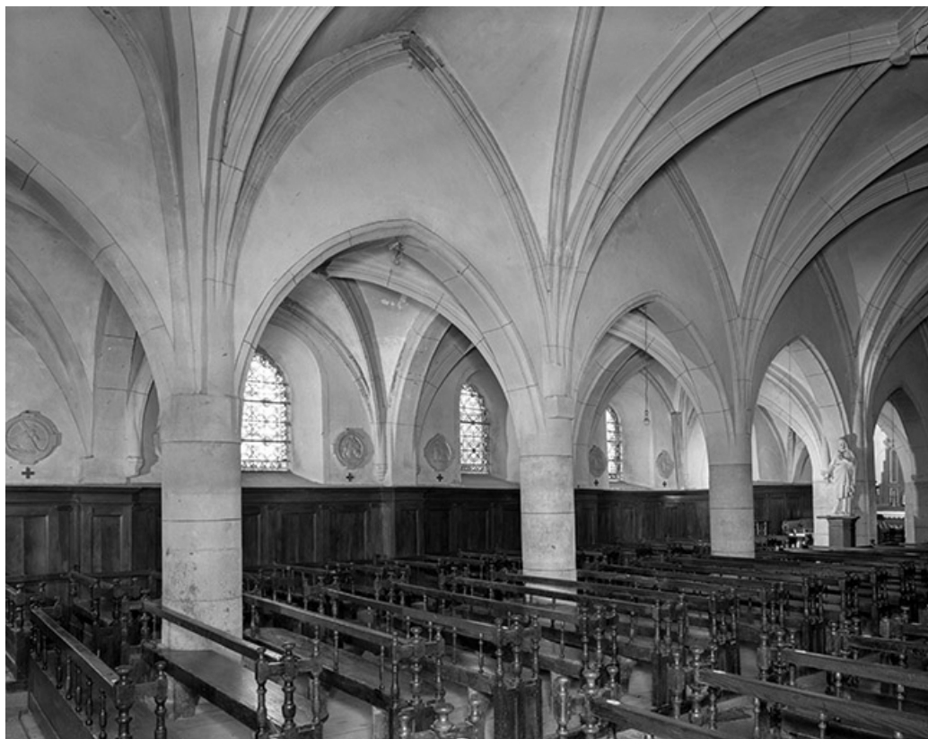
La nef, élévation nord.
