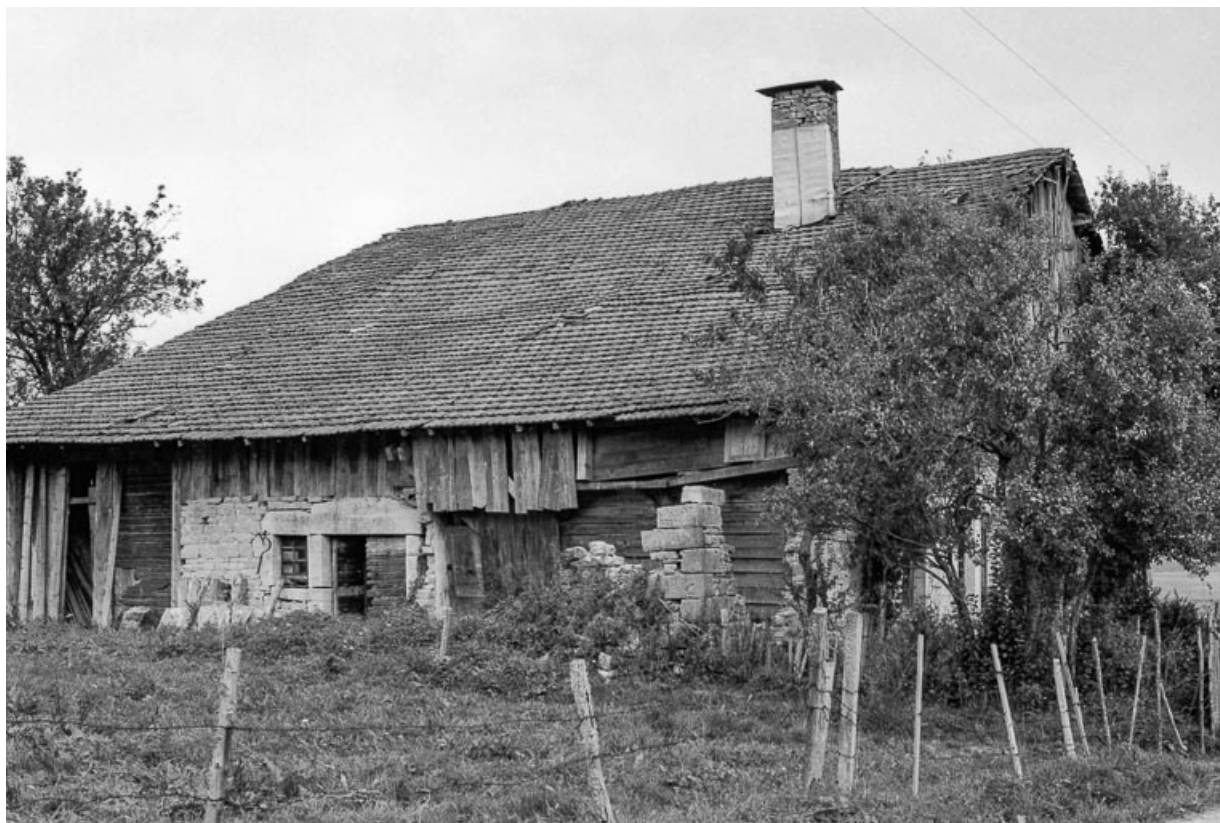
Ferme datée de 1805, située au lieudit La Chaux : façade postérieure. 25, Chapelle-d'Huin
