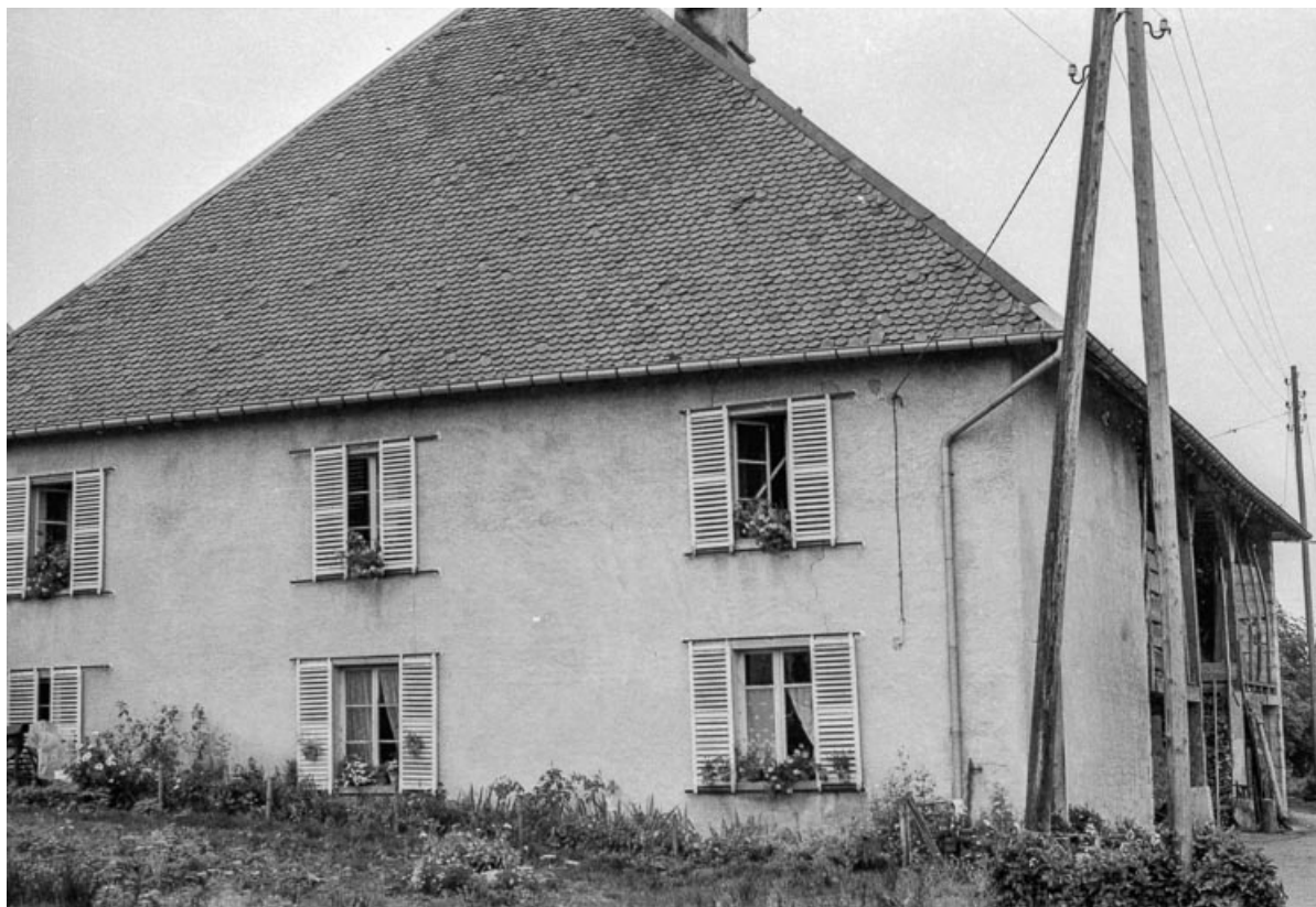
Ferme cadastrée 1939 B 192 : façade latérale gauche. 25, Chapelle-d'Huin
