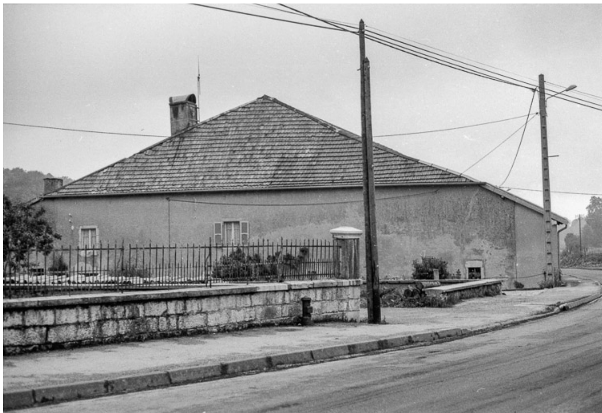
Ferme cadastrée 1939 F 18 et 87 : façade antérieure. 25, Chapelle-d'Huin
