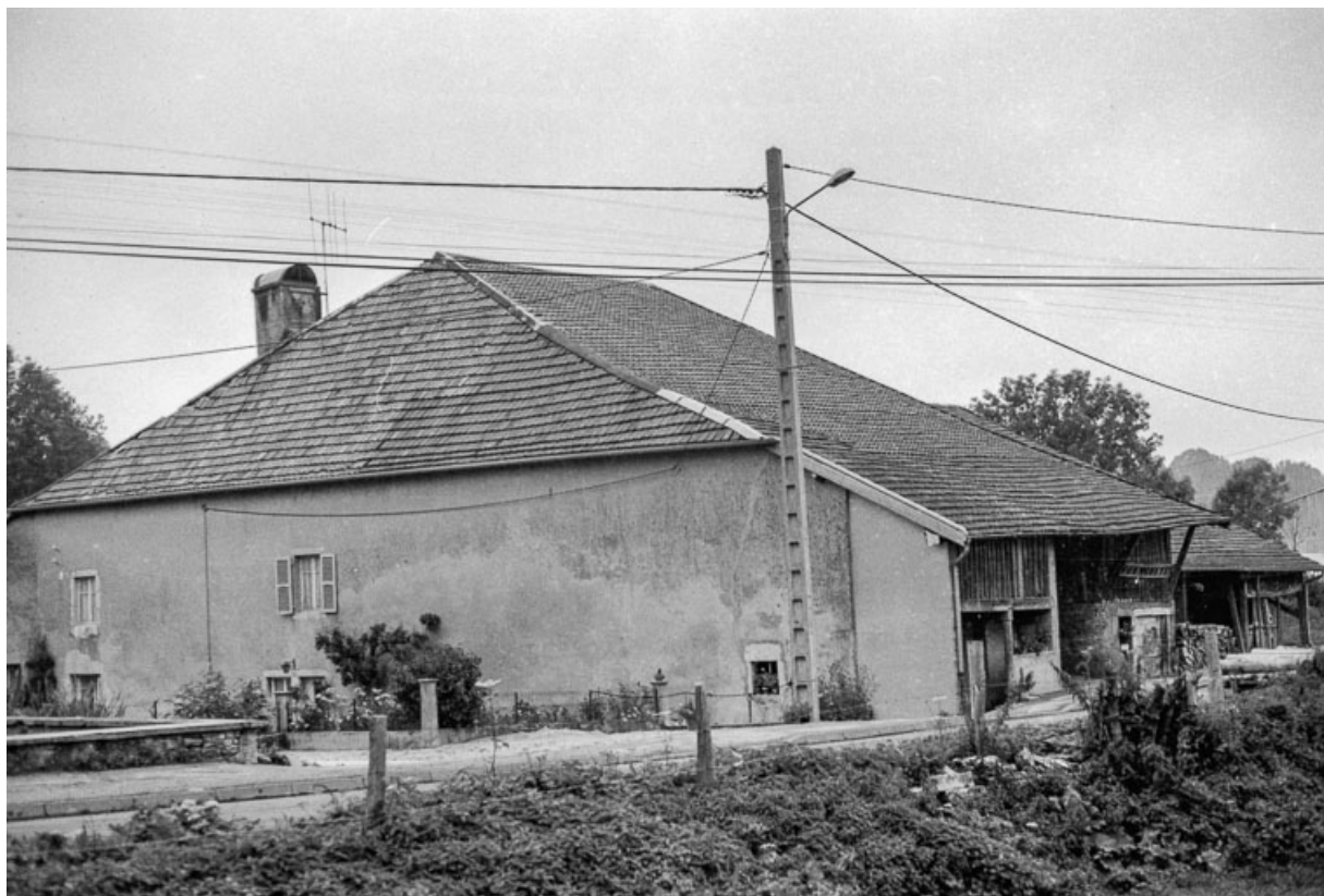
Ferme cadastrée 1939 F 18 et 87 : façade antérieure et latérale droite. 25, Chapelle-d'Huin
