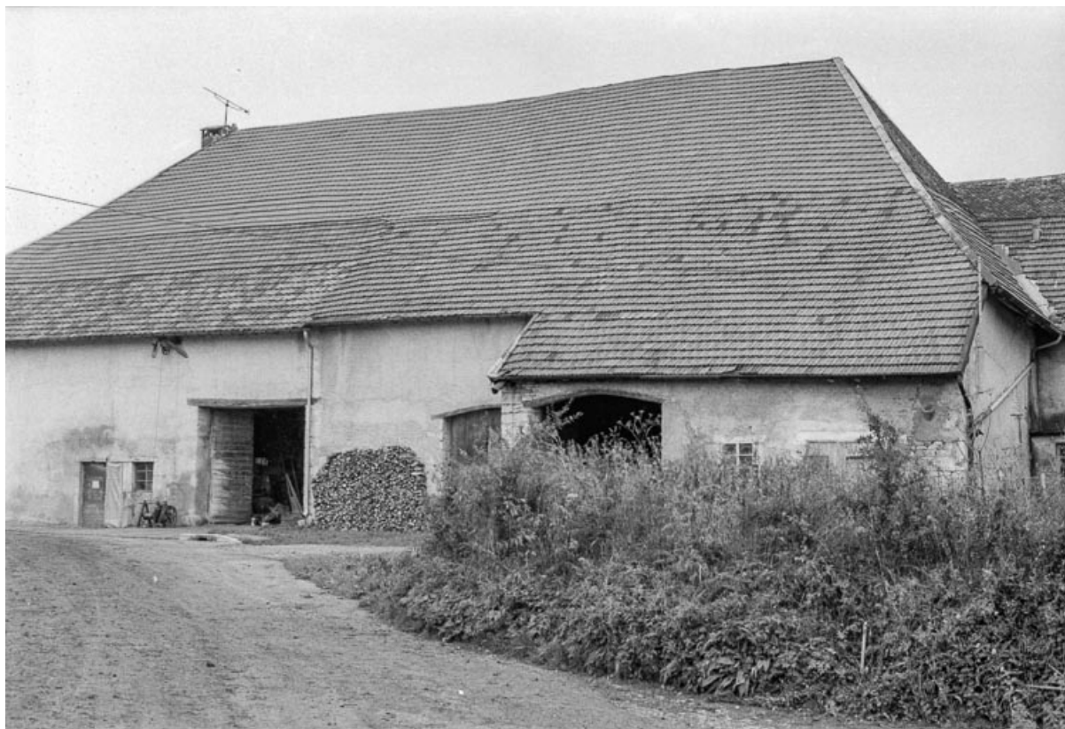
Ferme cadastrée 1939 F 2-3 : façade latérale droite. 25, Chapelle-d'Huin
