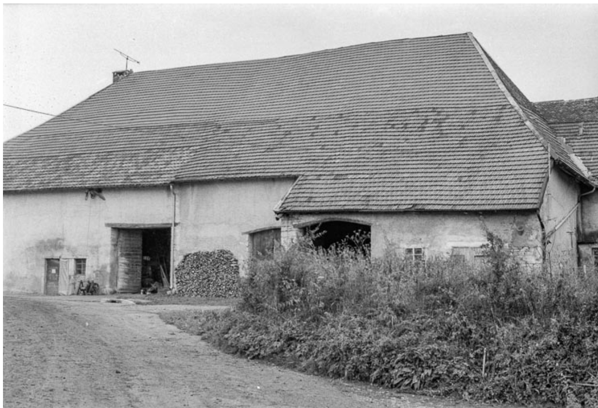
Ferme cadastrée 1939 F 2-3 : façade latérale droite. 25, Chapelle-d'Huin
