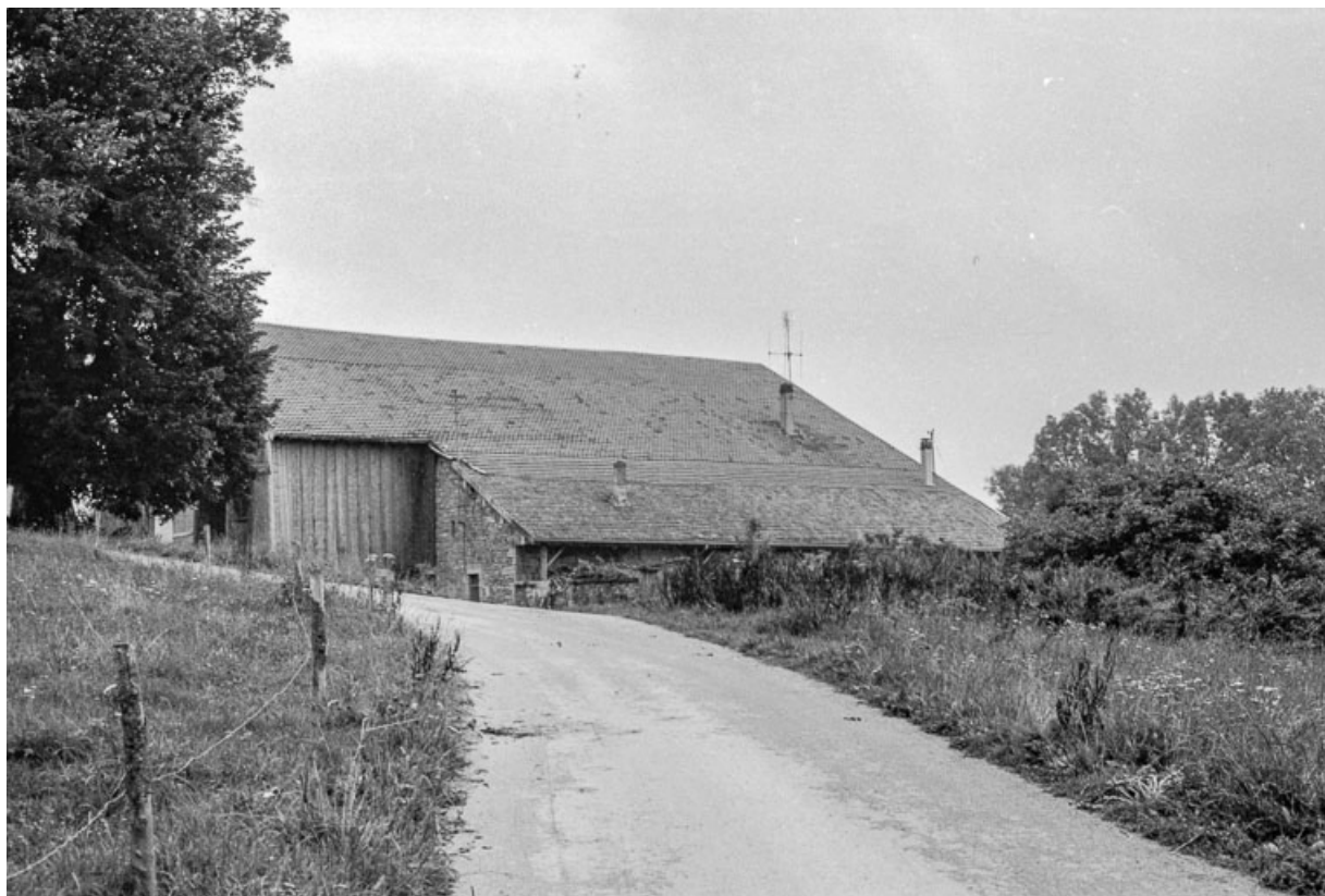
Ferme située au lieudit Le Souillot : vue d'ensemble depuis la rue. 25, Chapelle-d'Huin
