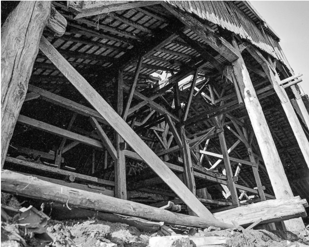
Ferme : facade postérieure (?) : détail. 25, Chapelle-d'Huin
