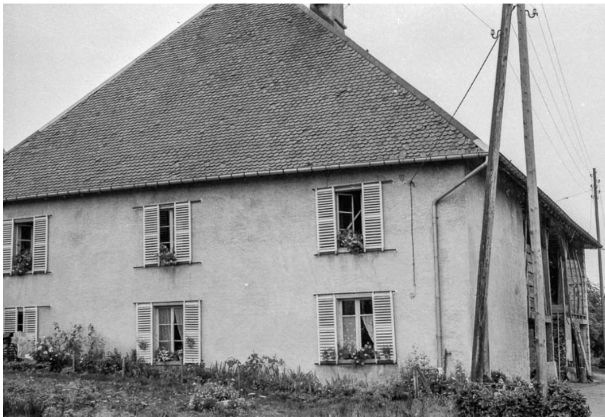
Ferme cadastrée 1939 B 192 : façade latérale gauche. 25, Chapelle-d'Huin
