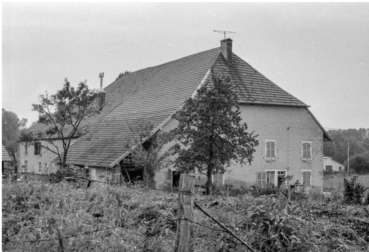
Ferme cadastrée 1939 F 2-3 : façades antérieure et latérale gauche. 25, Chapelle-d'Huin
