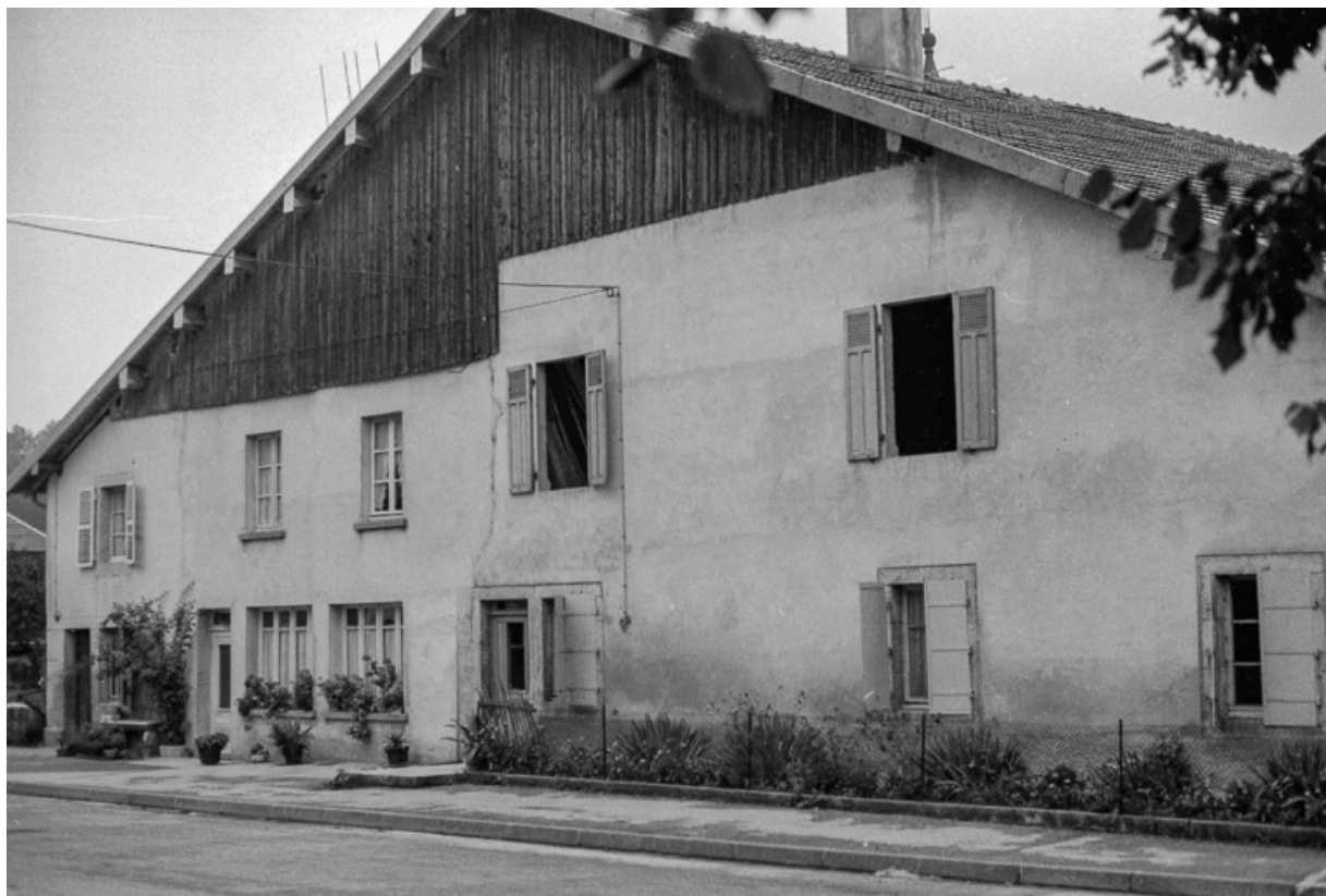
Ferme cadastrée 1939 F 183-184 : façade antérieure. 25, Chapelle-d'Huin
