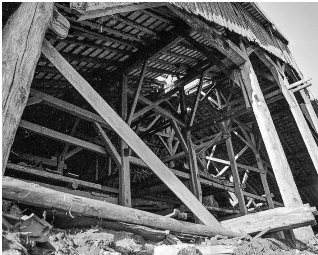
Ferme : facade postérieure (?) : détail. 25, Chapelle-d'Huin
