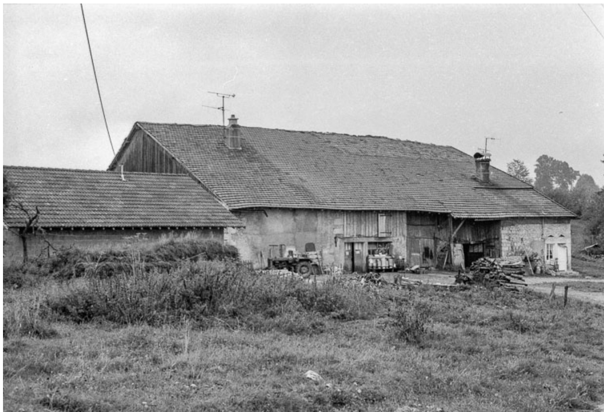
Ferme située au lieudit Le Souillot, cadastrée 1939 F 187-188 : vue d'ensemble. 25, Chapelle-d'Huin
