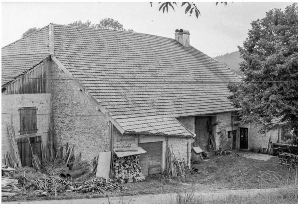
Ferme cadastrée 1939 F 28 : vue d'ensemble. 25, Chapelle-d'Huin
