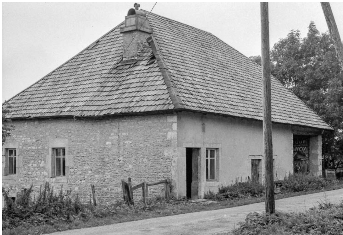
Ferme cadastrée 1939 B 210 : façades antérieure et latérale gauche. 25, Chapelle-d'Huin
