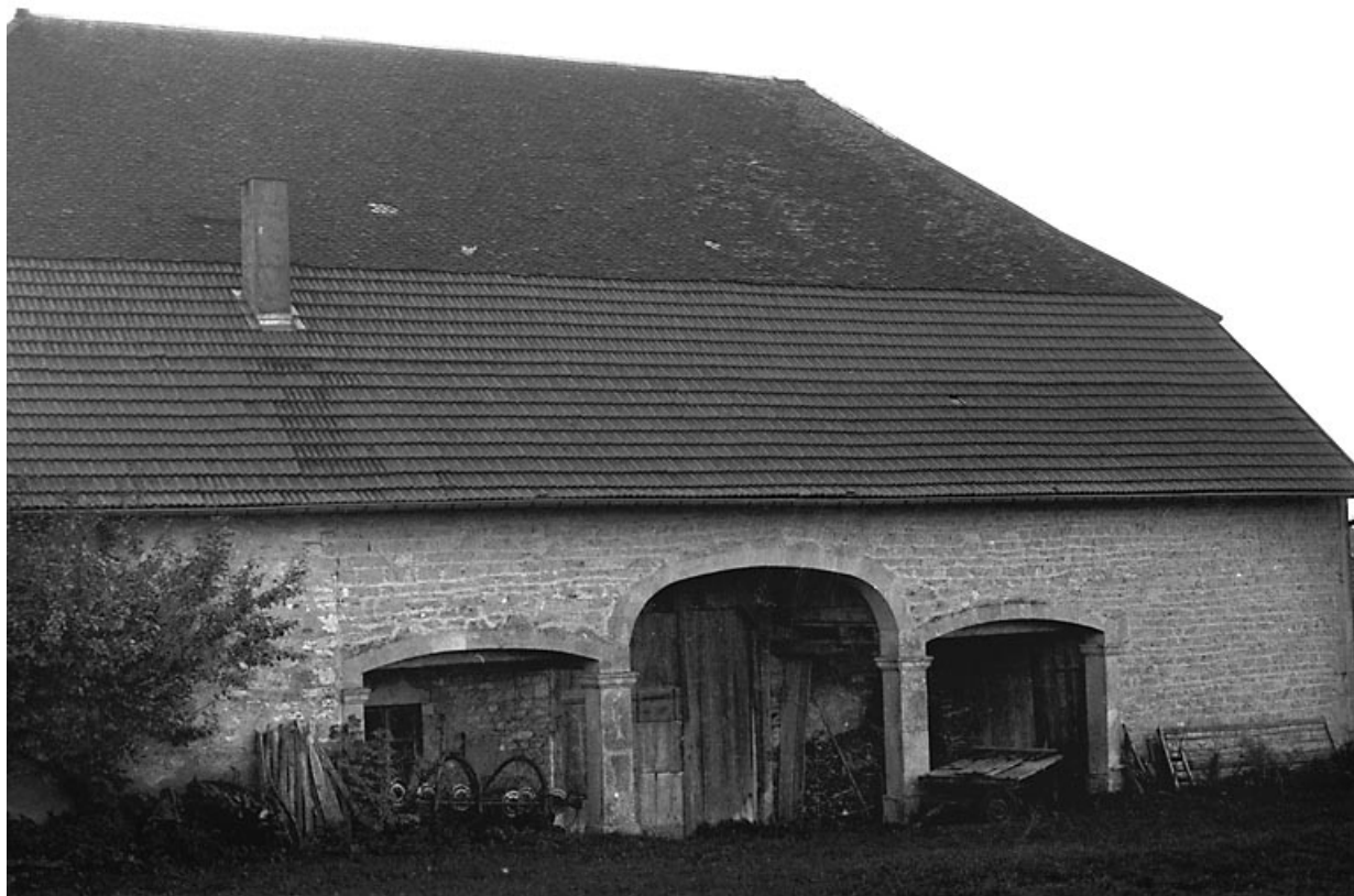
Vue du mur gouttereau droit.
