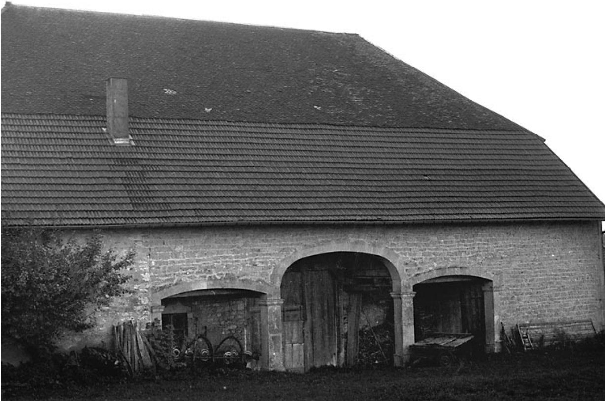
Vue du mur gouttereau droit.
