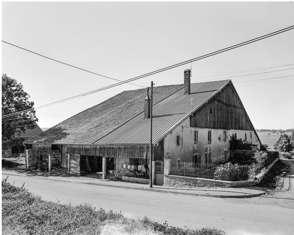
Façade antérieure et mur gouttereau sur rue.
