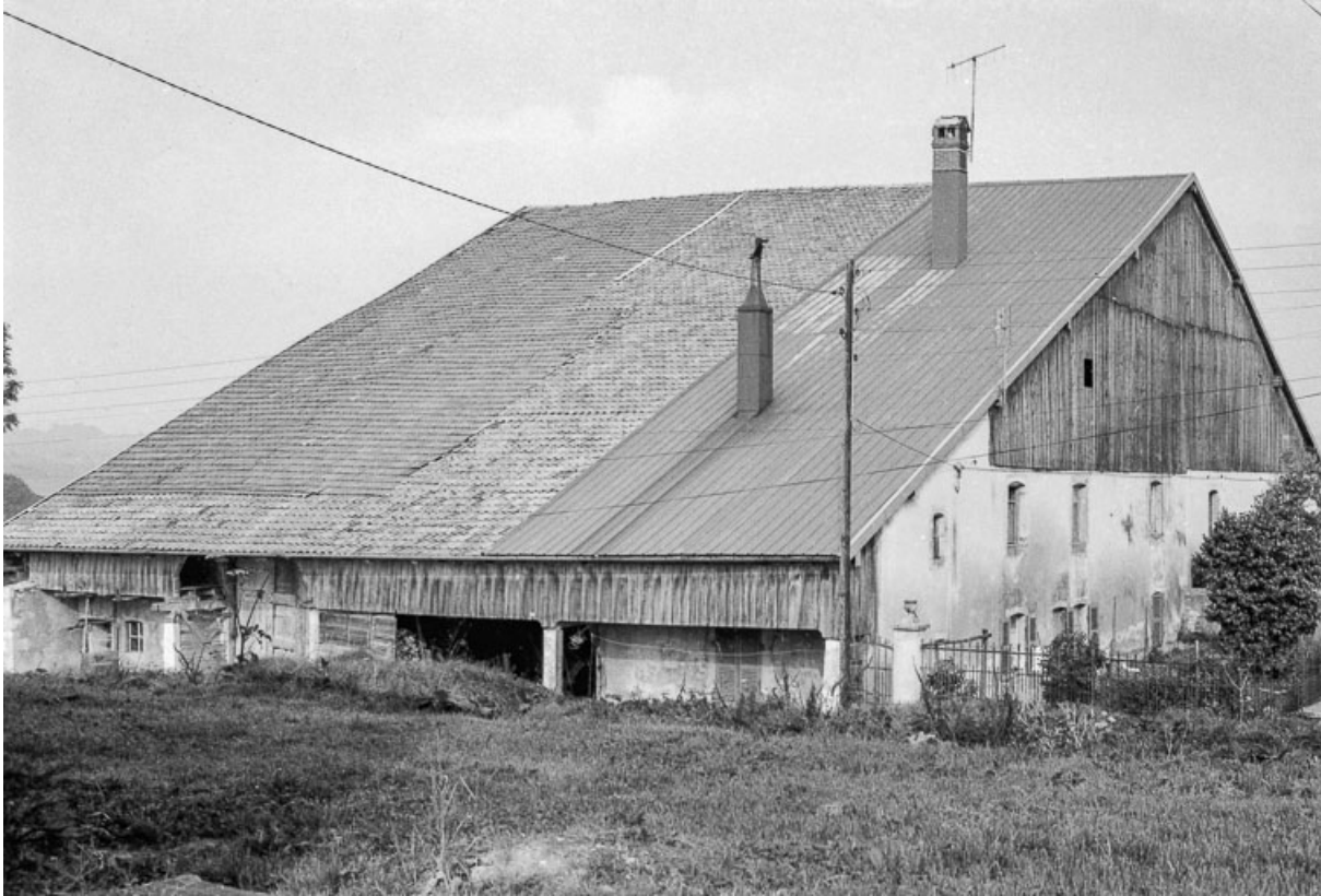
Façades antérieure et latérale gauche sur rue.
