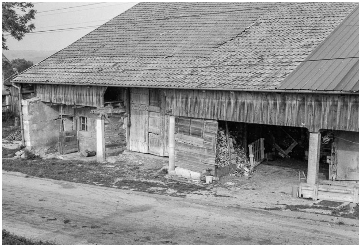
Façade latérale gauche sur rue : partie gauche. 25, Bulle rue sur la Côte
