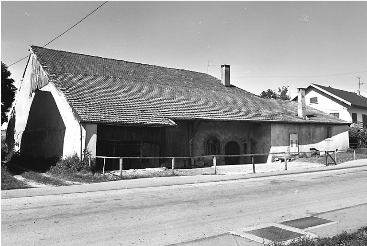
Gouttereau sur rue.
