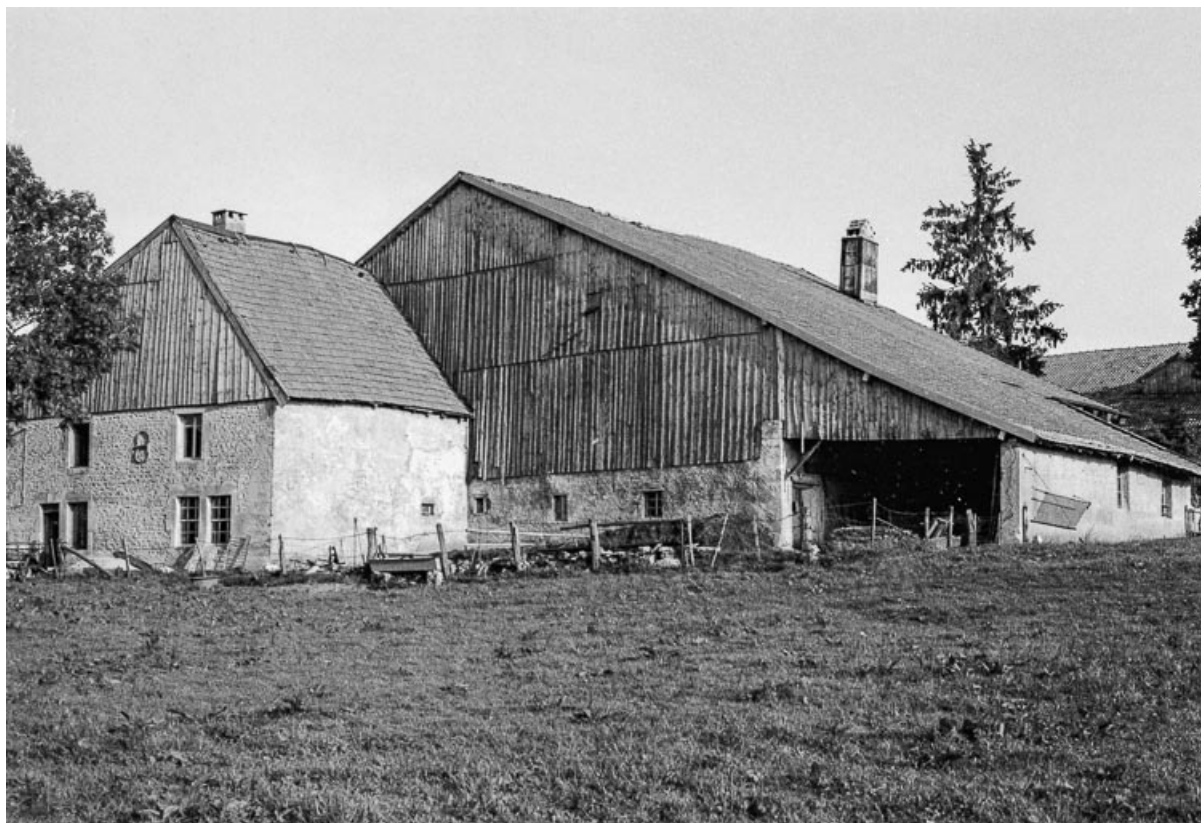
Ferme : façade antérieure. 25, Bulle
