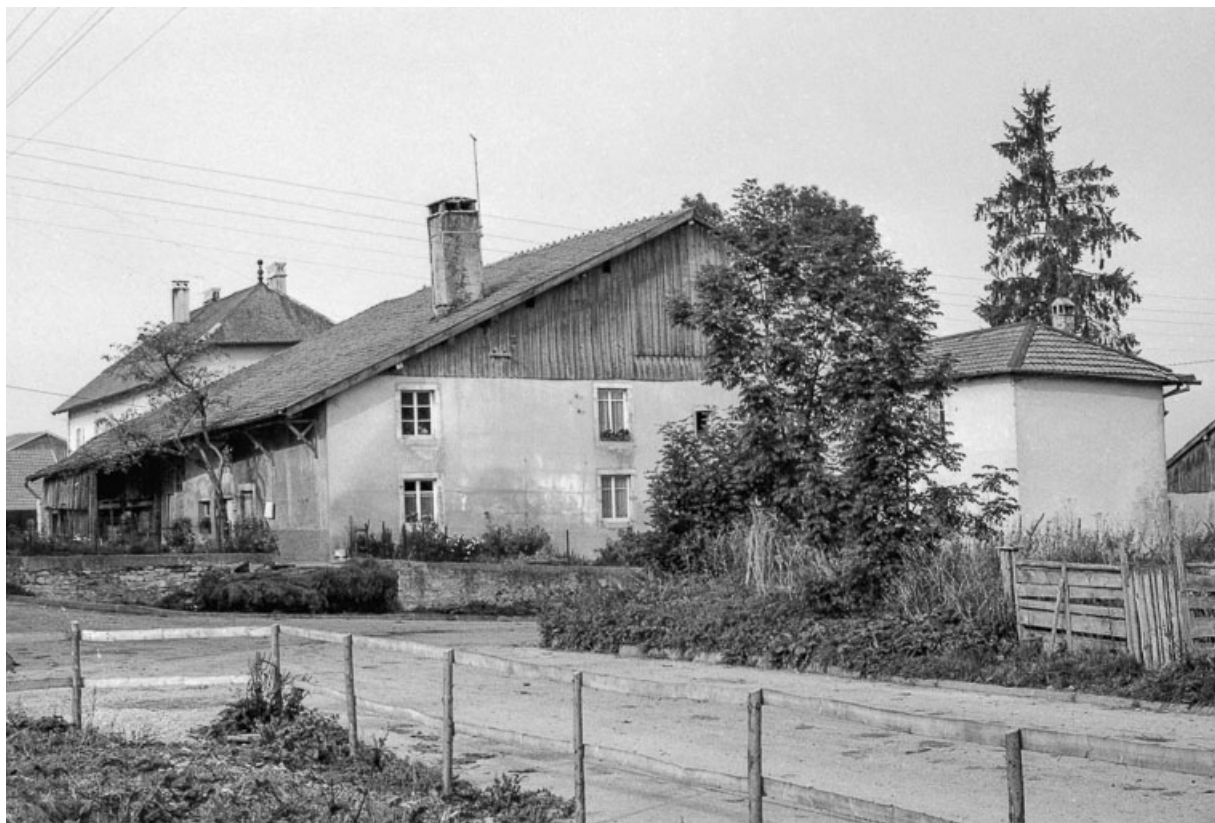
Ferme : façades antérieure et latérale droite. 25, Bulle
