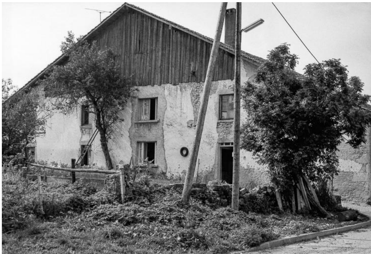
Ferme : façade antérieure. 25, Bulle
