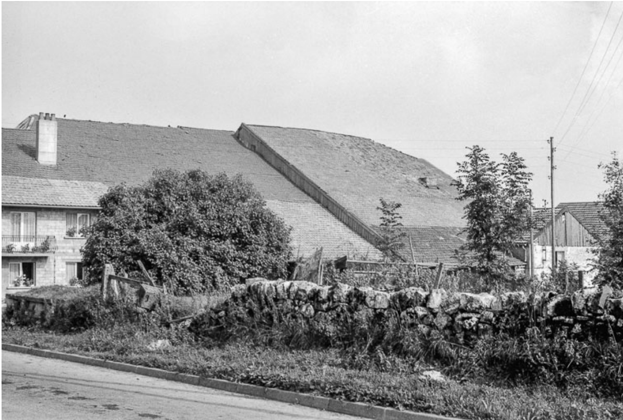
Ferme : vue de situation.
