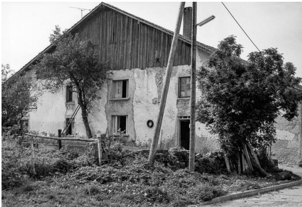
Ferme : façade antérieure. 25, Bulle
