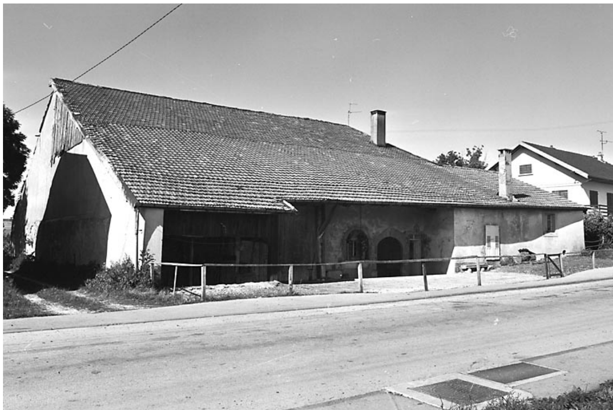
Gouttereau sur rue.
