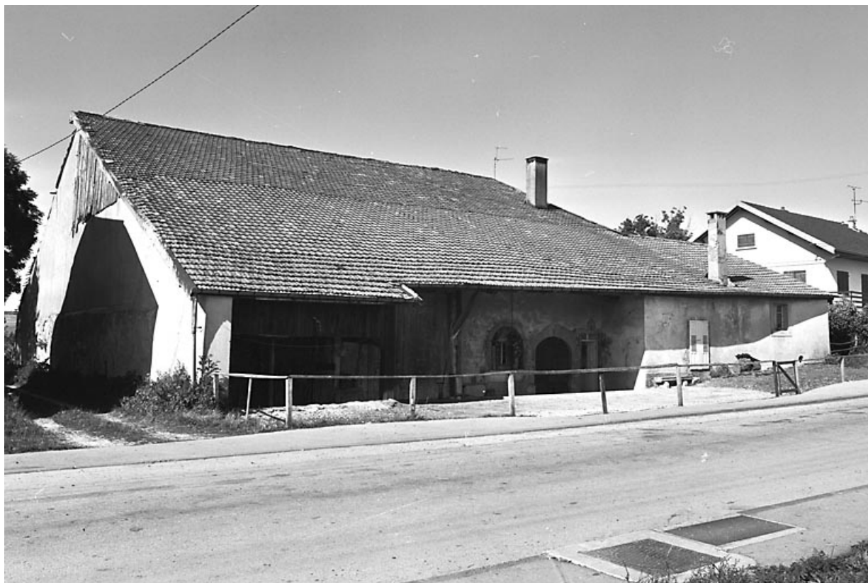
Gouttereau sur rue.
