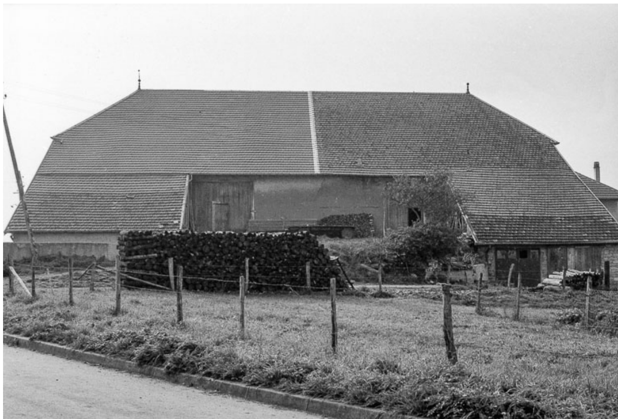
Ferme double : façade postérieure.
