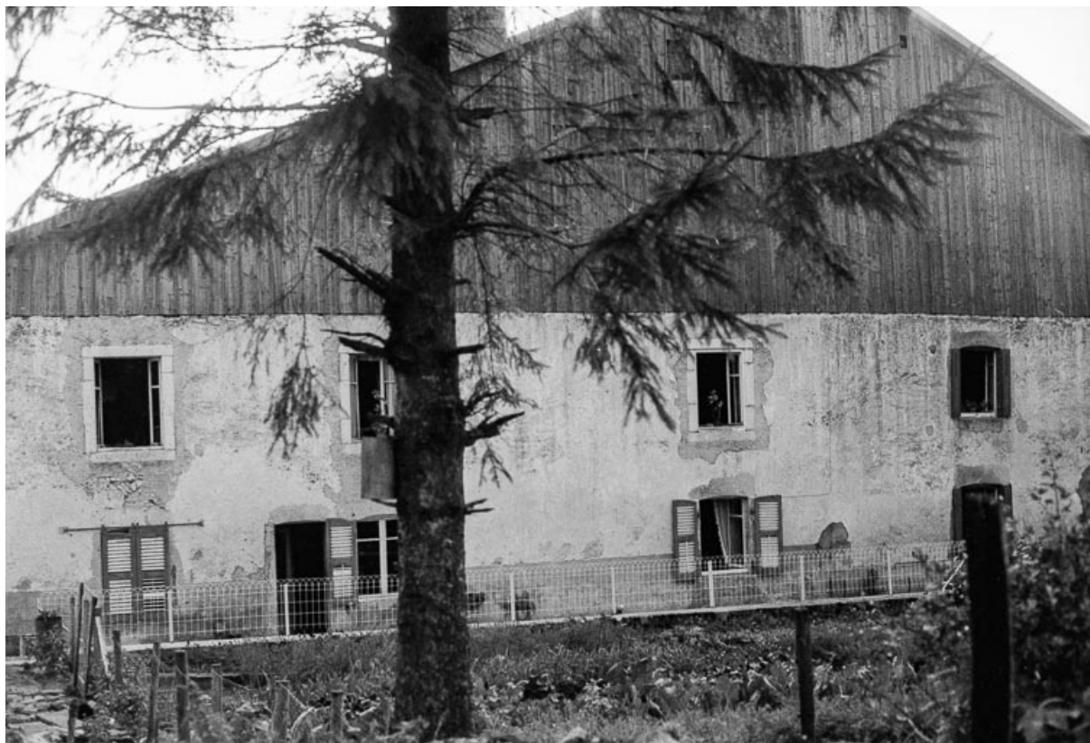
Ferme : façade antérieure. 25, Bulle
