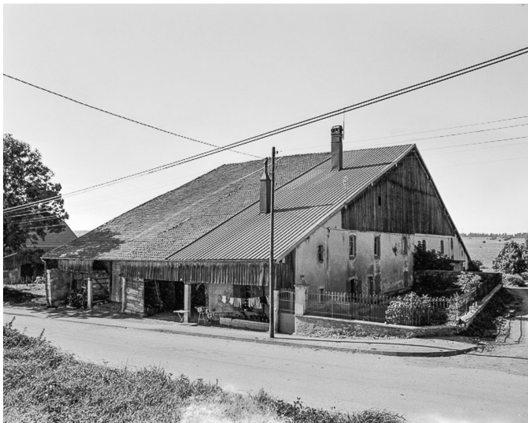
Façade antérieure et mur gouttereau sur rue. 25, Bulle rue sur la Côte
