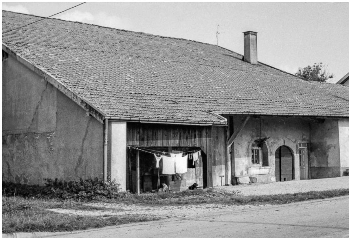
Ferme : façades antérieure et latérale droite. 25, Bulle
