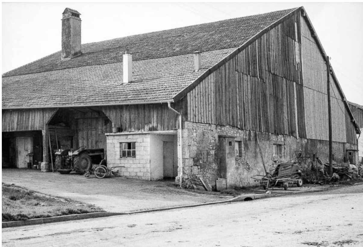
Ferme : façade antérieure et façade latérale droite sur rue. 25, Bulle
