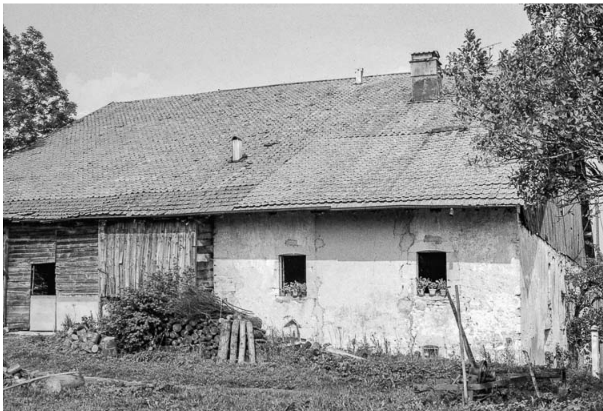
Ferme : façade postérieure. 25, Bulle
