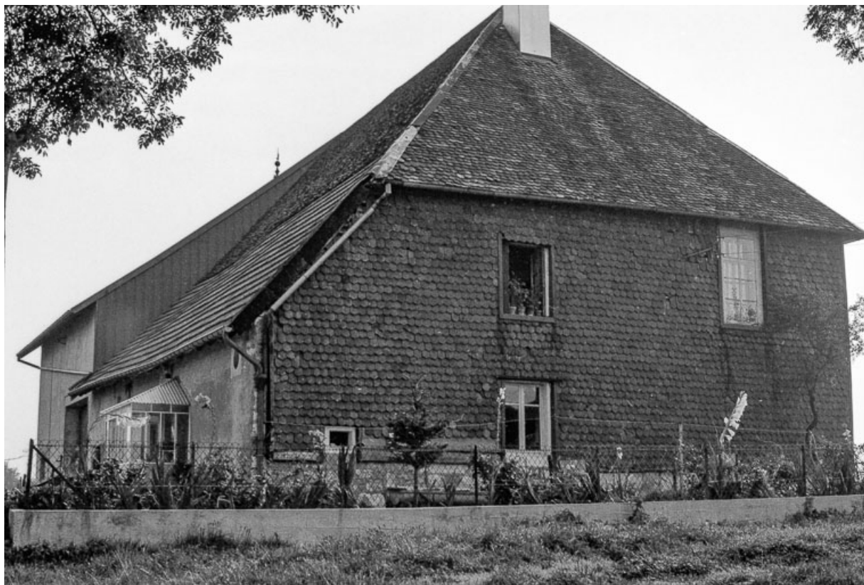
Ferme : façades antérieure et latérale droite. 25, Bulle
