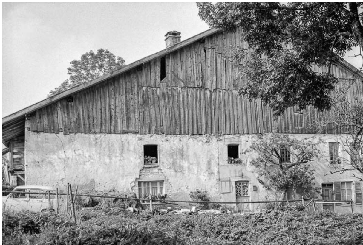
Ferme : façade antérieure. 25, Bulle
