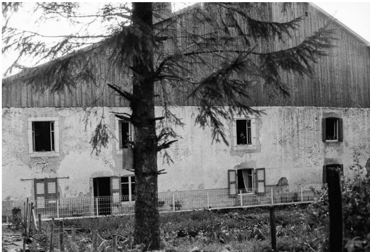
Ferme : façade antérieure. 25, Bulle
