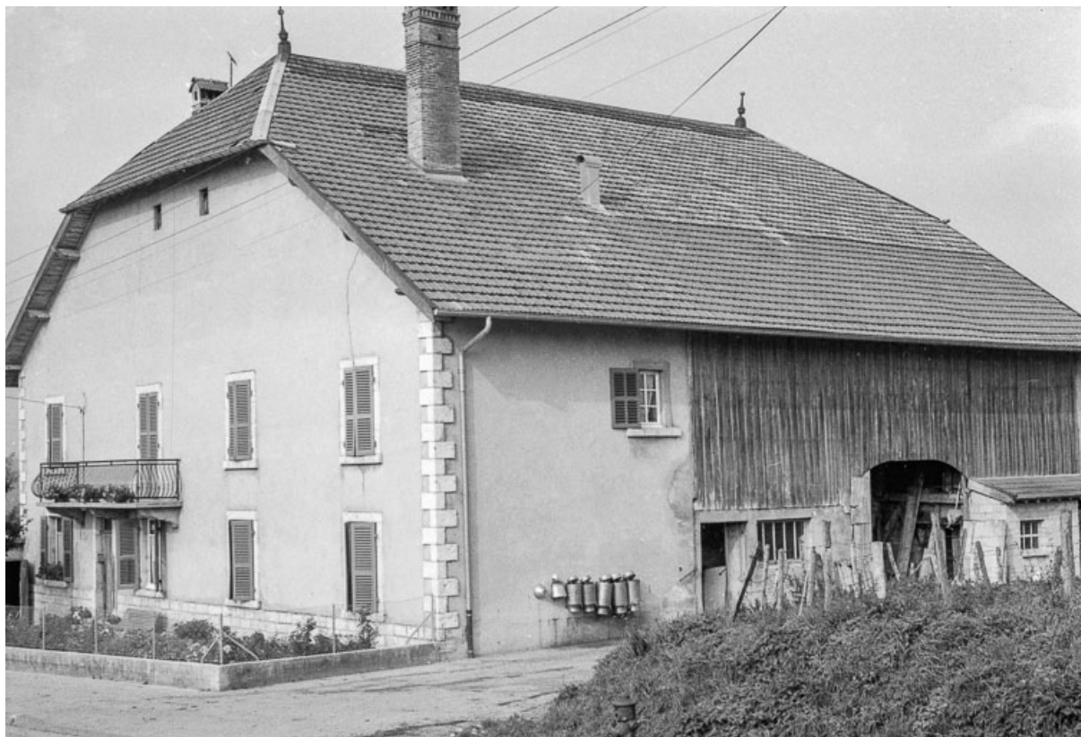
Ferme haute datée de 1814 : vue d'ensemble.
