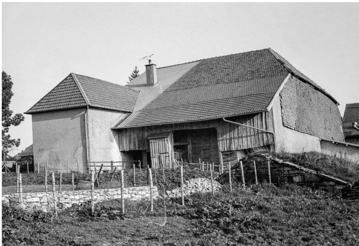
Ferme : façade postérieure. 25, Bulle
