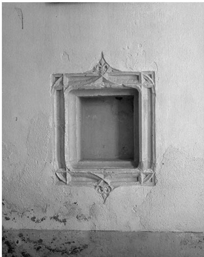
Extérieur : détail, niche.
