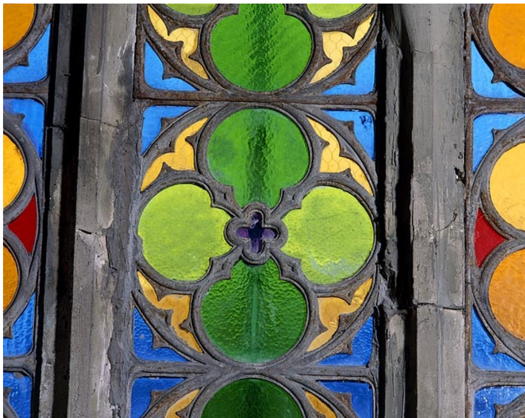
Verrière (baie 9), détail : quadrilobe n°1. 25, Boujailles place de l' Eglise
