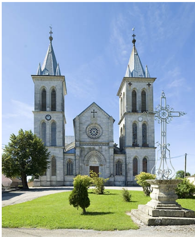
Façade antérieure et croix monumentale.
