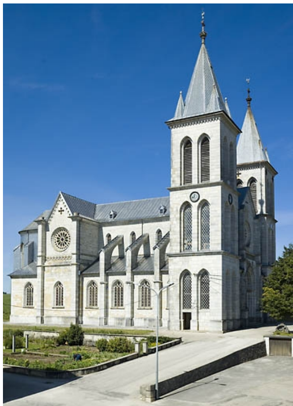
Façade latérale gauche.
