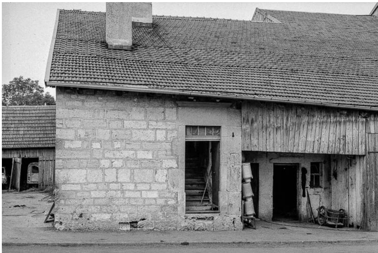
Ferme datée de 1796 et 1828, cadastrée 1938 F 47 bis : partie droite de la façade sur rue. 25, Boujailles
