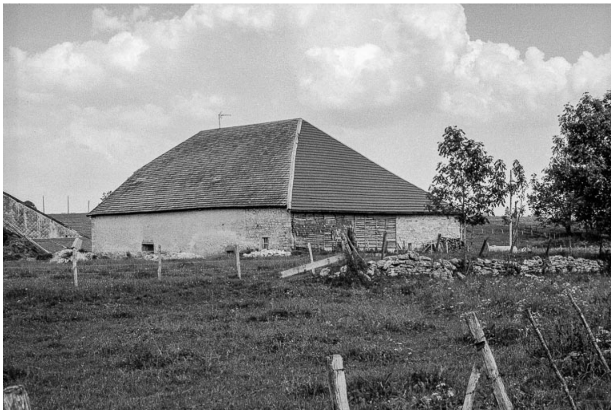
Ferme, cadastrée 1938 F 62 : façade postérieure. 25, Boujailles
