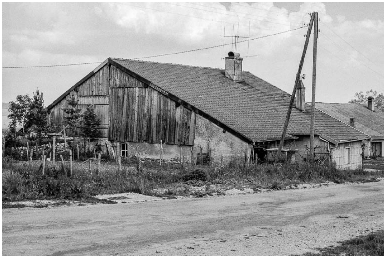
Ferme située 32 rue de Salins : façades latérale et postérieure avec débord de la partie habitation, pignon fermé par des planches et montée de grange.
