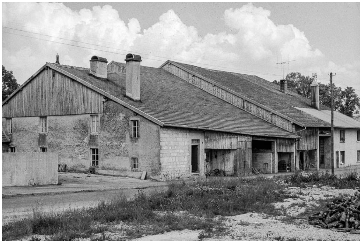
Ferme datée de 1796 et 1828, cadastrée 1938 F 47 bis : vue d'ensemble de trois quarts gauche. 25, Boujailles
