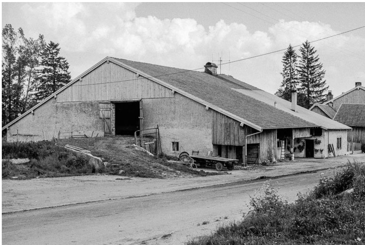
Ferme datée de 1750, cadastrée 1938 F 56 : vue de trois quarts gauche depuis la rue. 25, Boujailles
