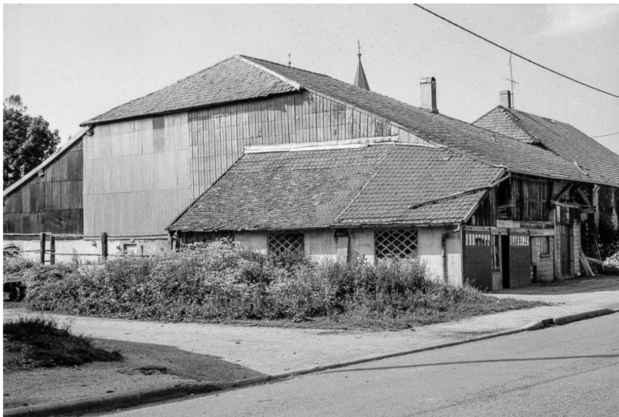
Ferme datée de 1732, cadastrée 1938 F 285 : façades antérieure et latérale gauche. 25, Boujailles
