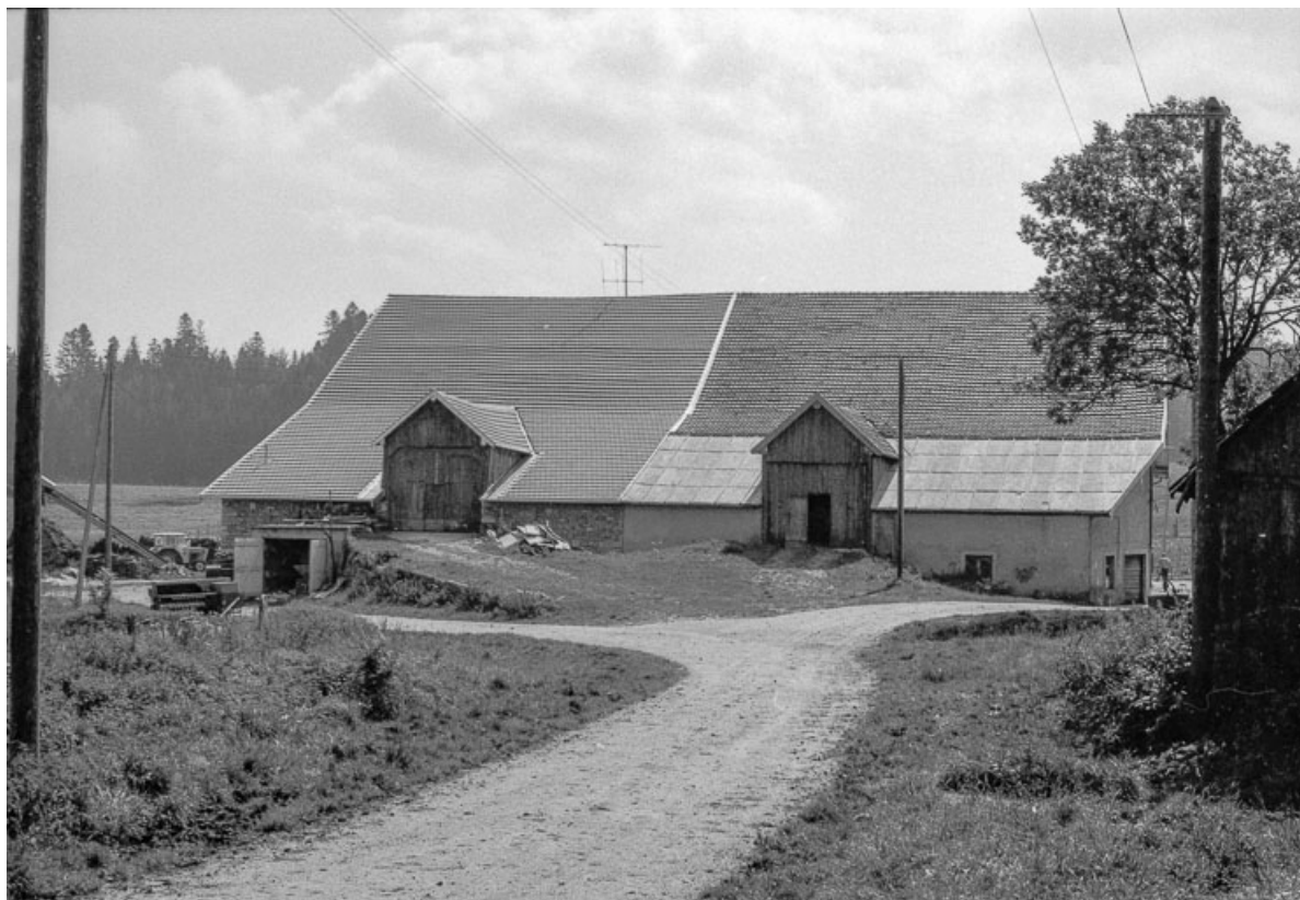
Ferme située au lieu-dit La Cabette : façade postérieure. 25, Boujailles
