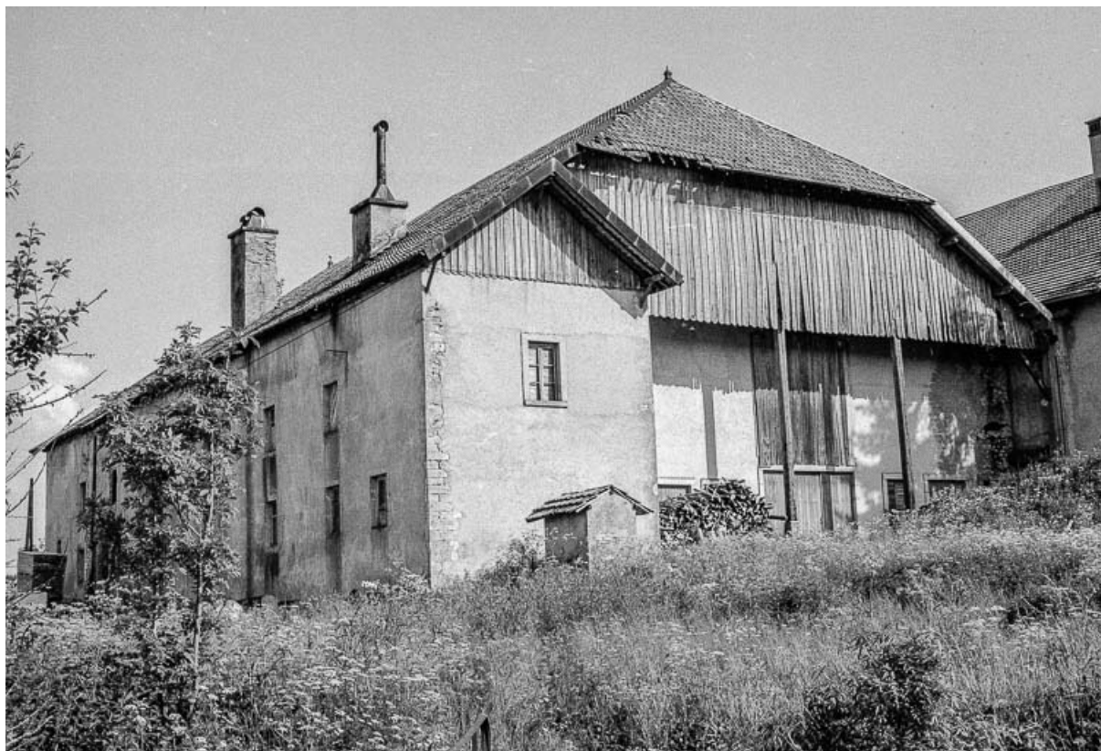
Ferme datée de 1796, cadastrée 1938 F 126-126bis : façades postérieure et latérale droite. 25, Boujailles
