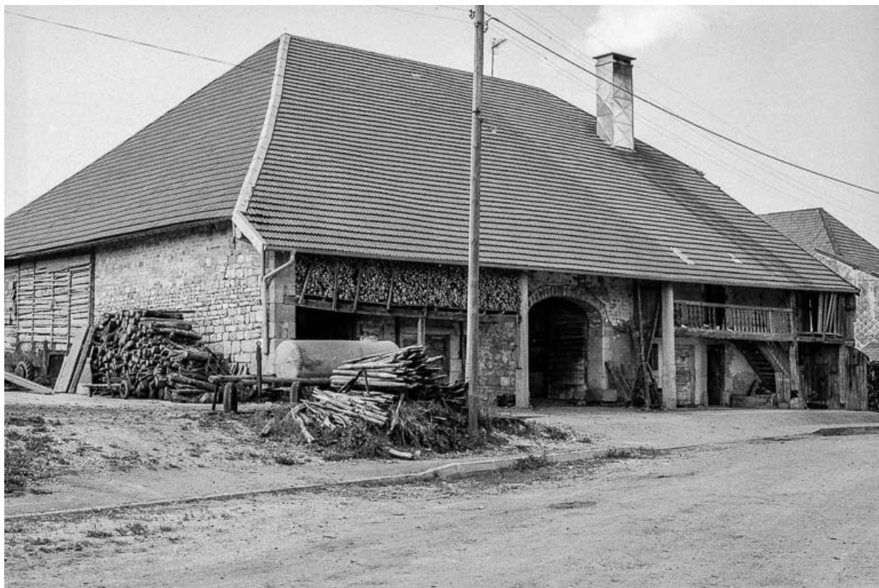
Ferme, cadastrée 1938 F 62 : façade antérieure. 25, Boujailles
