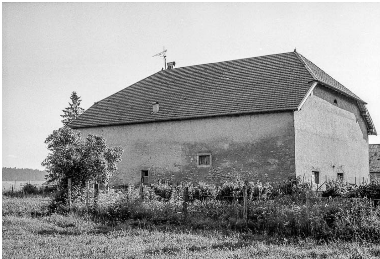
Ferme datée de 1886, cadastrée 1938 F 168 : façades postérieure et latérale gauche. 25, Boujailles
