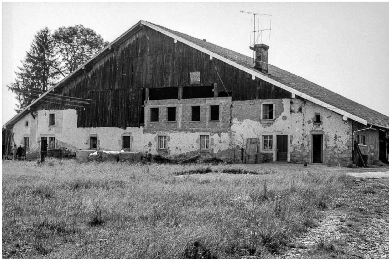
Ferme cadastrée 1938 E 266-267 : façade antérieure. 25, Boujailles
