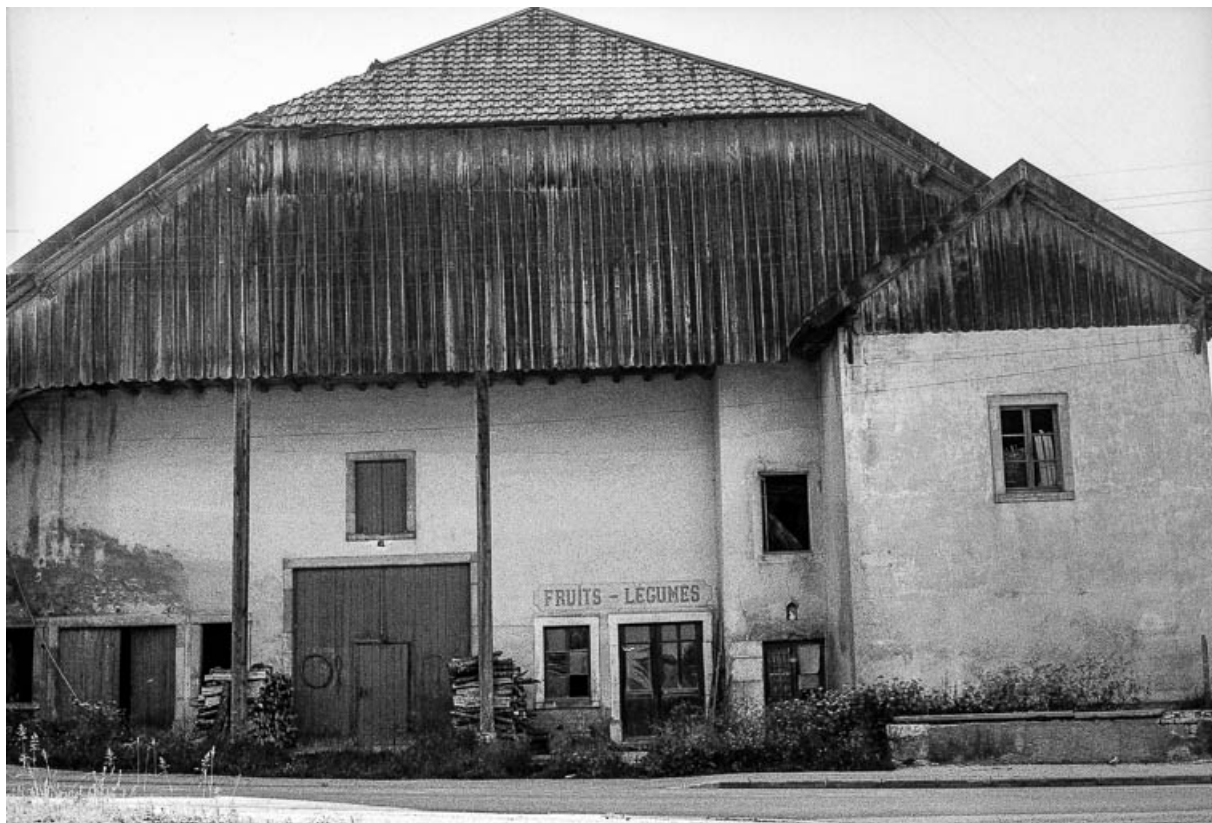
Ferme datée de 1796, cadastrée 1938 F 126-126bis : façade antérieure. 25, Boujailles
