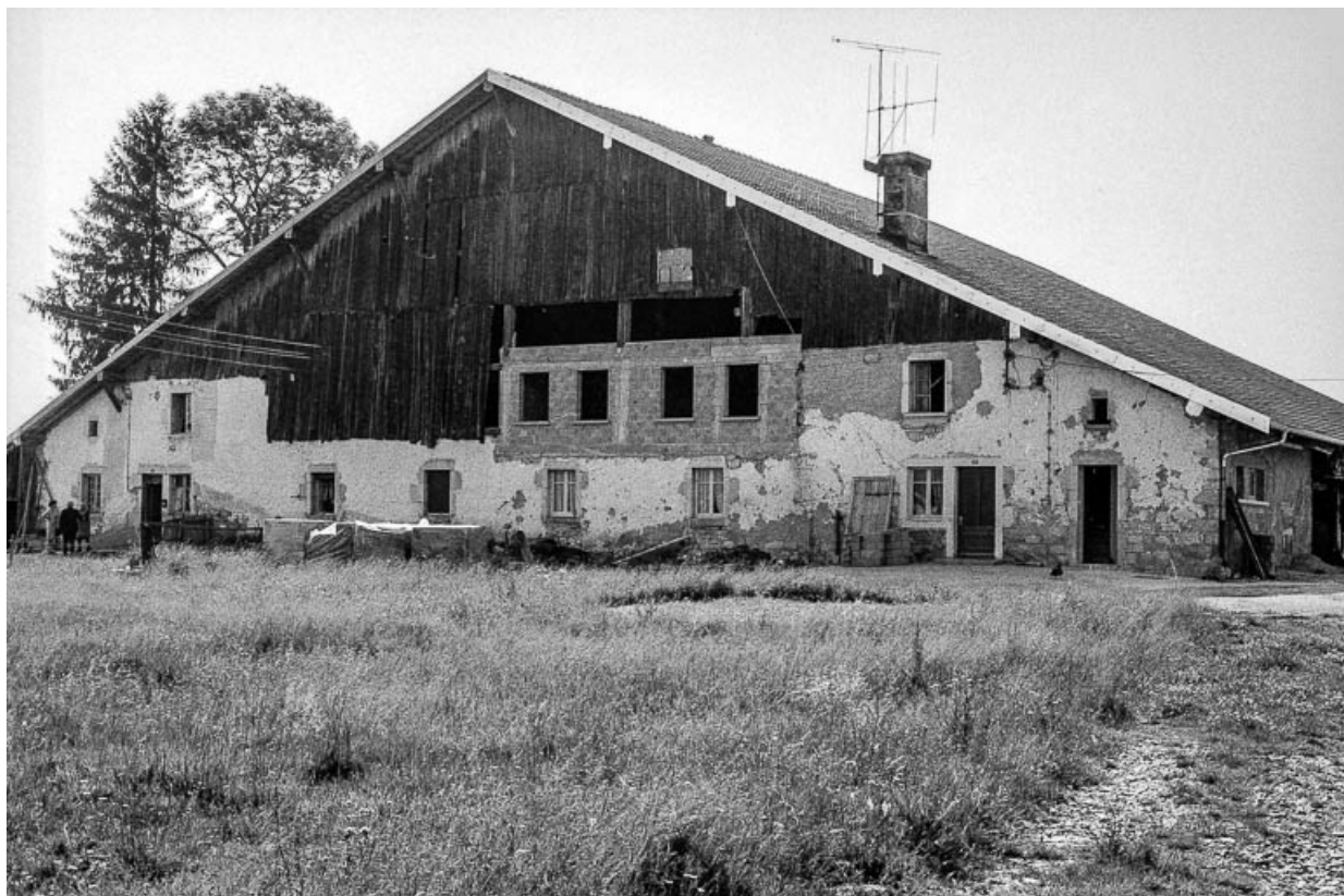
Ferme cadastrée 1938 E 266-267 : façade antérieure. 25, Boujailles
