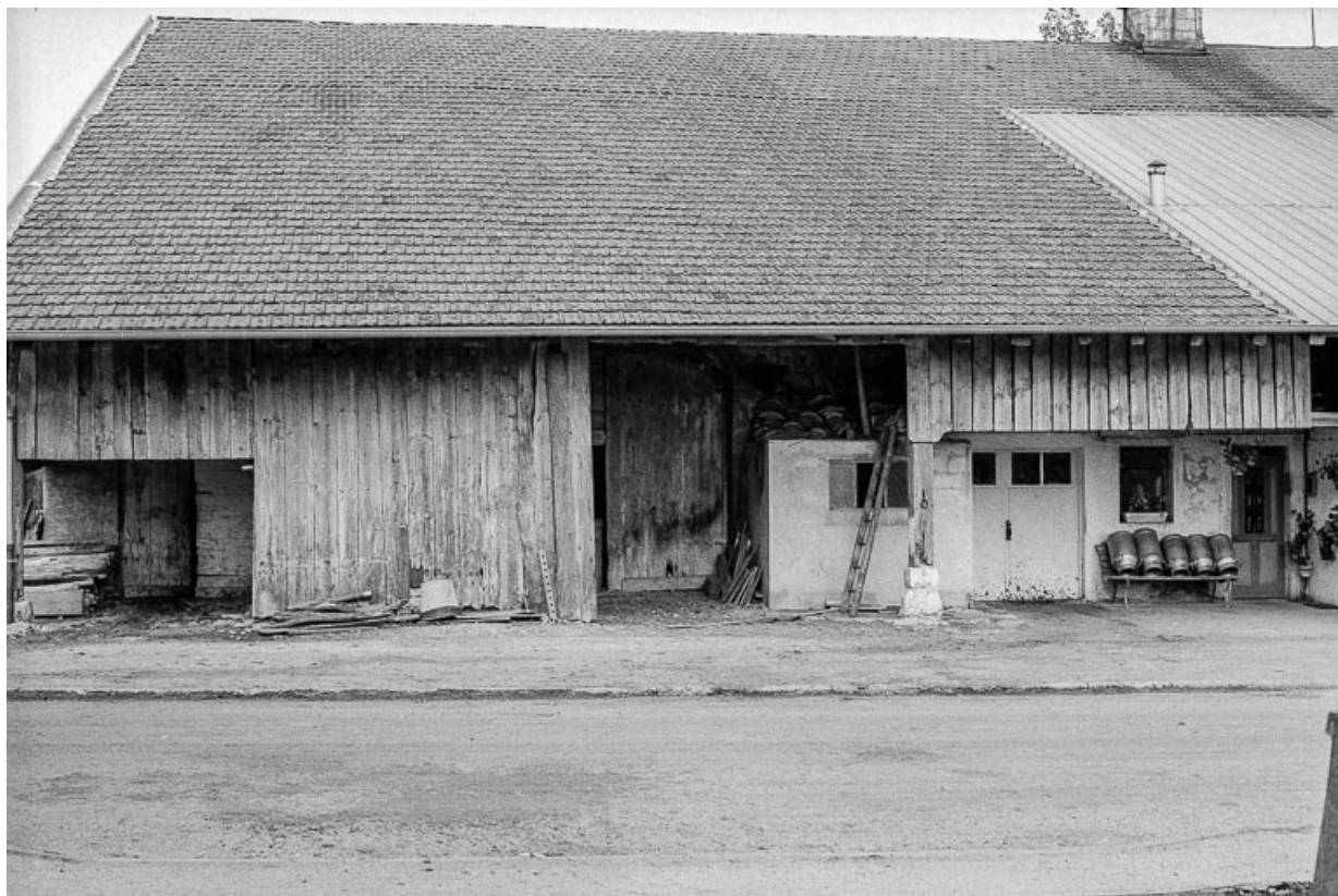
Ferme datée de 1750, cadastrée 1938 F 56 : façade sur rue. 25, Boujailles
