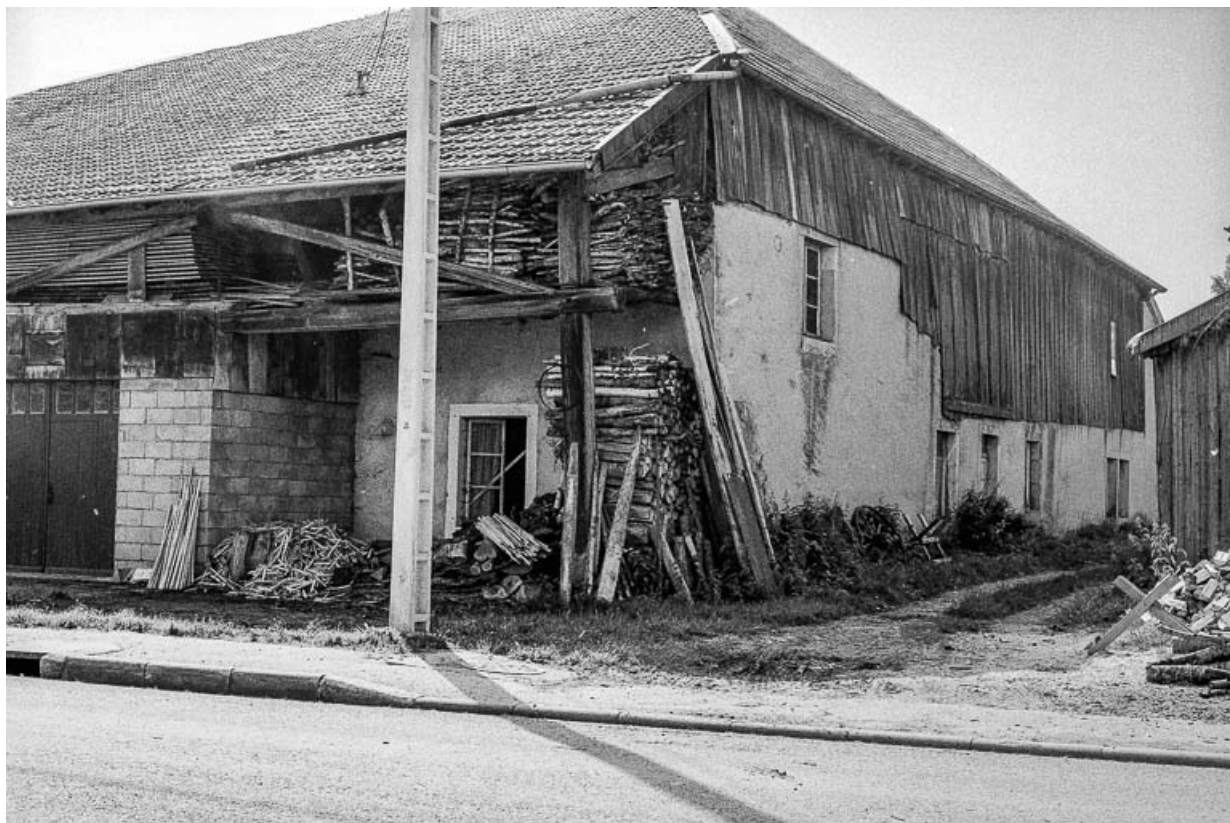
Ferme datée de 1732, cadastrée 1938 F 285 : façades antérieure et latérale droite. 25, Boujailles
