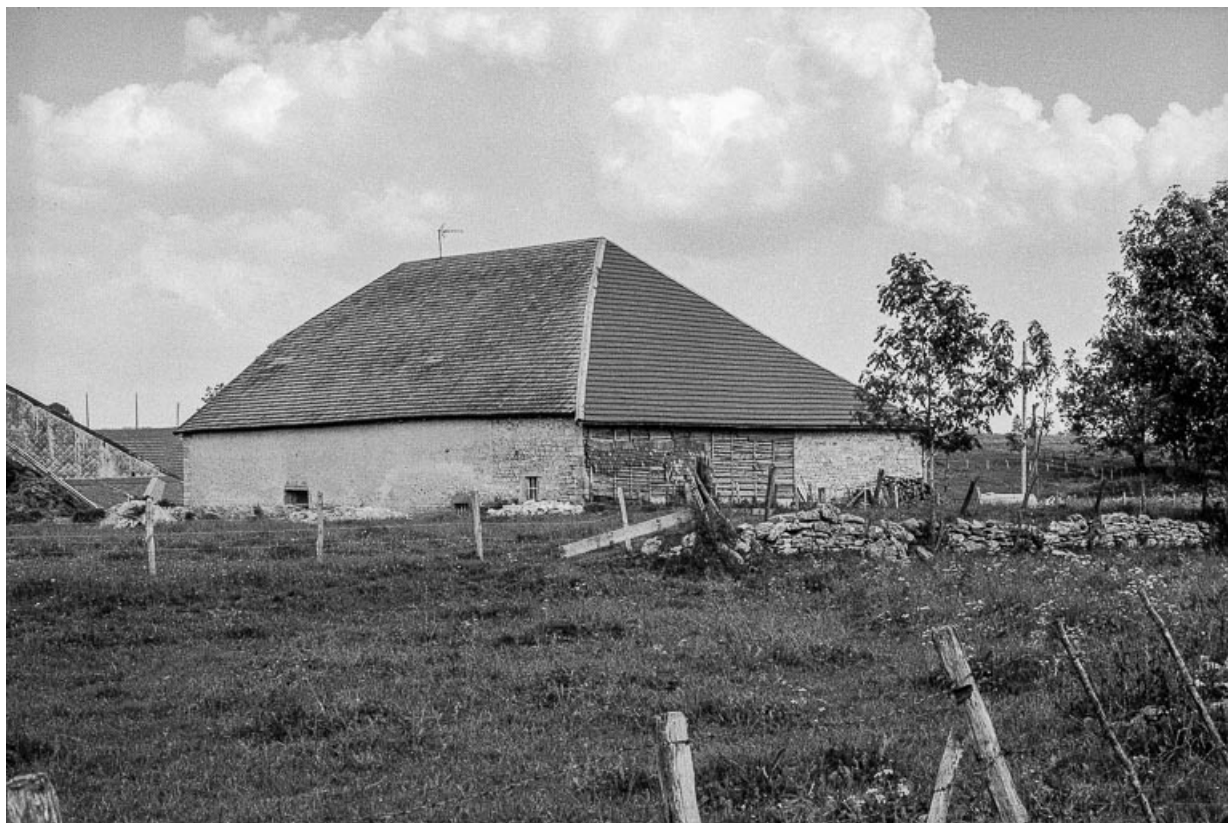
Ferme, cadastrée 1938 F 62 : façade postérieure. 25, Boujailles
