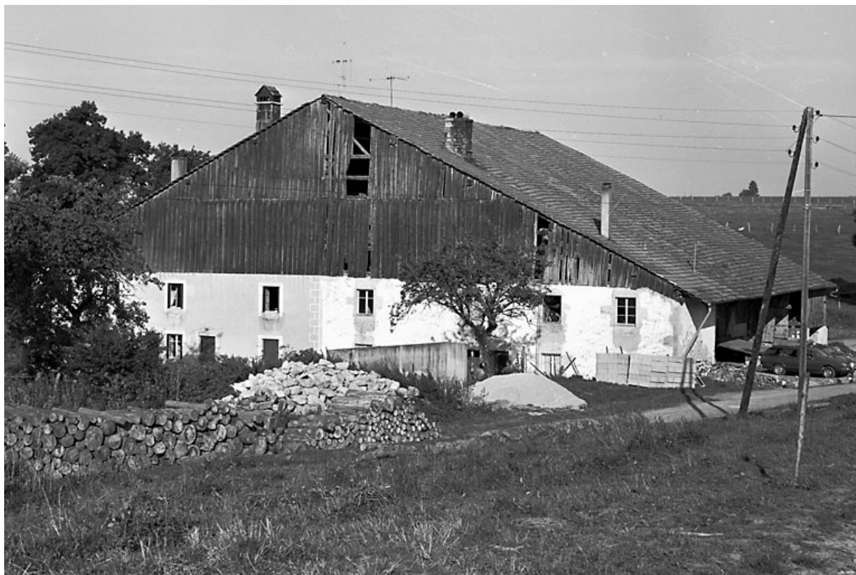
Façades antérieure et latérale droite.
