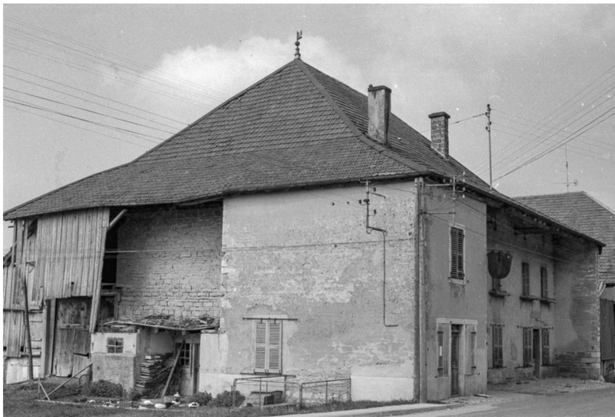
Façades antérieure et latérale gauche.
