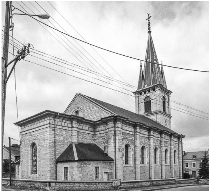
Façade latérale droite et chevet.
