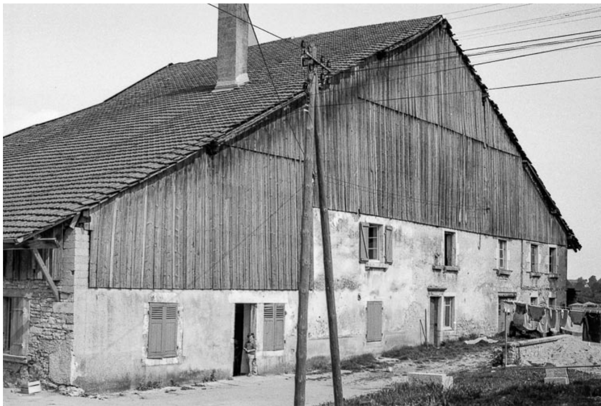
Ferme cadastrée 1964 D 131-133 : façade antérieure. 25, Bians-les-Usiers
