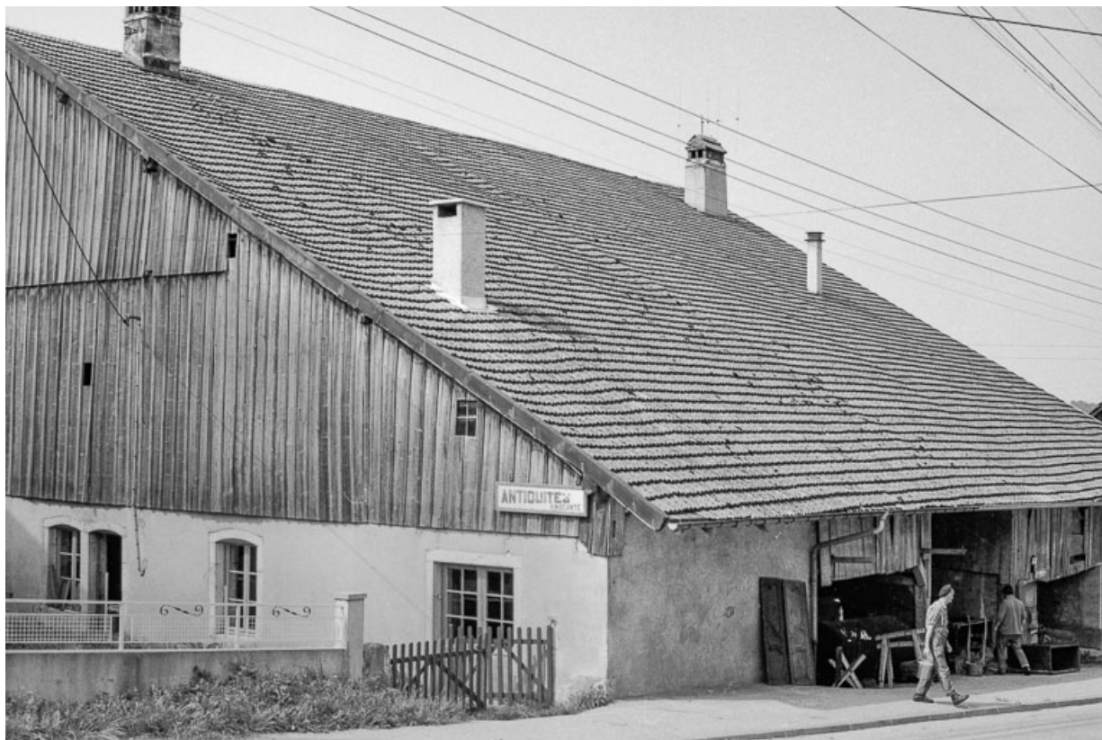
Ferme cadastrée 1964 D 131-133 : façades antérieure et latérale gauche. 25, Bians-les-Usiers
