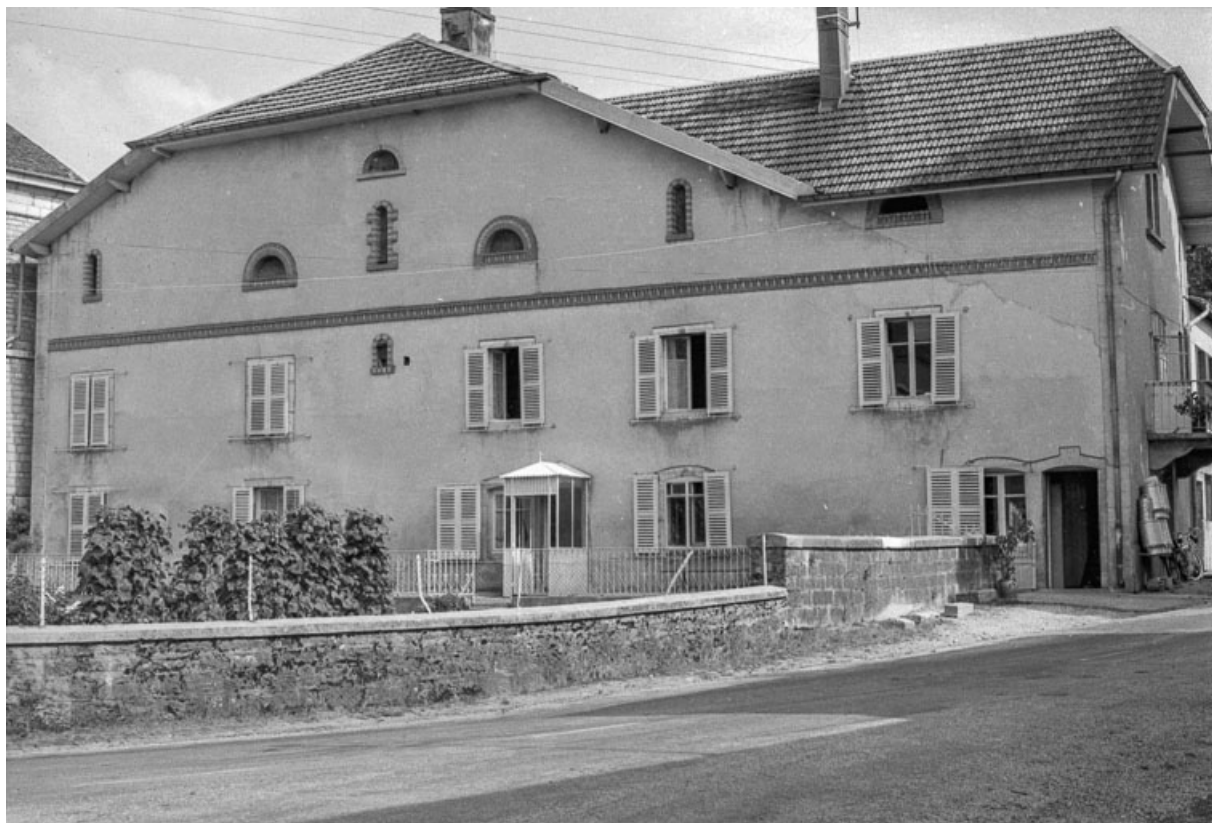
Ferme située route de la Forêt : façade antérieure.
