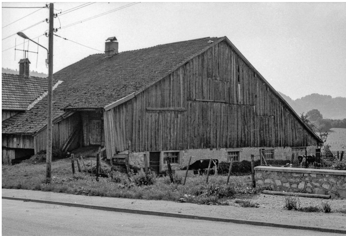
Ferme : façade latérale droite.
