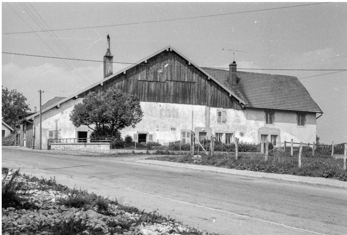
Ferme cadastrée 1973 ZE 31a : façade antérieure. 25, Bians-les-Usiers
