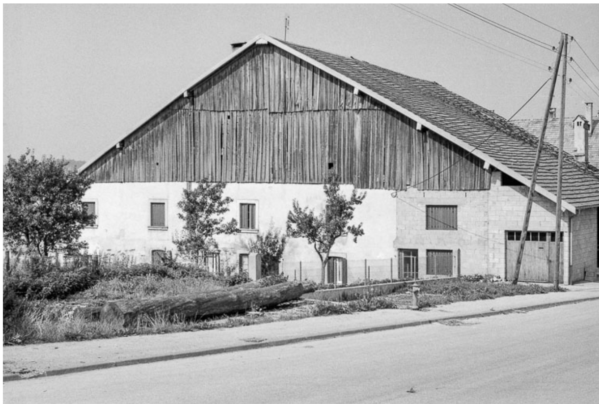
Ferme cadastrée 1964 D 24 : façades antérieure et latérale droite. 25, Bians-les-Usiers
