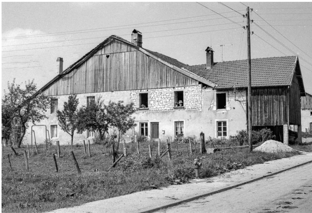
Ferme : façade antérieure. 25, Bians-les-Usiers
