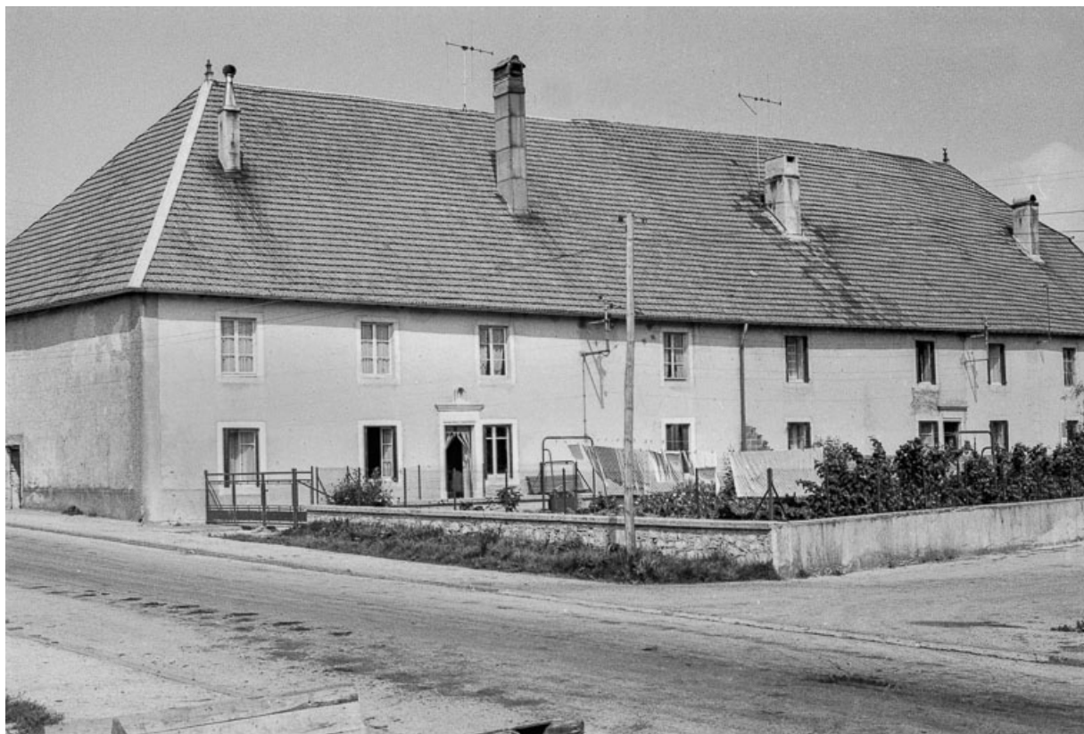
Maison cadastrée 1973 ZE 48 : façade antérieure. 25, Bians-les-Usiers
