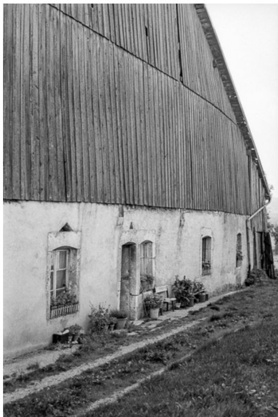
Ferme cadastrée 1964 D 143 : façade latérale. 25, Bians-les-Usiers
