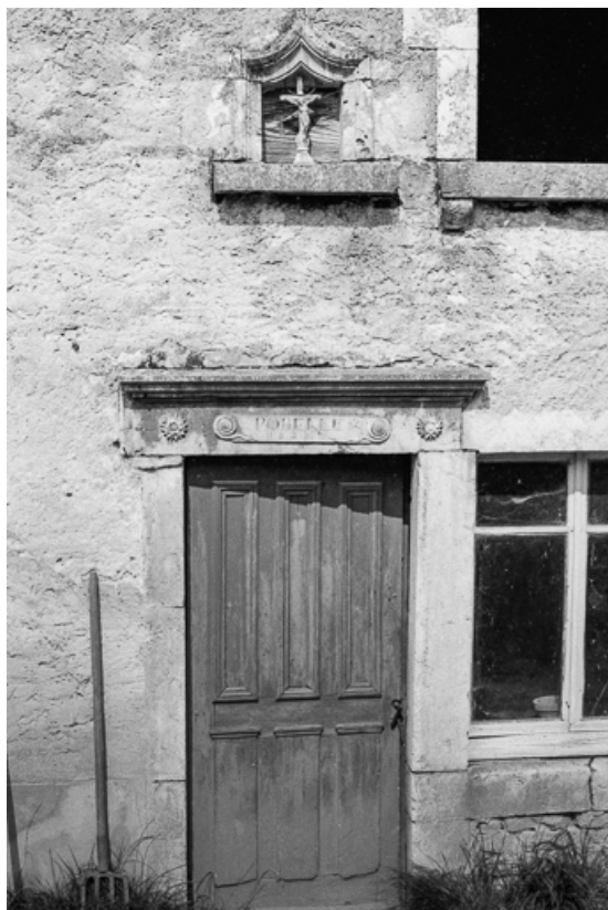
Ferme cadastrée 1964 D 25, 31, 31 bis, 33 : linteau de la porte d'entrée surmonté d'une niche et d'une inscription. 25, Bians-les-Usiers
