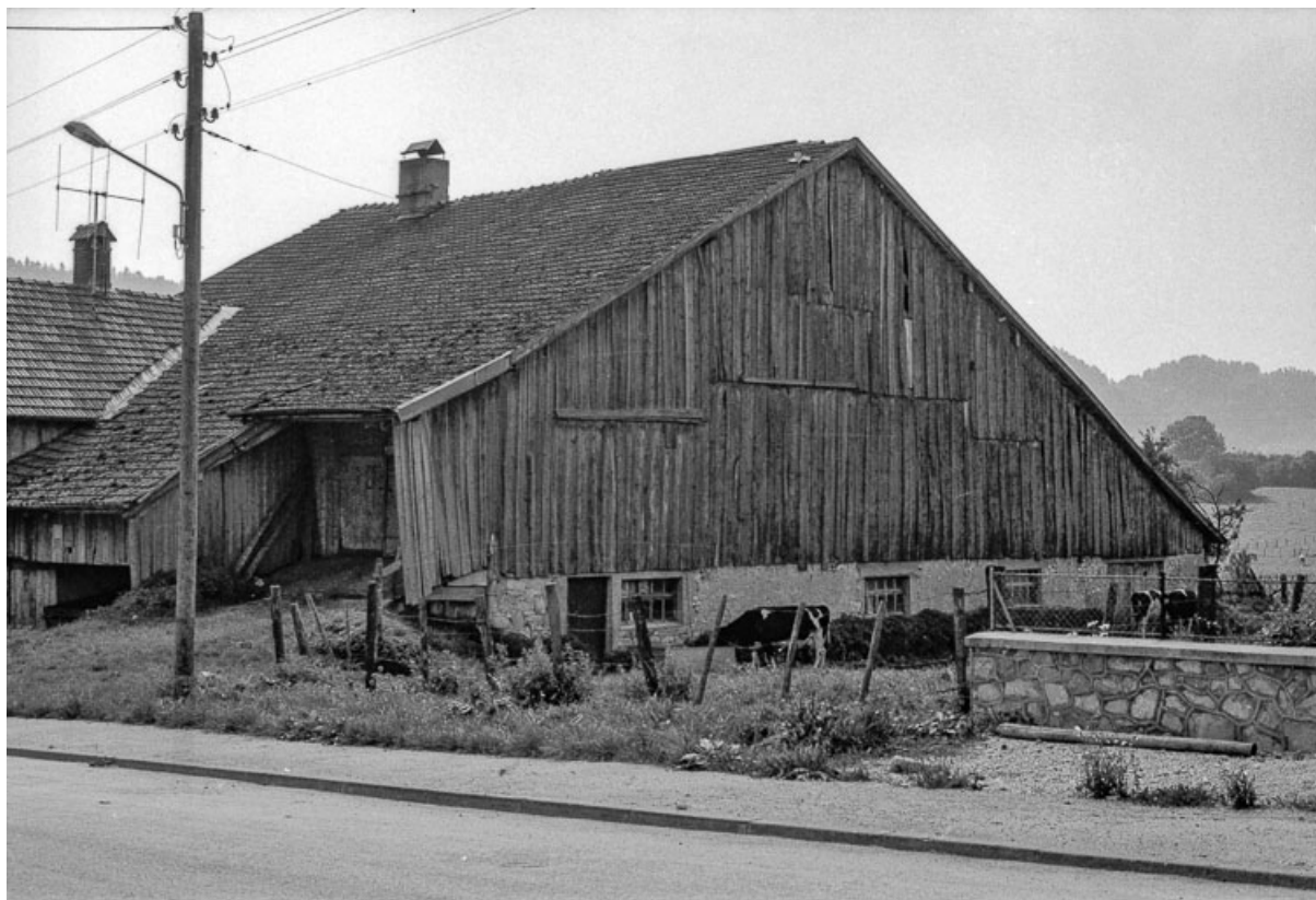
Ferme : façade latérale droite.
