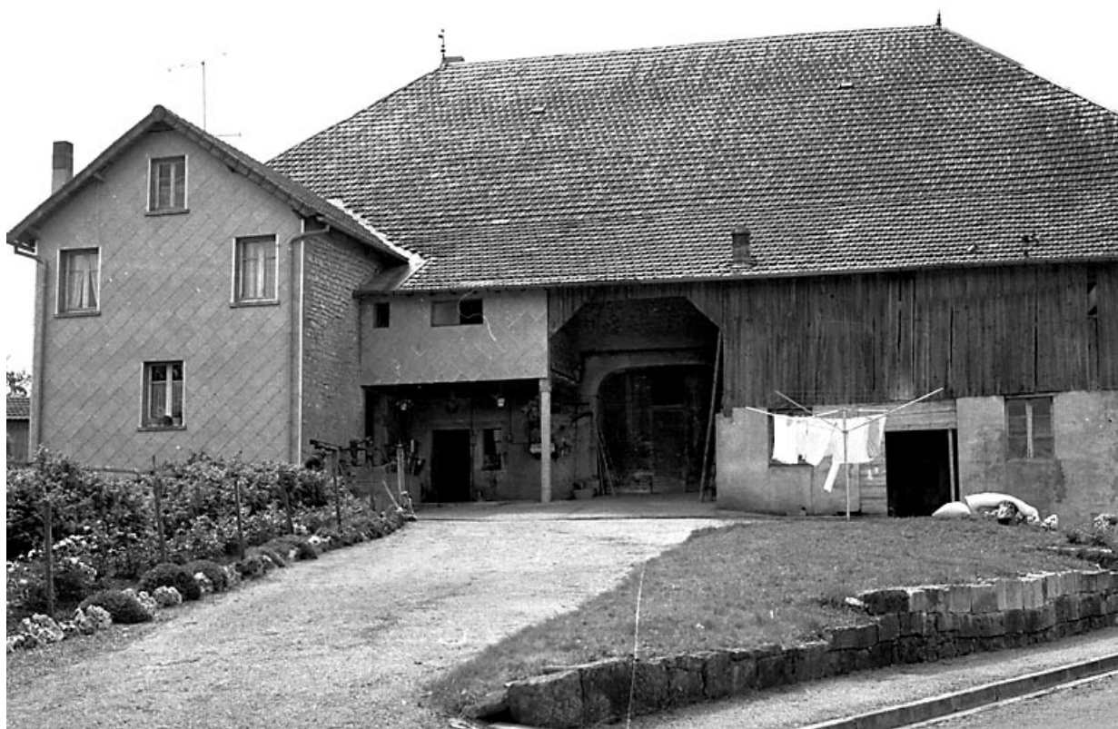
Vue du mur goutterot. 25, Arc-sous-Montenot
