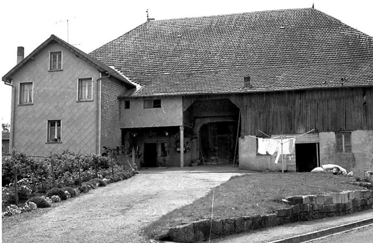
Vue du mur goutterot. 25, Arc-sous-Montenot
