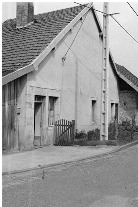
Ferme cadastrée 1961 AB 129-130, située rue du Bois Brûlé : façade antérieure. 25, Arc-sous-Montenot
