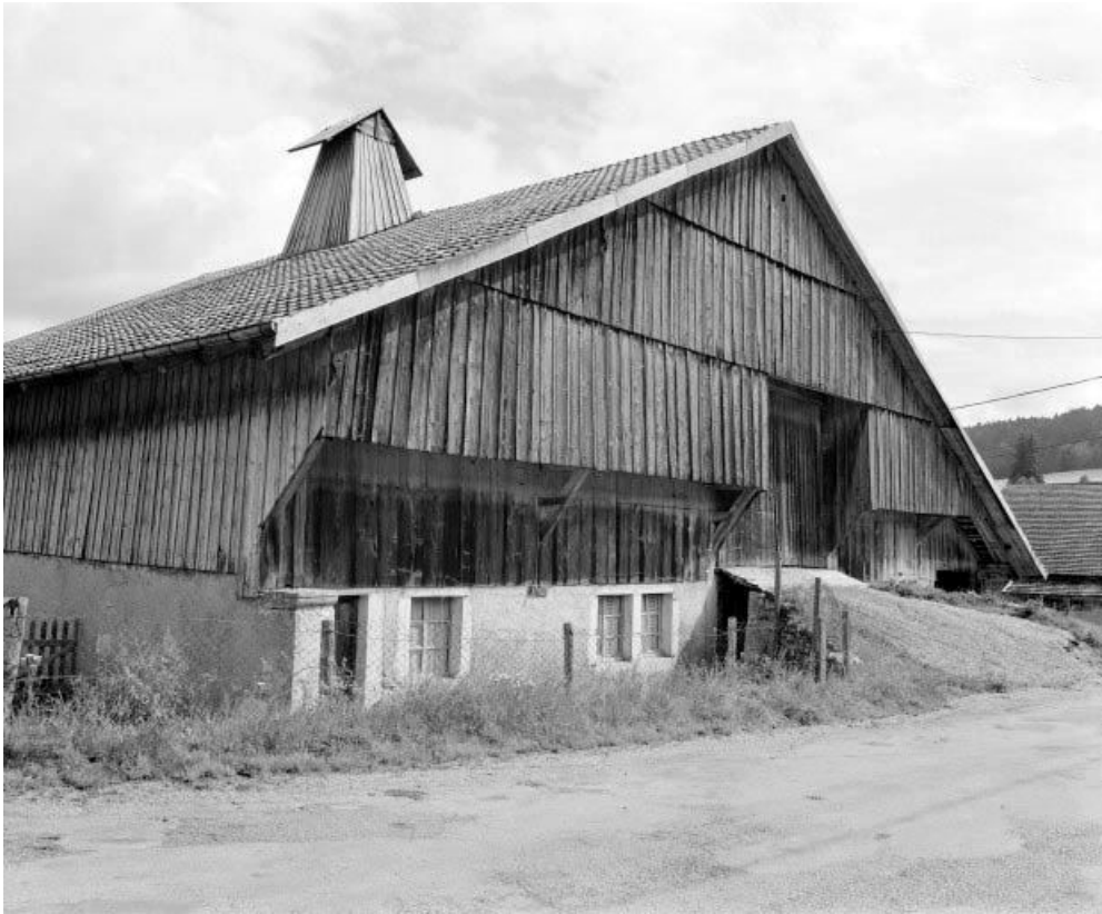
Façade sur rue, vue de trois quarts gauche.
