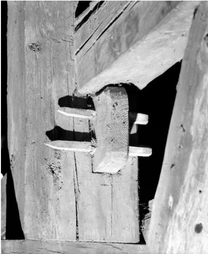
Détail : assemblage de charpente.
