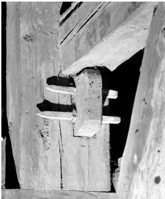
**Détail : assemblage de charpente.**
