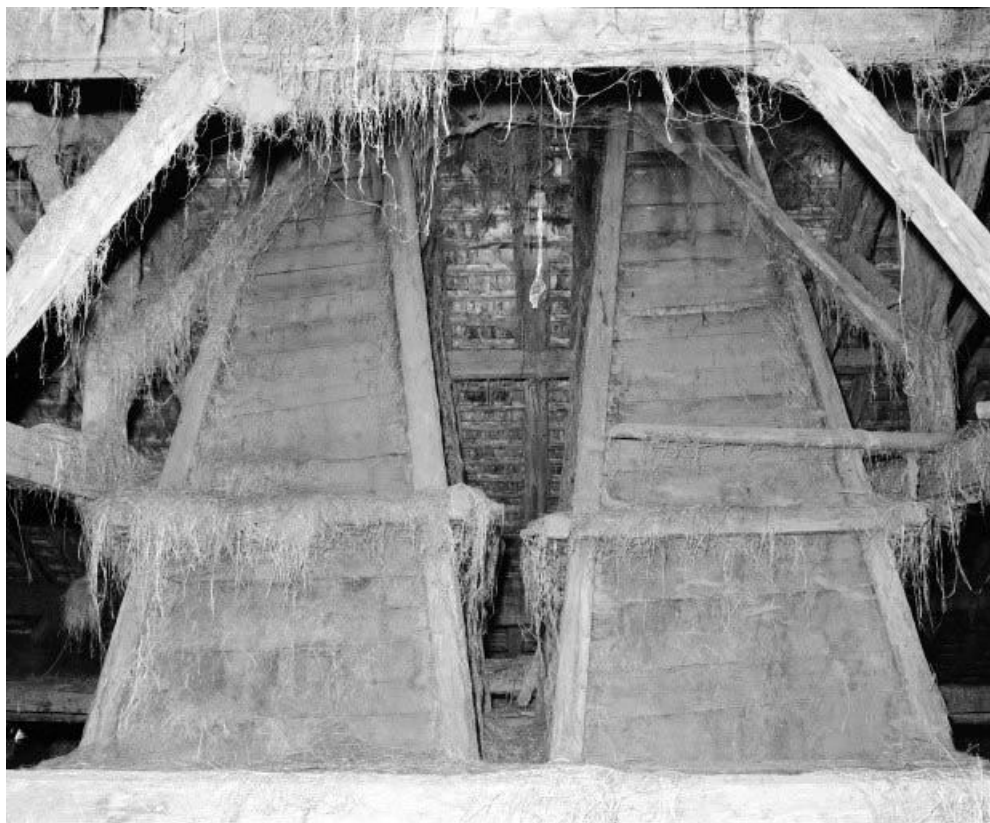
Conduits des "tués"jumelés dans la grange, de face.
