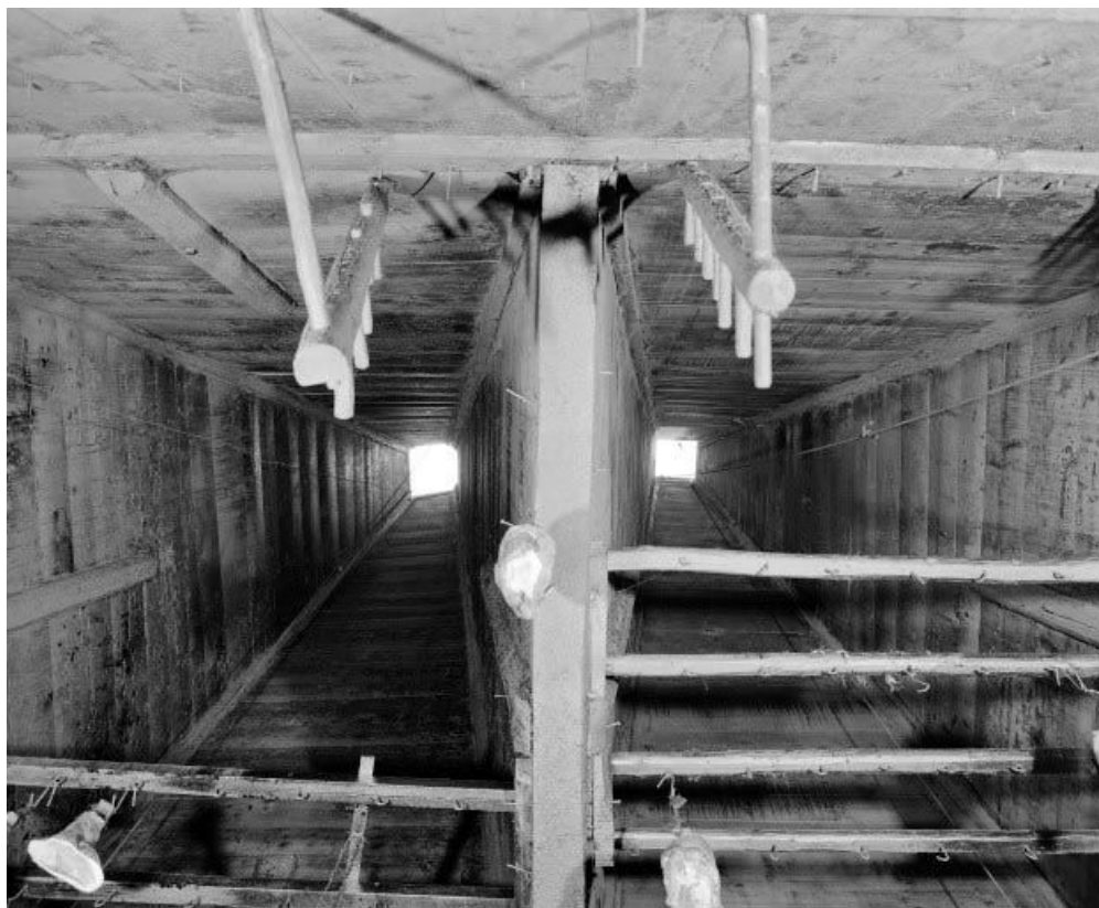
Intérieur : conduit des "tués"jumelés.
