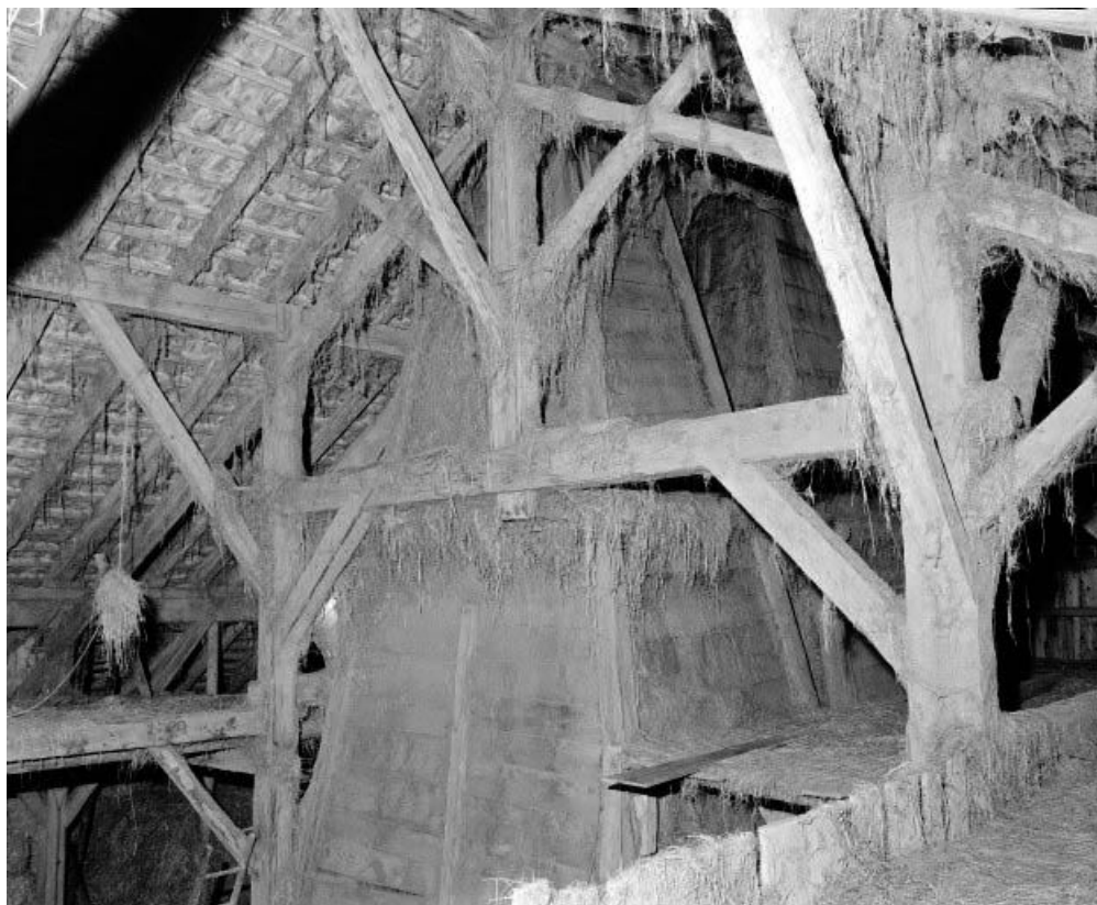
Charpente et conduits des "tués"jumelés, vus de trois quarts.
