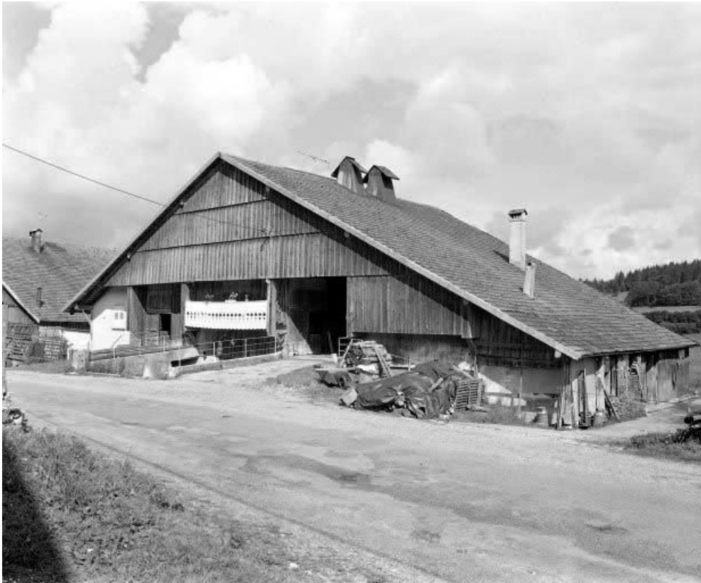
Façades antérieure et latérale droite. 25, Ville-du-Pont
