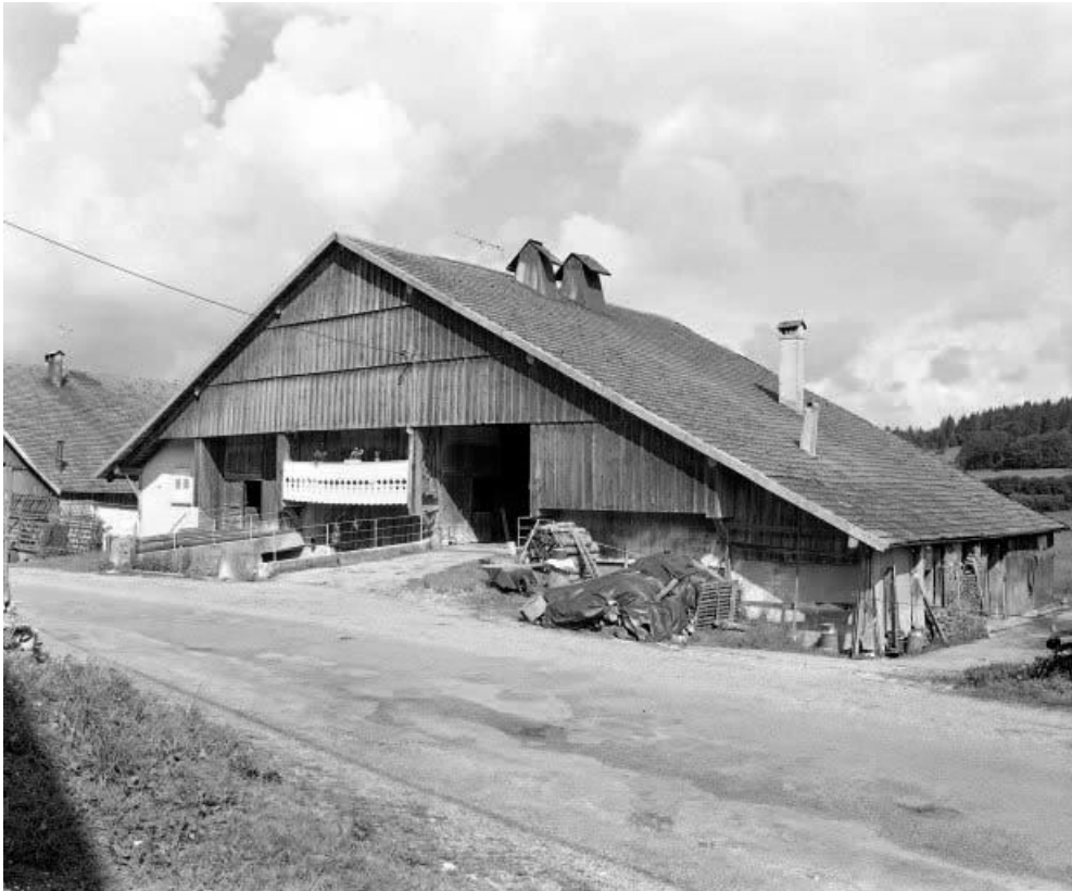
Façades antérieure et latérale droite. 25, Ville-du-Pont
