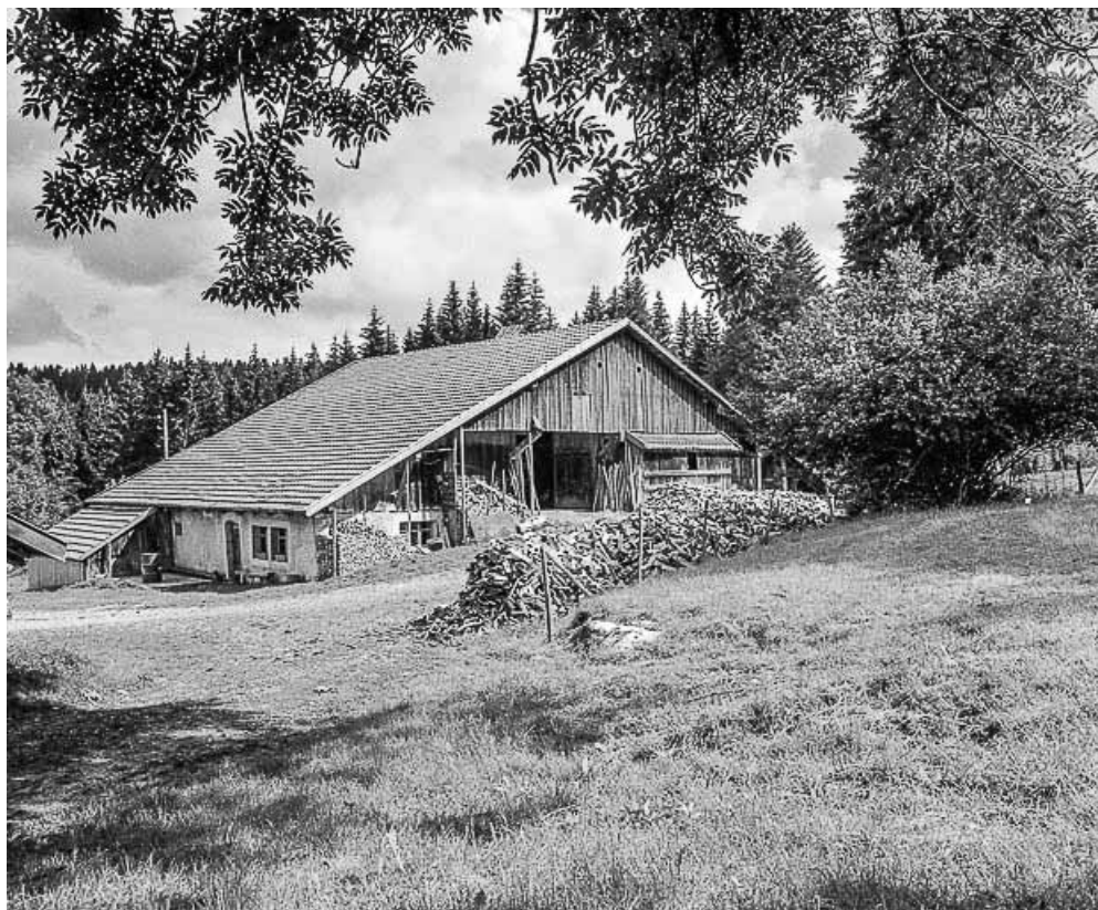
Ferme 1 : façade postérieure.
