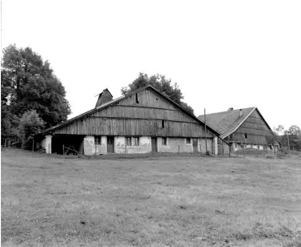
Ferme 1 et 2 : façades antérieures. 25, Ville-du-Pont
