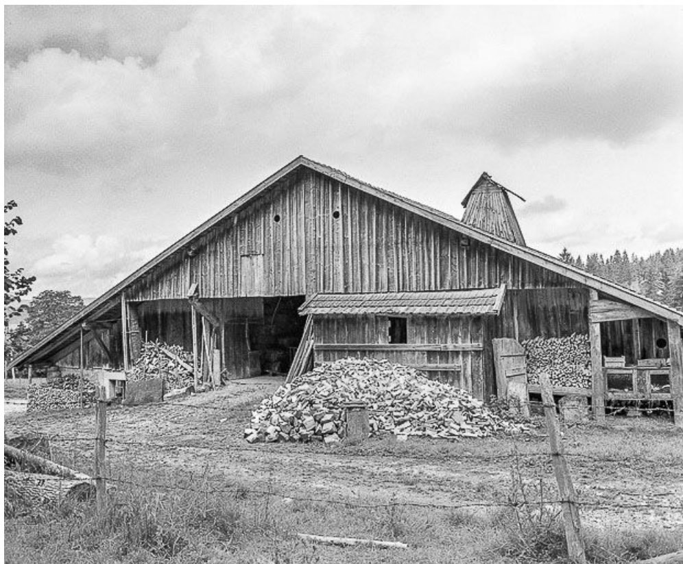
Ferme 2 : façade postérieure.
