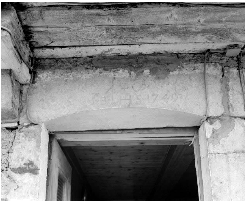
Ferme 2 : linteau de la porte d'entrée.
