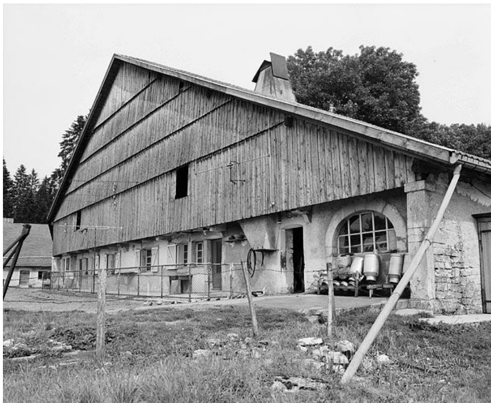
Ferme 2 : pignon antérieur, vu de trois quarts droit.
