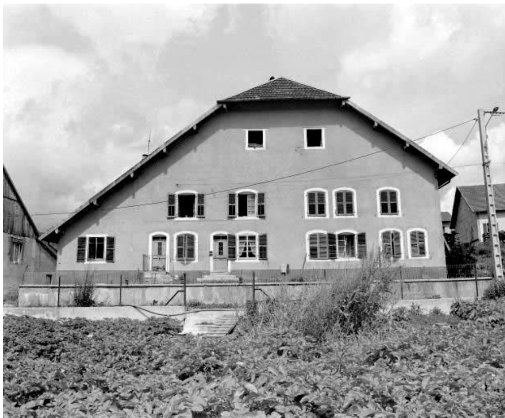
Pignon habitation vu de face.
