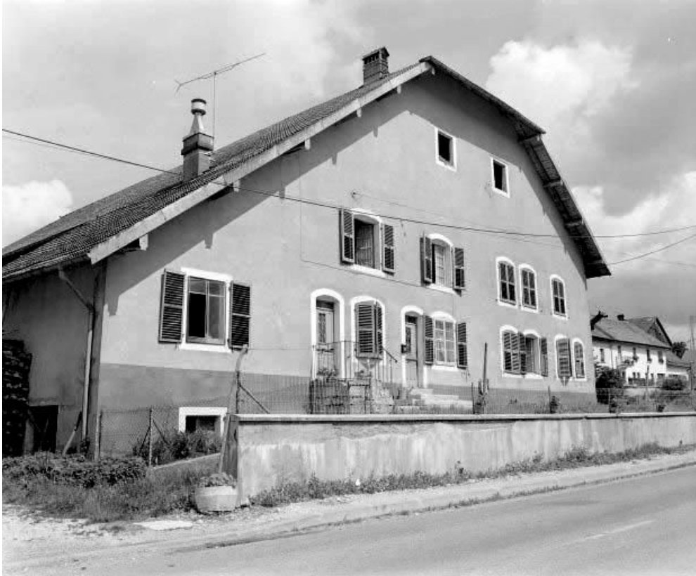
Pignon habitation vu de trois quarts. 25, Ville-du-Pont
