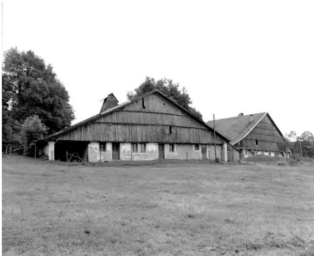
Ferme 1 et 2 : façades antérieures. 25, Ville-du-Pont
