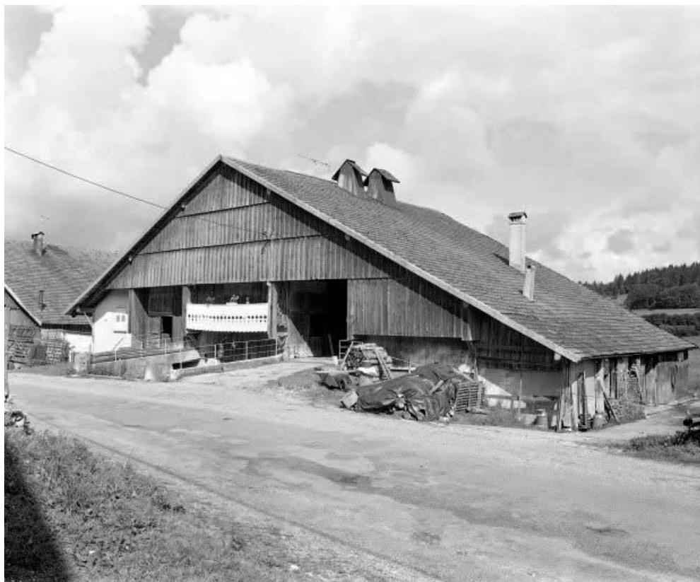
Façades antérieure et latérale droite. 25, Ville-du-Pont
