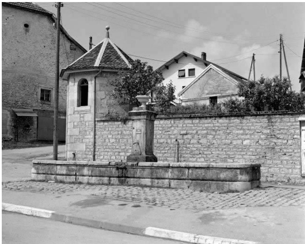
Mur c'enclos et pavillon d'angle..
