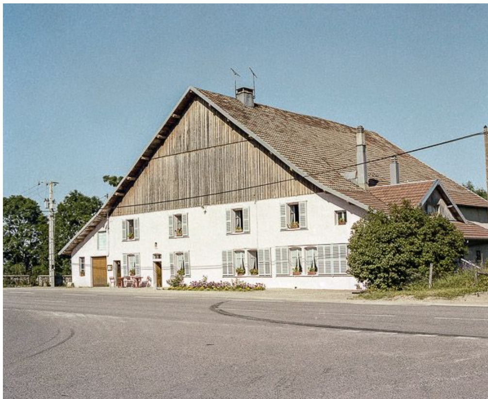
Ferme : façade antérieure.
