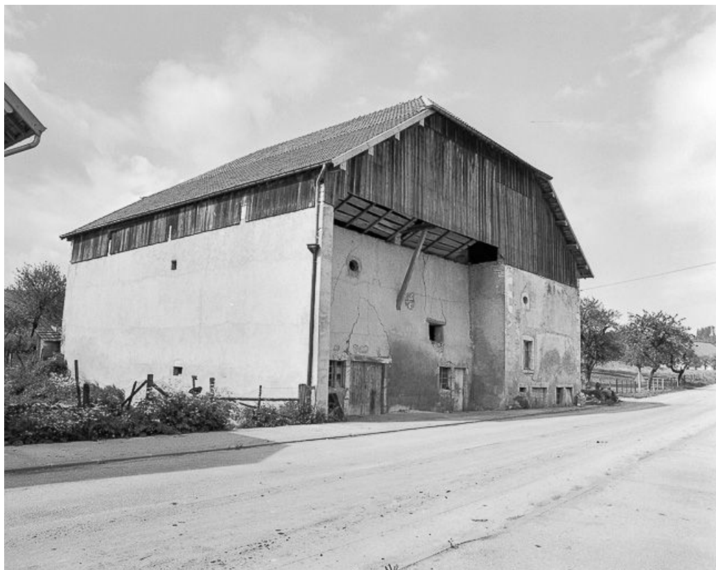
Ferme : façades postérieure et latérale gauche. 25, Ouhans
