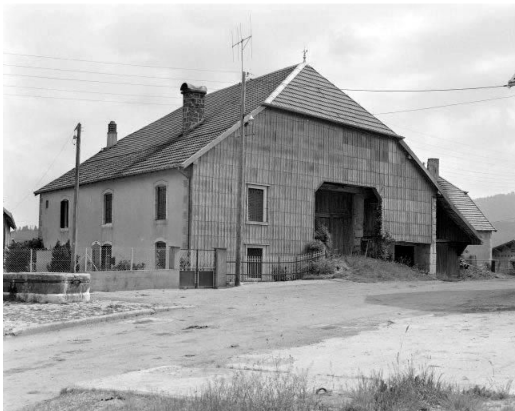
Façades antérieure et latérale droite.
