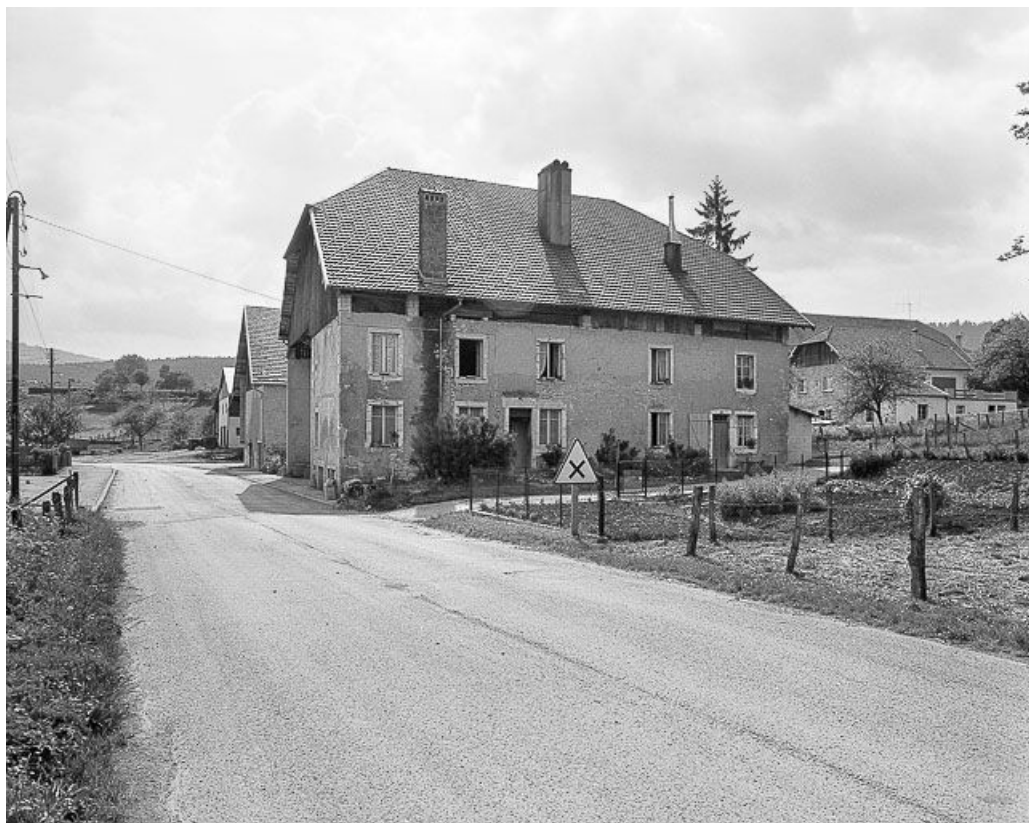
Ferme : façade antérieure. 25, Ouhans
