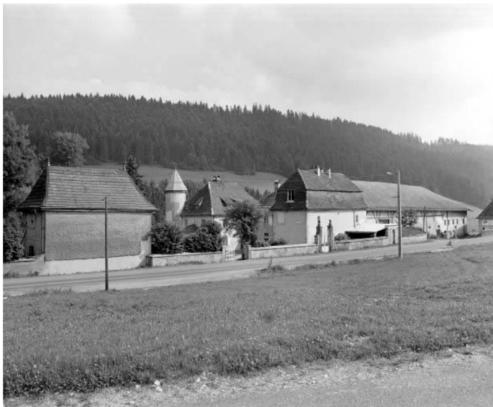
Façades sur rue. 25, Montbenoît
