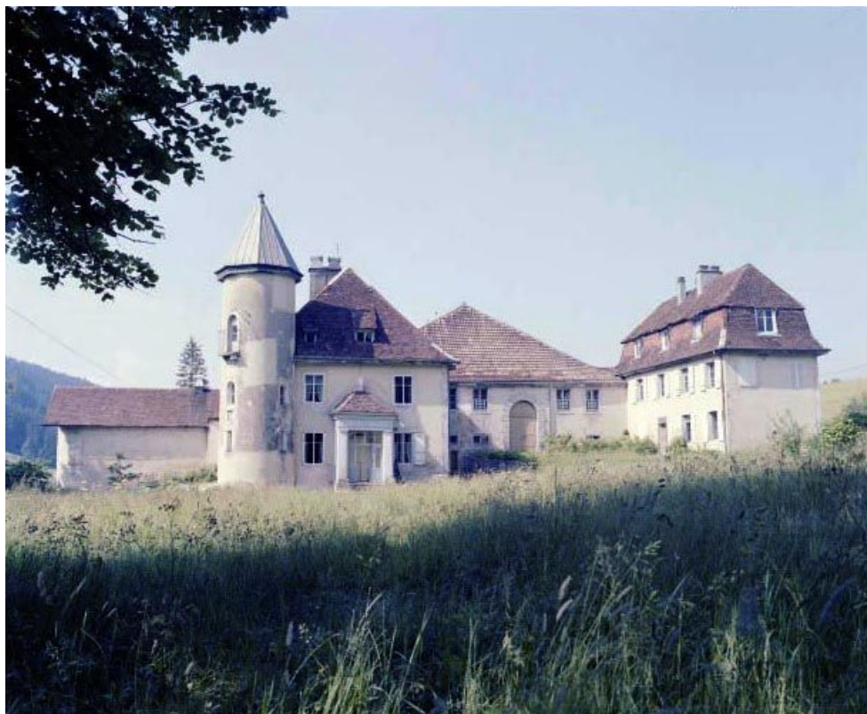
Façades sur le parc, vues de face.
