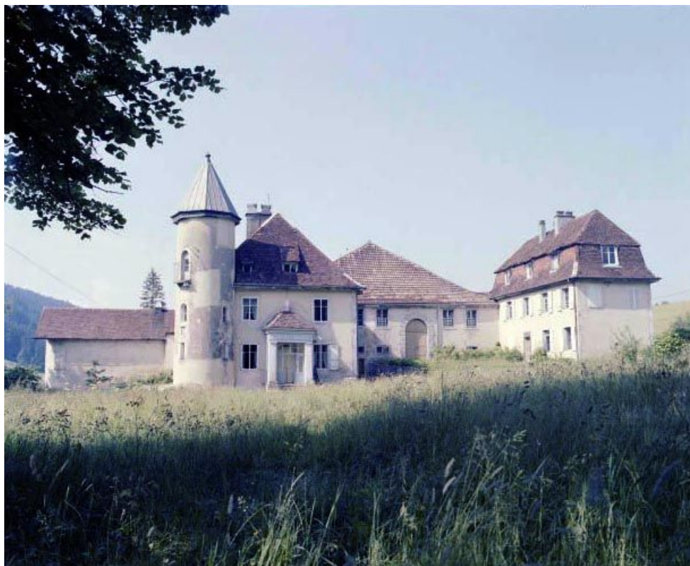
Façades sur le parc, vues de face.
