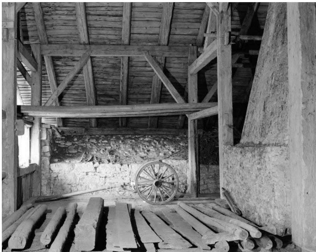
Grange et extradors de la voûte de cave.
