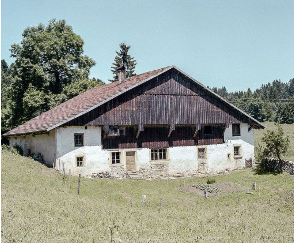
Façades antérieure et latérale droite. 25, Maisons-du-Bois-Lièvremont
