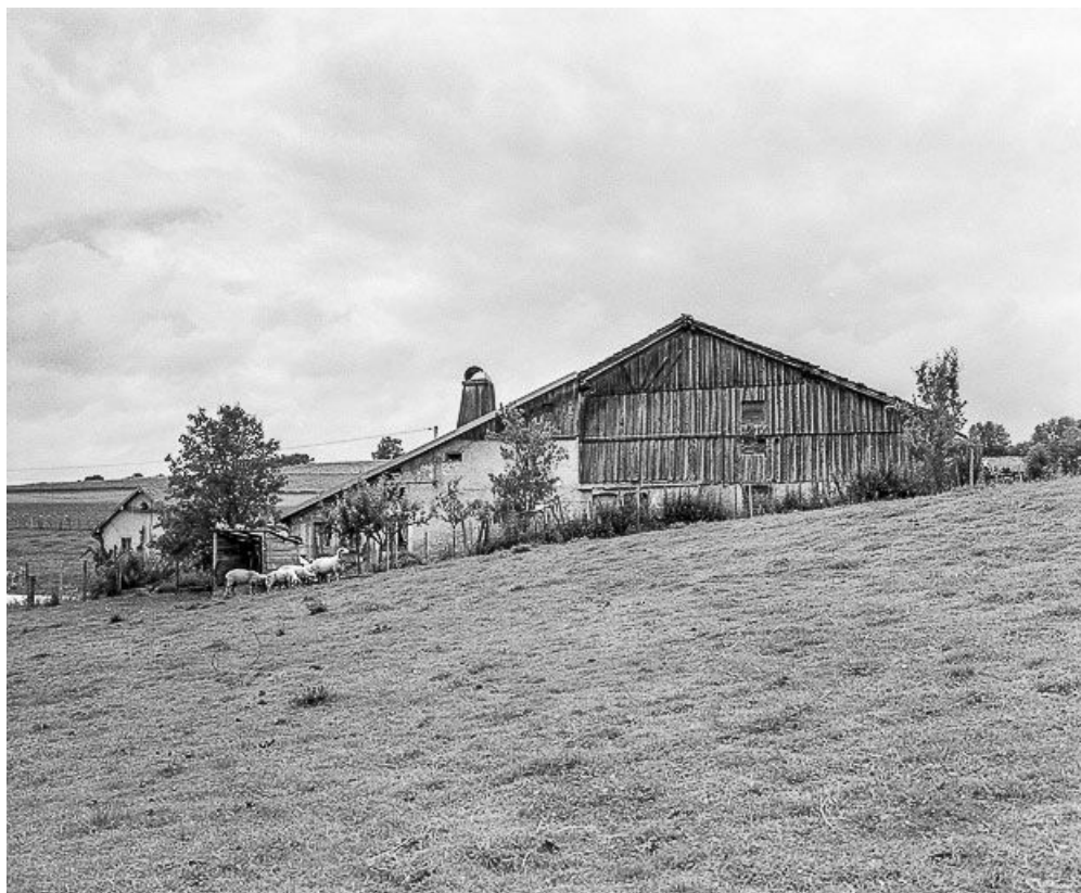
Ferme située à Maisons-du-Bois : façade antérieure, vue de face. 25, Maisons-du-Bois-Lièvremont
