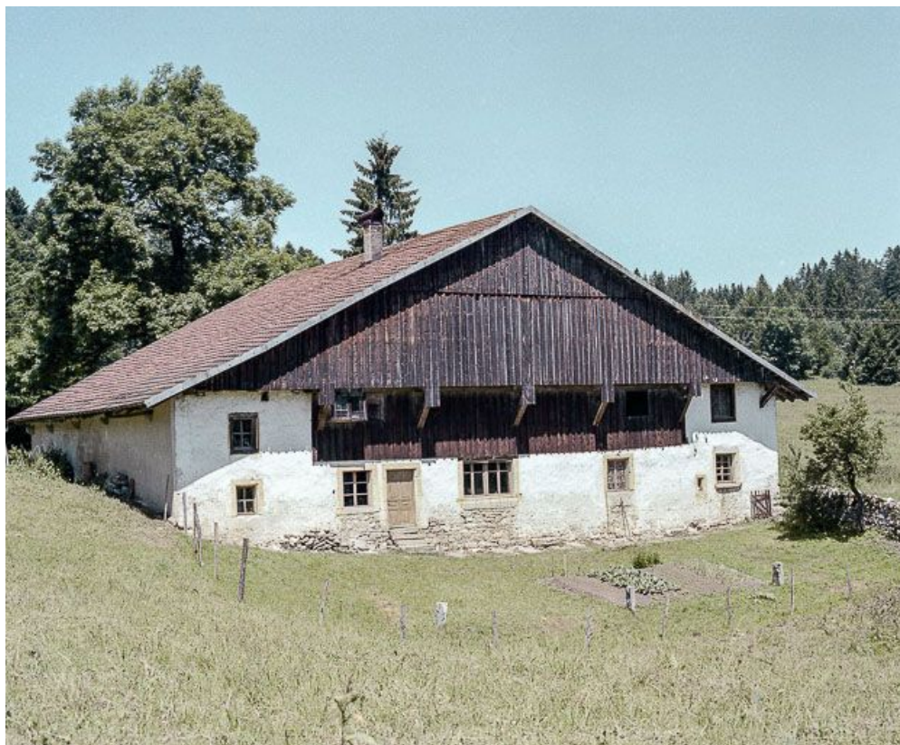
Façades antérieure et latérale droite. 25, Maisons-du-Bois-Lièvremont
