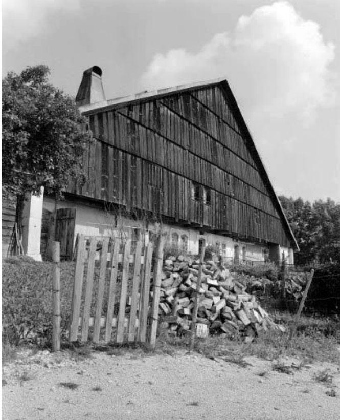
Pignon habitation vu de trois quarts gauche.
