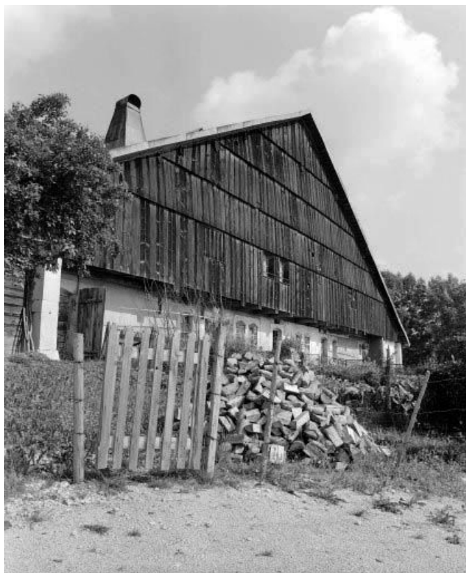
Pignon habitation vu de trois quarts gauche.
