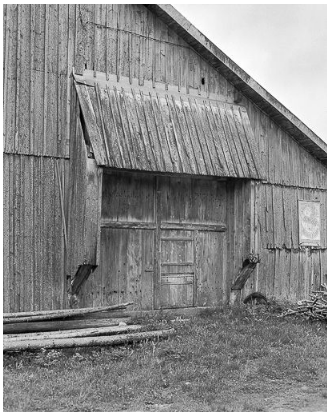
Ferme située au lieudit l'Etravers : porte de grange. 25, La Longeville
