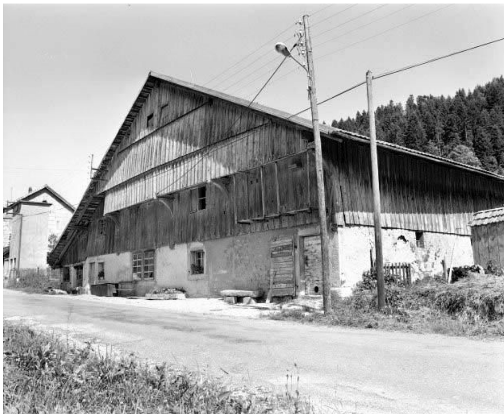
Façade antérieure vue de trois quarts droit. 25, Hauterive-la-Fresse
