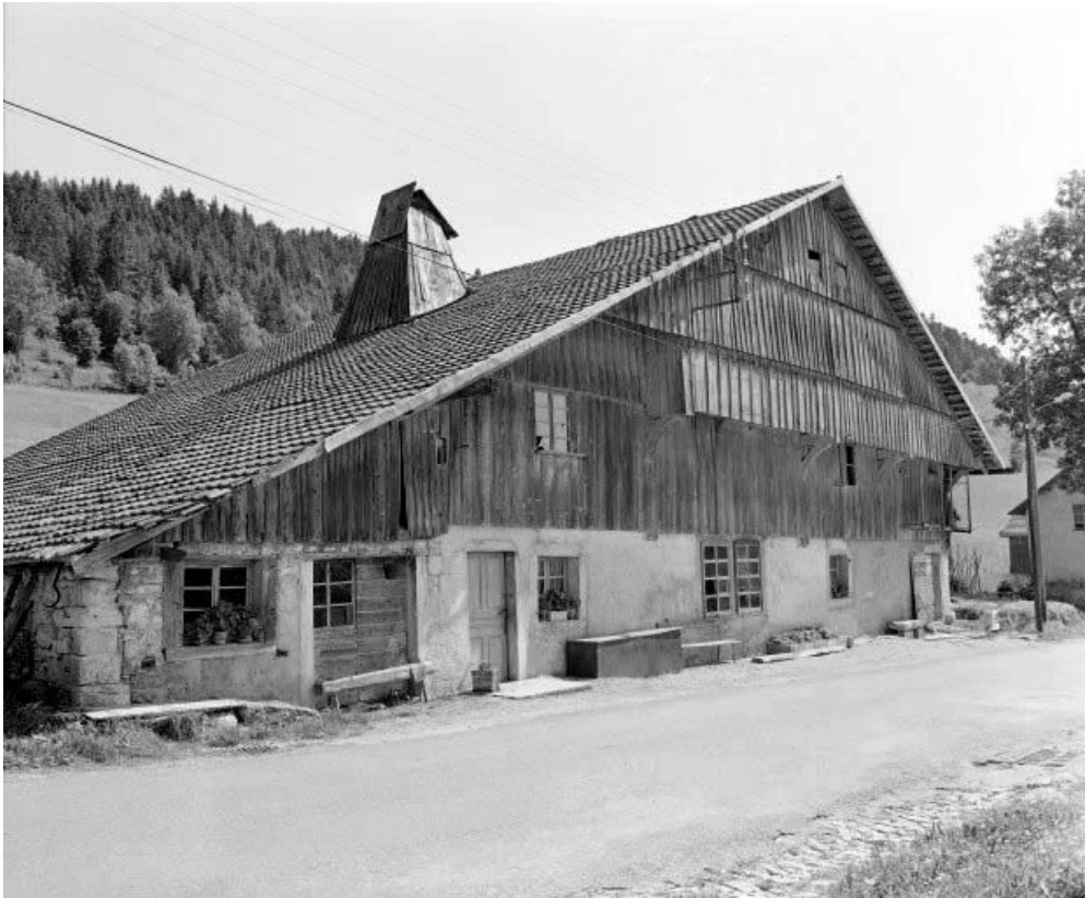
Façade antérieure vue de trois quarts gauche.
