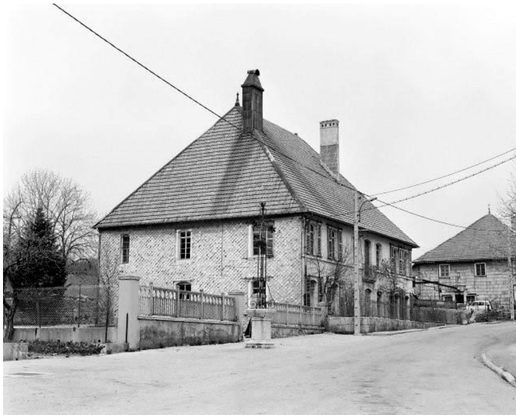
Façades antérieure et latérale gauche.
