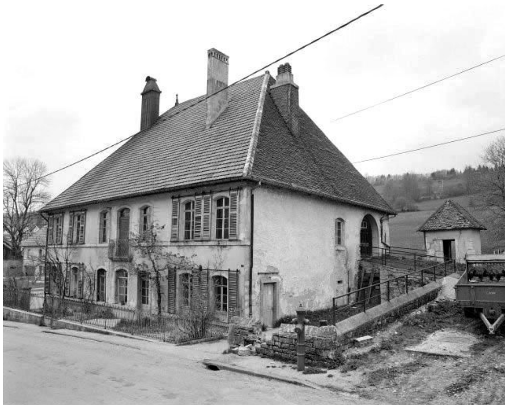
Façades antérieure et latérale droite.
