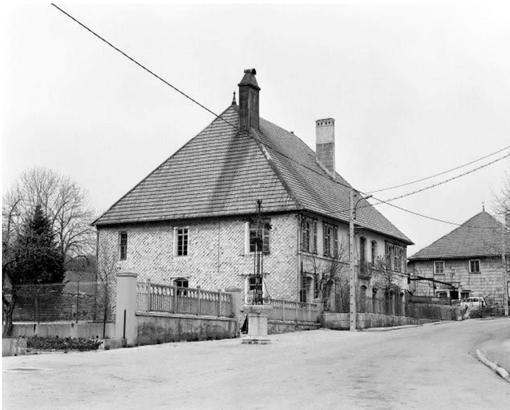
Façades antérieure et latérale gauche. 25, Gilley, 1 rue Pasteur
