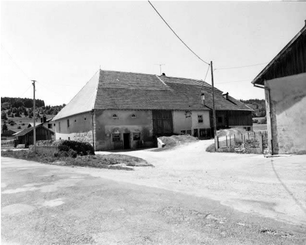
Façade antérieure vue de trois quarts gauche. 25, La Chaux
