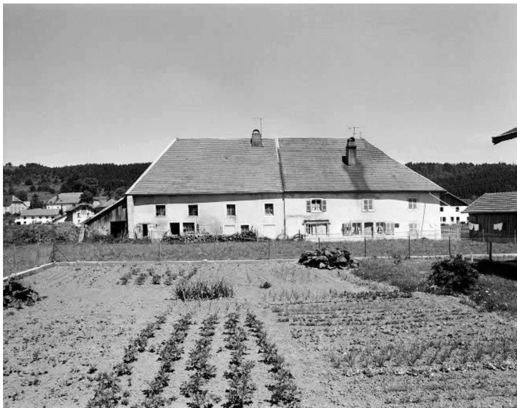
Façade postérieure. 25, La Chaux
