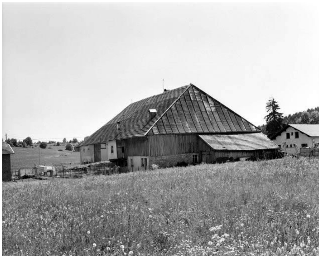
Façade antérieure et face latérale droite. 25, La Chaux
