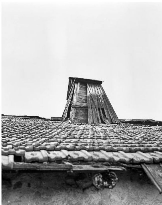
Ferme à "tué" : souche du "tué". 25, La Chaux
