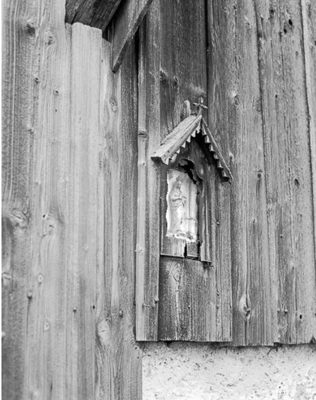
Ferme à "tué", détail de la façade : niche avec statuette. 25, La Chaux
