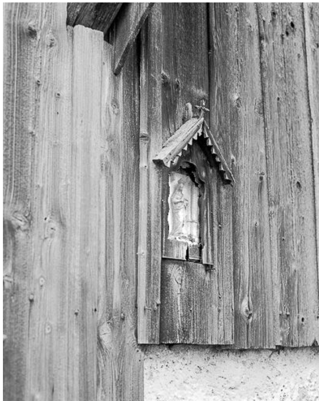
Ferme à "tué", détail de la façade : niche avec statuette. 25, La Chaux
