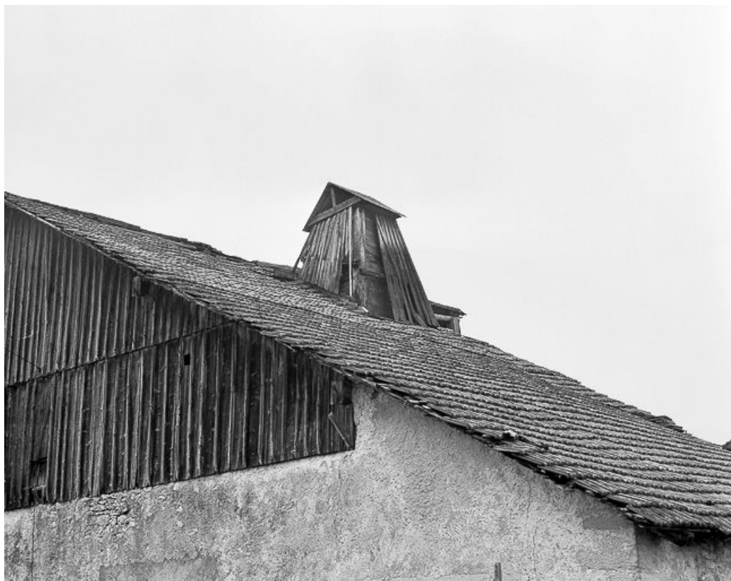
Ferme à "tué" : souche du "tué". 25, La Chaux
