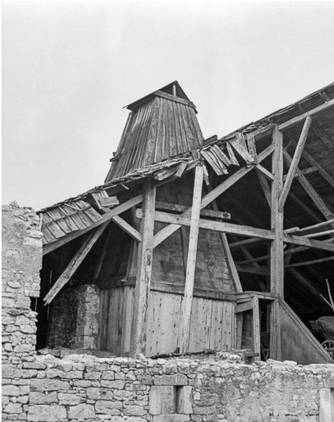
Ferme à "tué" : hotte du "tué" et charpente. 25, La Chaux
