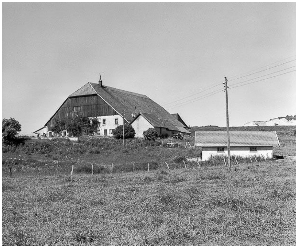
Ferme située au lieudit Le Gros Bugny : vue générale. 25, Bugny
