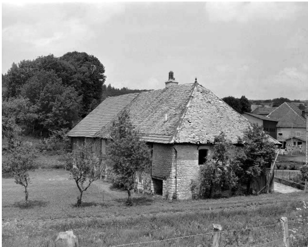
Façades postérieure et latérale gauche.
